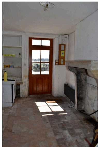
Vue intérieure de la cuisine. La pierre d'évier est placée à gauche de la porte contre le mur gouttereau, sous un renforcement à usage d'étagère de rangement. La cheminée est à droite contre le mur pignon ouvrant auparavant sur le four à pain.. Phot. Cécile Breton IVR84_20230300526NUC4A
