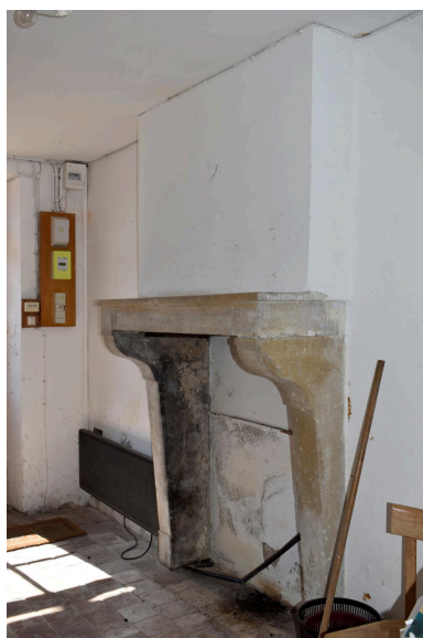
Vue de la cheminée de la cuisine. Phot. Cécile Breton IVR84_20230300522NUC4A
