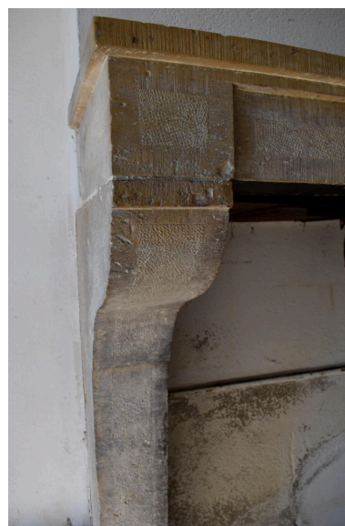
Détail de la cheminée de la cuisine. Phot. Cécile Breton IVR84_20230300524NUC4A
