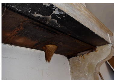
Détail de la cheminée de la cuisine. Phot. Cécile Breton IVR84_20230300523NUC4A
