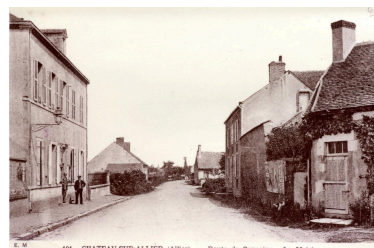
Vue partielle de la maison à droite, première moitié du 20e siècle. La couverture est de petites tuiles plates, une treille garnit la façade au sud, une des portes, coupée, est surmontée d'une imposte vitrée. "Vue du bourg sur la route de Sancoins" IVR84_20230300303NUCA
