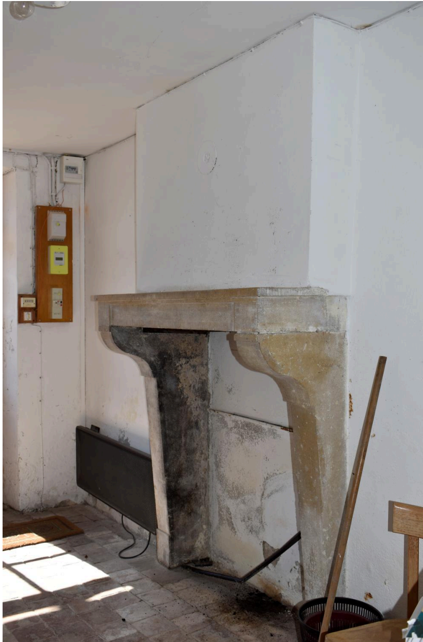
Vue de la cheminée de la cuisine.
