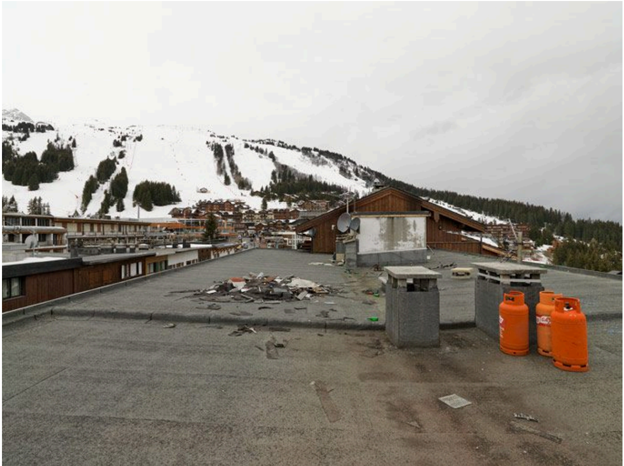
Toit terrasse d'un immeuble rue des Verdons
