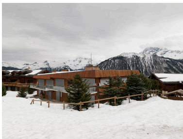
Résidence le Grand Charriot, quartier de Nogentil. Vue depuis la grenouillère au sud-ouest Phot. Eric Dessert IVR82_20107304294NUCA
