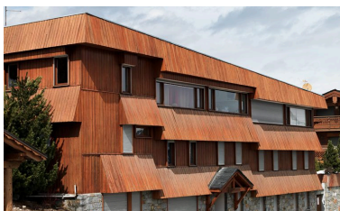
Résidence le Grand Charriot, angle sud-est Phot. Eric Dessert IVR82_20107304992NUCA
