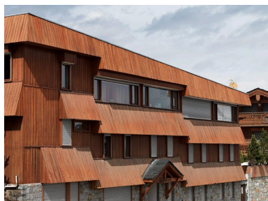
Résidence le Grand Charriot. Elévation est Phot. Eric Dessert IVR82_20107304297NUCA
