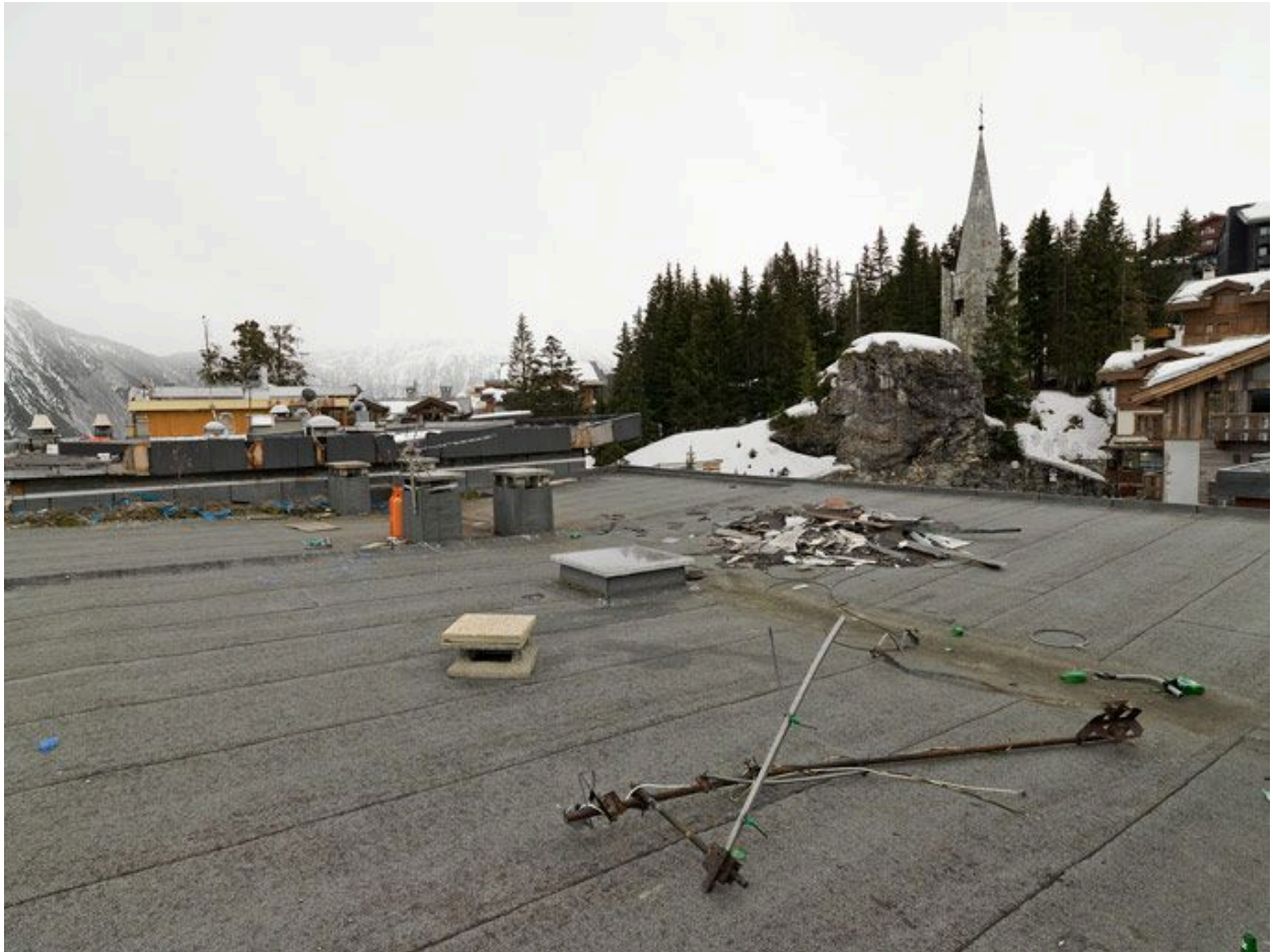
Toit terrasse d'un immeuble rue des Verdons
