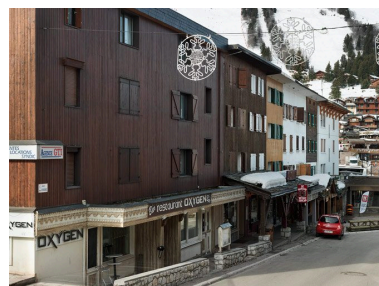
Immeubles, rue des Verdons Phot. Eric Dessert IVR82_20107304984NUCA
