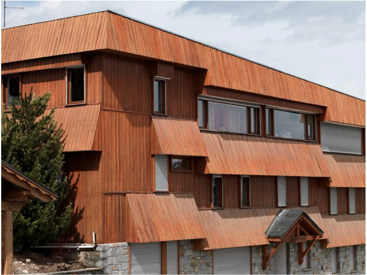
Résidence le Grand Charriot, angle sud-est
