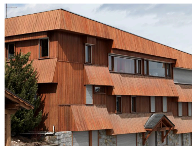
Résidence le Grand Charriot, angle sud-est Phot. Eric Dessert IVR82_20107304296NUCA
