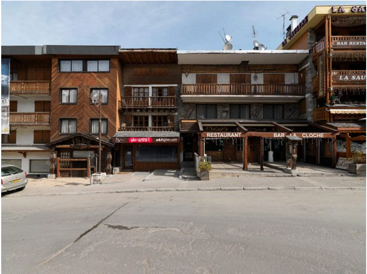
Les immeubles de la place du Rocher
