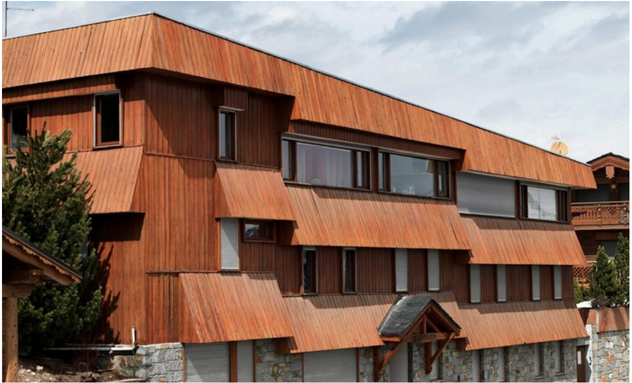
Résidence le Grand Charriot, angle sud-est
