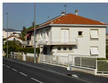
Deux habitations du début des années 1960, accolées, rue de Rochefeuille. Phot. Christian Parisey IVR84_20196300256NUC4A
