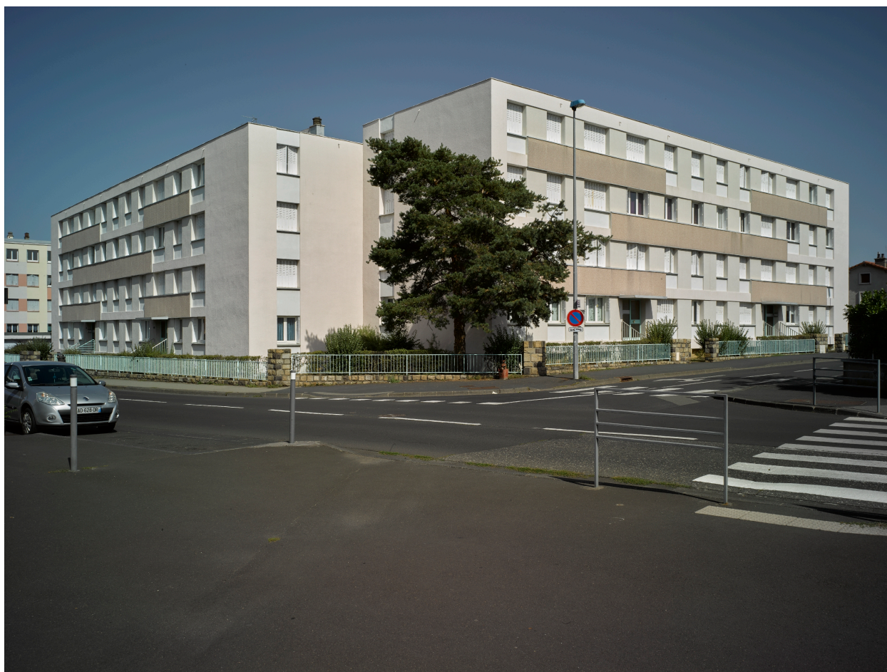
Deux immeubles collectifs du début des années 1960, à l'angle de la rue des Meuniers et de la rue de Rochefeuille.
