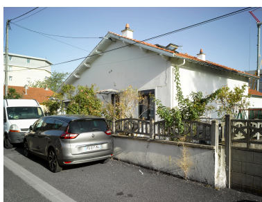
Habitation des années 1952-1953, construite en mode "Castor", dans l'impasse de l'allée des Primevères. Phot. Christian Parisey IVR84_20196300255NUC4A
