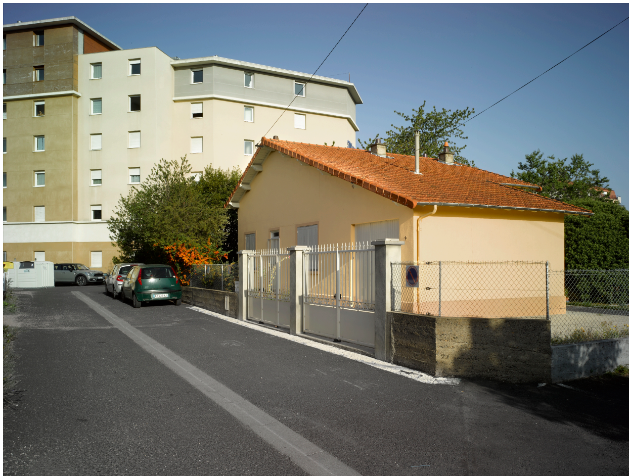
Une maison "Castor" (1952-1953), dans l'impasse de l'allée des Primevères.
