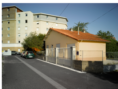
Une maison "Castor" (1952-1953), dans l'impasse de l'allée des Primevères. Phot. Christian Parisey IVR84_20196300254NUC4A
