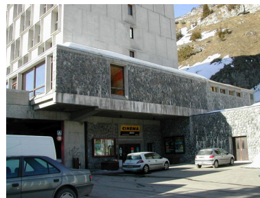
Pignon est. L'entrée du cinéma au rez-de-chaussée Phot. Jean-François Lyon-Caen, Phot. C. Salomon-Pelen IVR82_20117402100NUCA
