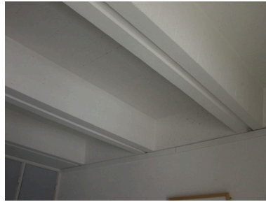
Une chambre. Détail du plafond Phot. Jean-François Lyon-Caen, Phot. C. Salomon-Pelen IVR82_20117402112NUCA
