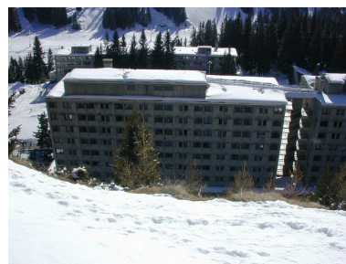
Vue générale depuis le nord Phot. Jean-François Lyon-Caen, Phot. C. Salomon-Pelen IVR82_20117402099NUCA
