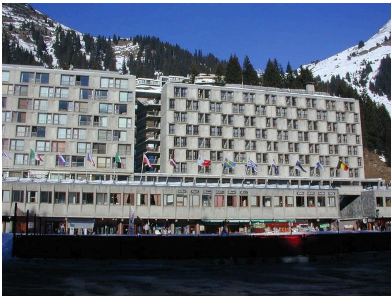
Vue générale depuis le sud. Au 1er plan la galerie marchande, à gauche la résidence Cassiopée
