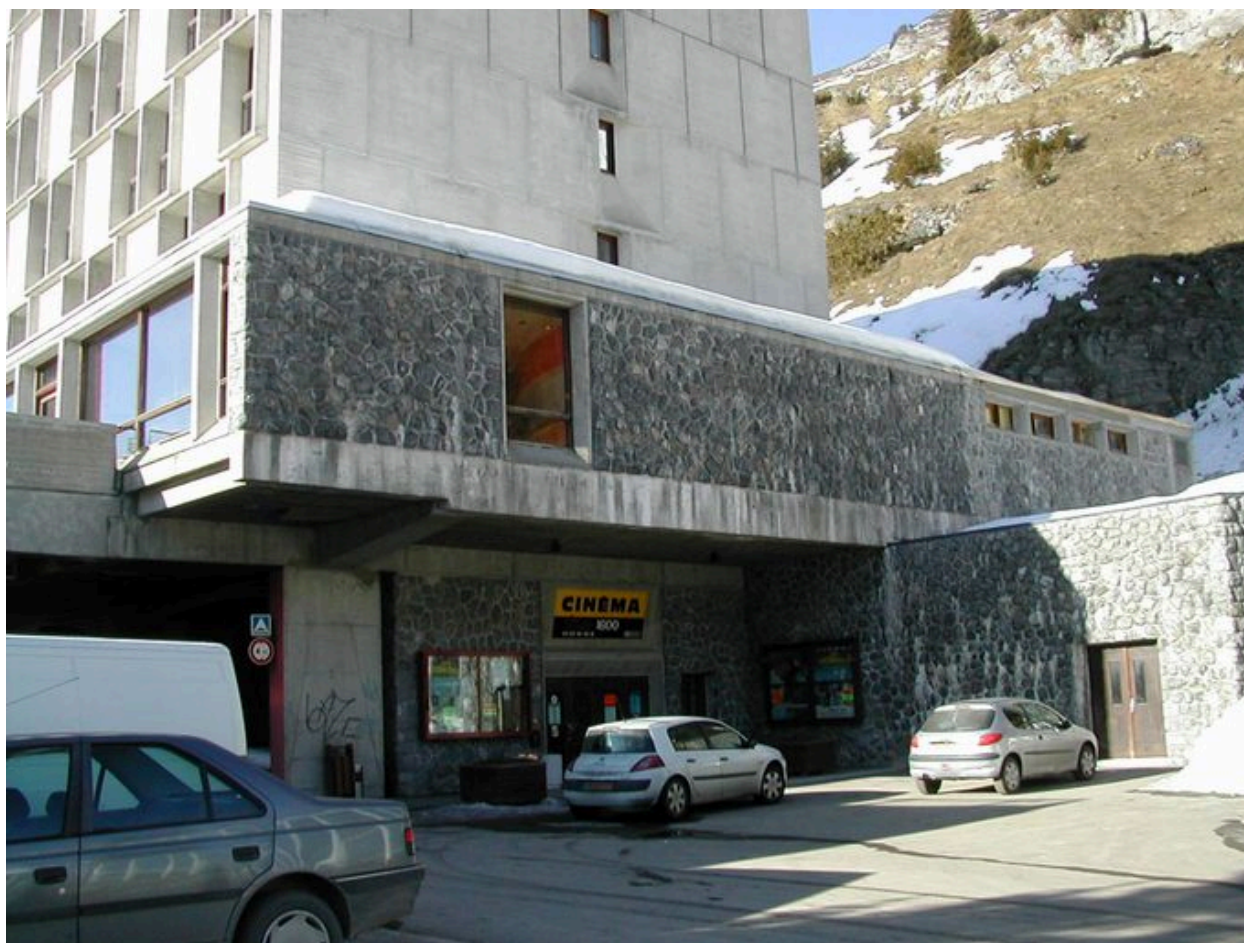
Pignon est. L'entrée du cinéma au rez-de-chaussée
