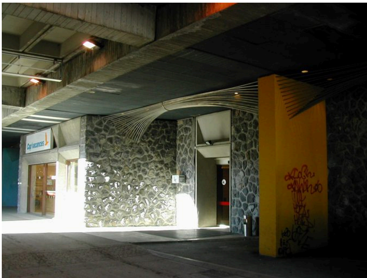
Entrée de l'hôtel sous la rue couverte
