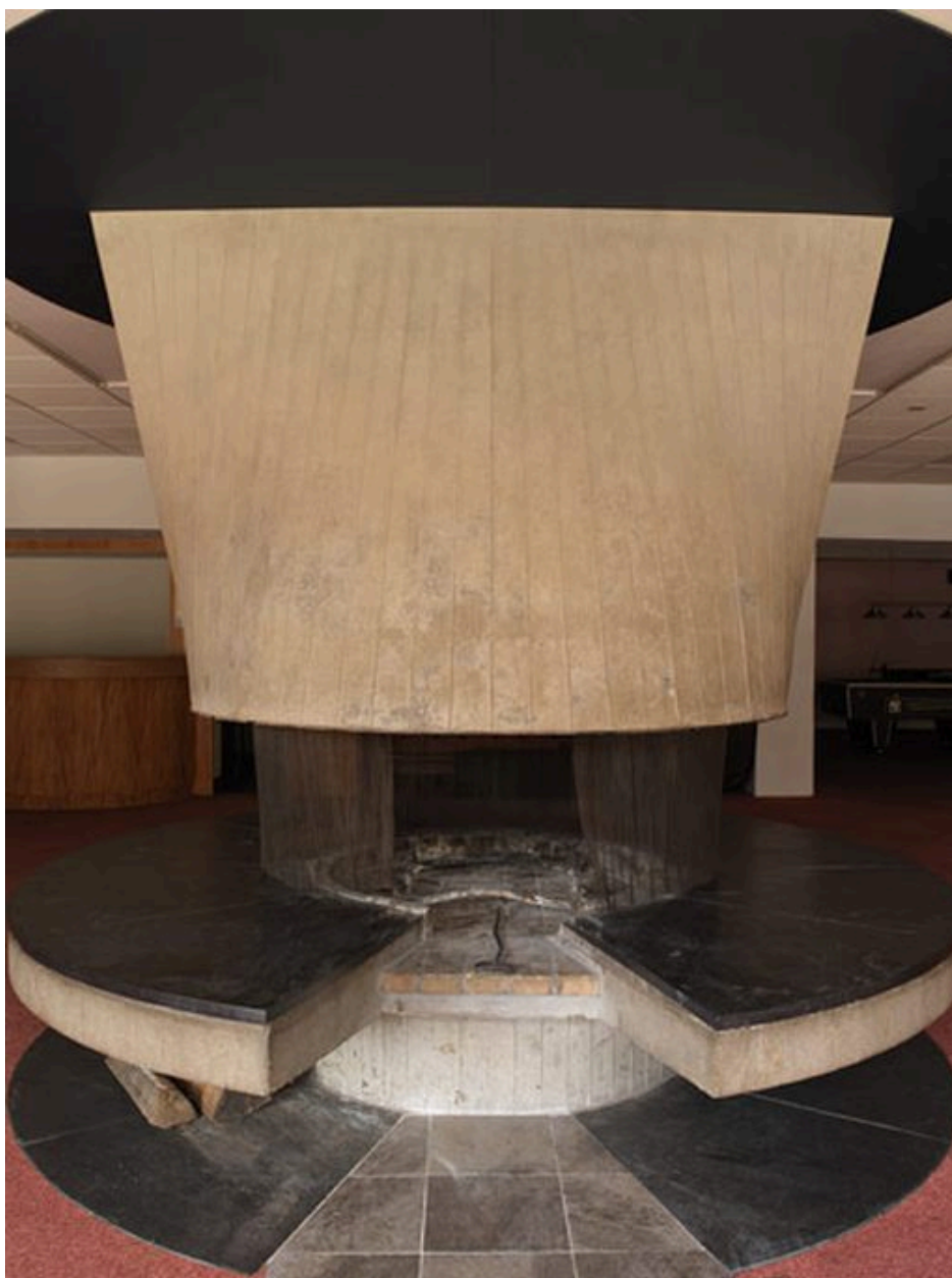
La cheminée. Vue de face
