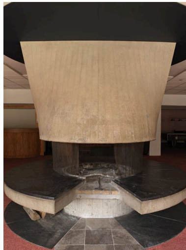
La cheminée. Vue de face Phot. Eric Dessert IVR82_20097400284NUCA
