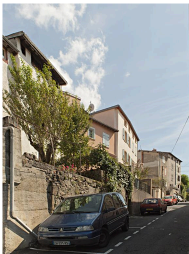
La rue en direction du sud-est. Phot. Jean-Michel Périn IVR83_20146300725NUC4A
