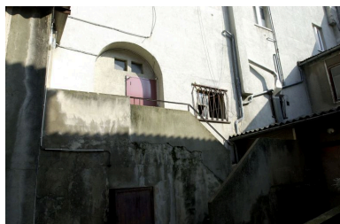
Elévation nord : vue de la travée de l'escalier cours Suchet Phot. Maryannick Chalabi IVR82_20016900396NUCA
