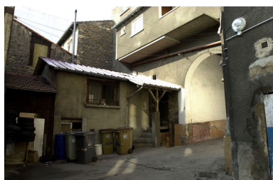
Vue de la maison construite au sud de la cour Phot. Maryannick Chalabi IVR82_20016900398NUCA
