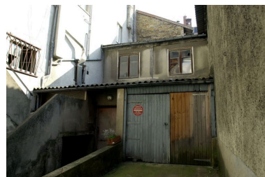
Bâtiment au fond de la cour, au nord-est Phot. Maryannick Chalabi IVR82_20016900395NUCA
