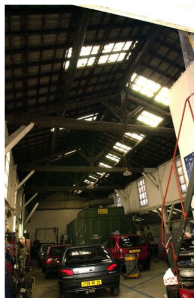
Le garage de réparation automobile : intérieur, vue de la charpente Phot. Maryannick Chalabi IVR82_20016900400NUCA
