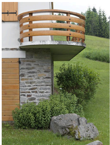
Détail de l'extrémité en arrondi du balcon Phot. Eric Dessert IVR82_20107401212NUCA
