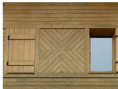
Détail du travail du bois au niveau des baies de l'étage en surcroît Phot. Eric Dessert IVR82_20107401215NUCA
