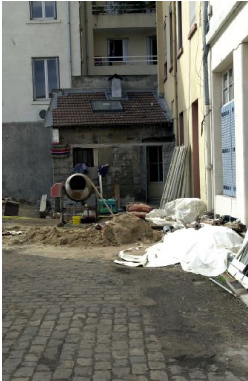
Vue de la loge de concierge dans la cour
