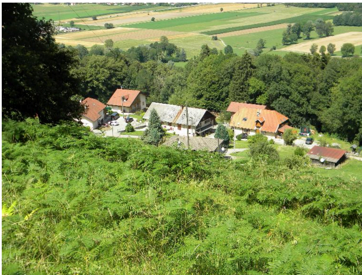
Vue d'ensemble du hameau.
