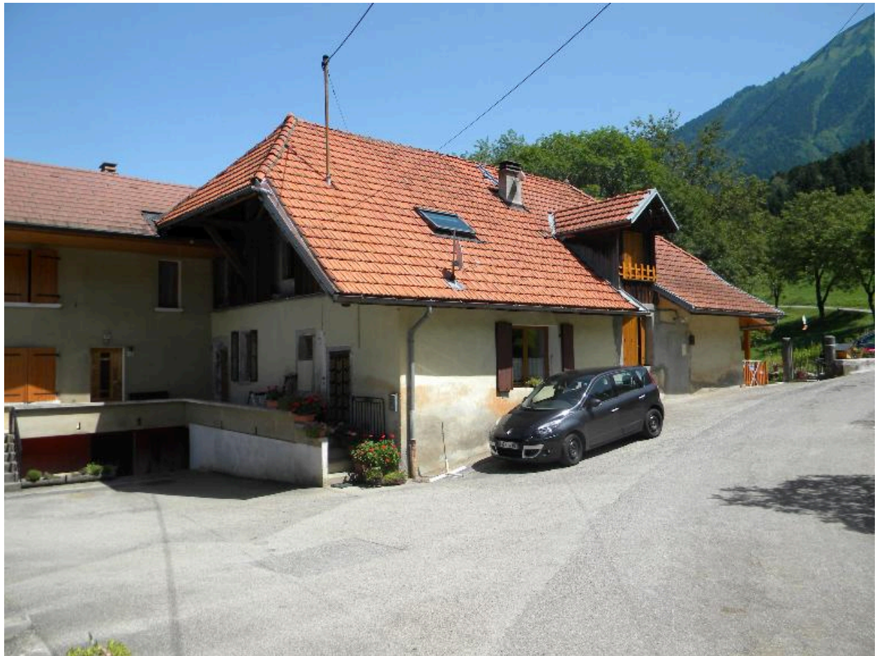
Vue d'une ancienne ferme très transformée (2008 D 12 2983, 3126)
