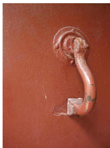
Détail porte : heurtoir métallique Phot. Nadine Halitim-Dubois IVR84_20186901318NUCA
