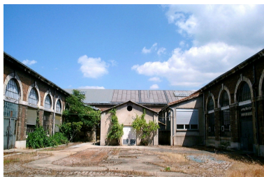
Vue des bâtiments du site de Giat industrie de Saint Etienne Phot. Nadine Halitim-Dubois IVR82_20054202343NUCA
