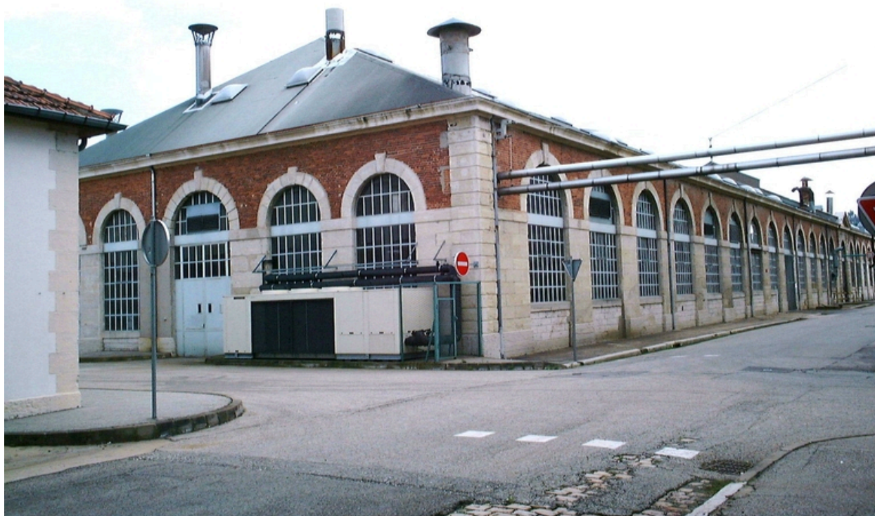
Vue des bâtiments du site de Giat industrie de Saint Etienne
