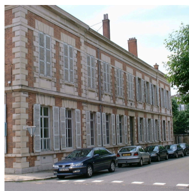
Pavillon d'entrée Phot. Nadine Halitim-Dubois IVR82_20054202328NUCA
