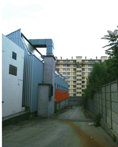
Vue des bâtiments du site de Giat industrie de Saint Etienne Phot. Nadine Halitim-Dubois IVR82_20054202347NUCA
