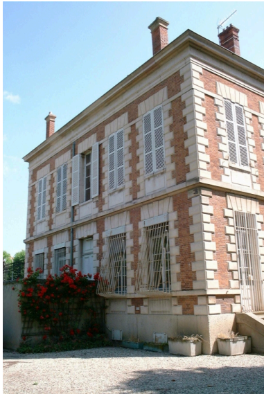
Pavillon d'entrée Phot. Nadine Halitim-Dubois IVR82_20054202329NUCA
