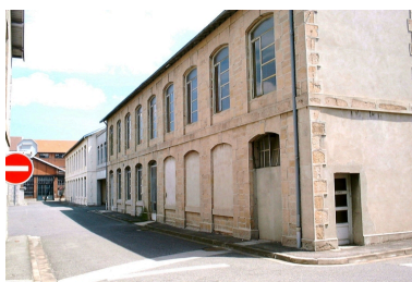
Vue des bâtiments du site de Giat industrie de Saint Etienne Phot. Nadine Halitim-Dubois IVR82_20054201188NUCA
