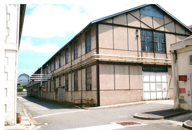
Vue des bâtiments du site de Giat industrie de Saint Etienne Phot. Nadine Halitim-Dubois IVR82_20054201186NUCA
