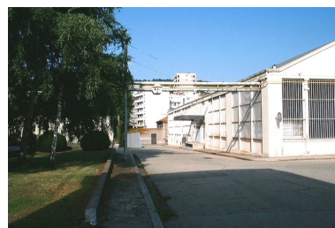
Vue des bâtiments du site de Giat industrie de Saint Etienne Phot. Nadine Halitim-Dubois IVR82_20054201137NUCA
