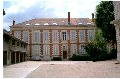
Pavillon d'entrée Phot. Nadine Halitim-Dubois IVR82_20054202331NUCA
