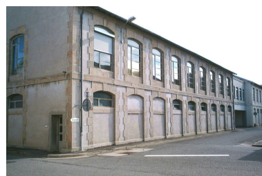
Vue des bâtiments du site de Giat industrie de Saint Etienne Phot. Nadine Halitim-Dubois IVR82_20054201130NUCA
