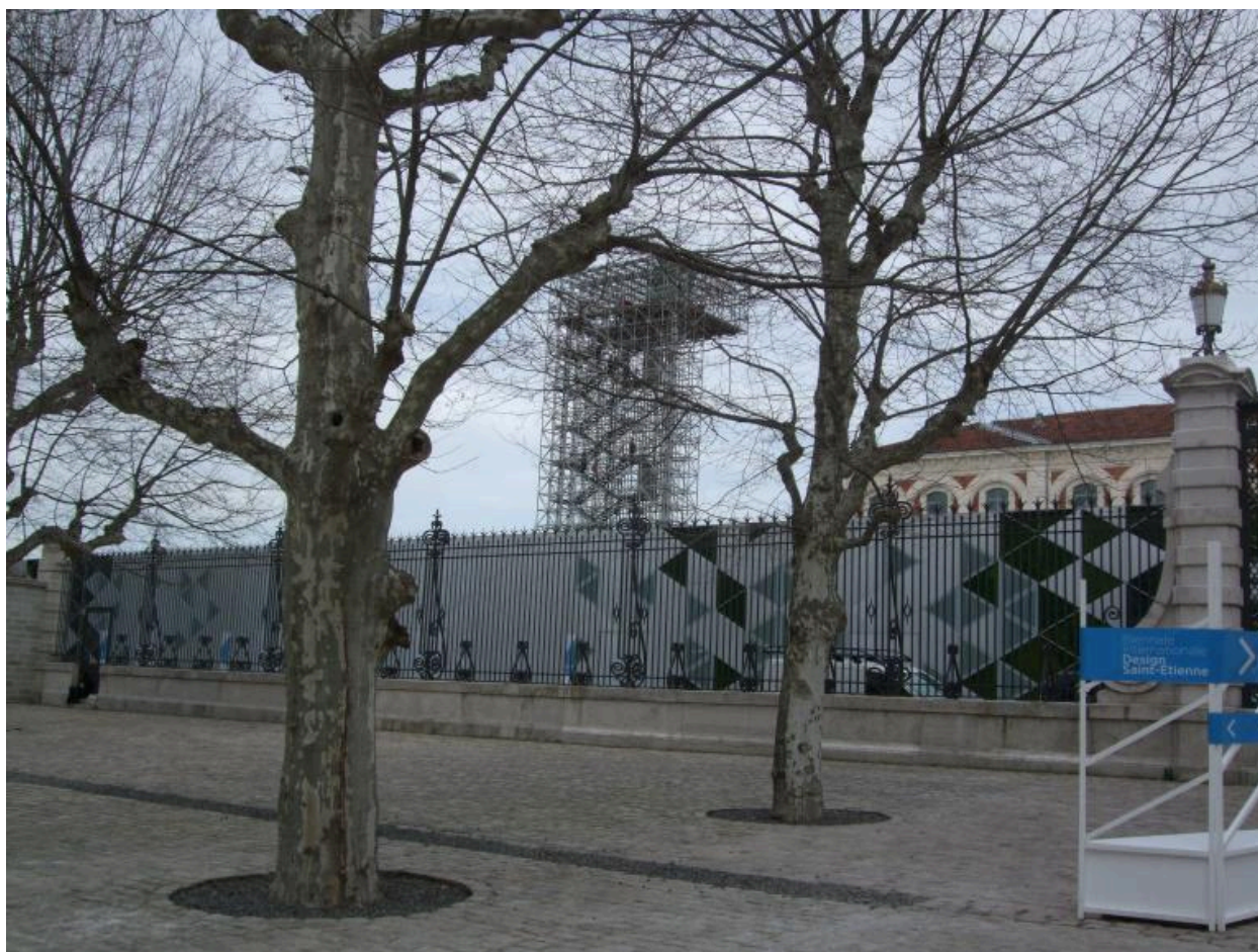
Vue de la tour observatoire métallique.
