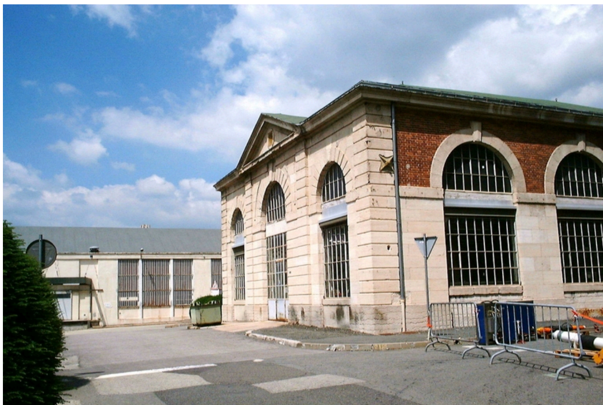
Détail bâtiment du site de Giat industrie de Saint-Etienne
