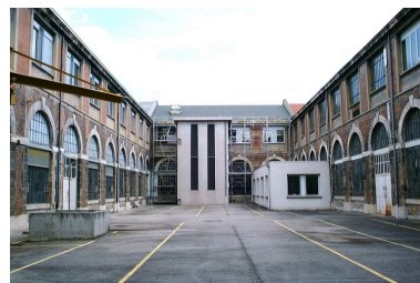
Vue des bâtiments du site de Giat industrie de Saint Etienne Phot. Nadine Halitim-Dubois IVR82_20054201152NUCA
