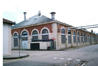
Vue des bâtiments du site de Giat industrie de Saint Etienne Phot. Nadine Halitim-Dubois IVR82_20054201180NUCA
