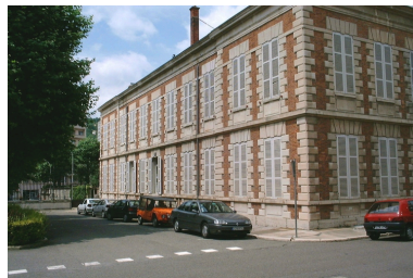
Pavillon d'entrée Phot. Nadine Halitim-Dubois IVR82_20054202333NUCA
