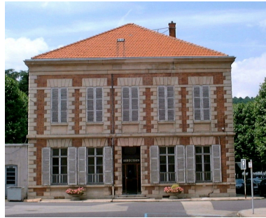
Pavillon d'entrée Phot. Nadine Halitim-Dubois IVR82_20054202330NUCA
