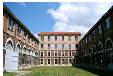
Vue des bâtiments du site de Giat industrie de Saint Etienne Phot. Nadine Halitim-Dubois IVR82_20054202344NUCA
