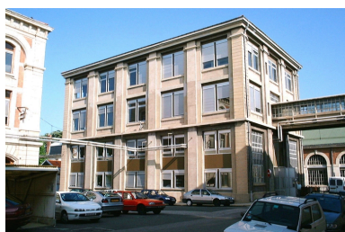
Vue des bâtiments du site de Giat industrie de Saint Etienne Phot. Nadine Halitim-Dubois IVR82_20054201141NUCA
