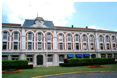
Bâtiment principal dit bâtiment de l'horloge du site de Giat industrie de Saint-Etienne Phot. Nadine Halitim-Dubois IVR82_20054202353NUCA
