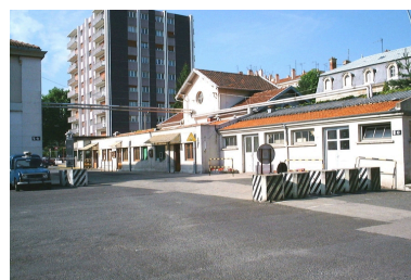
Vue des bâtiments du site de Giat industrie de Saint Etienne Phot. Nadine Halitim-Dubois IVR82_20054201143NUCA
