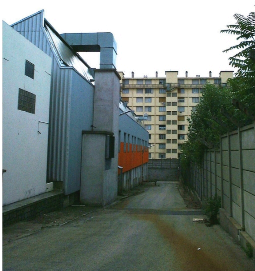
Vue des bâtiments du site de Giat industrie de Saint Etienne
