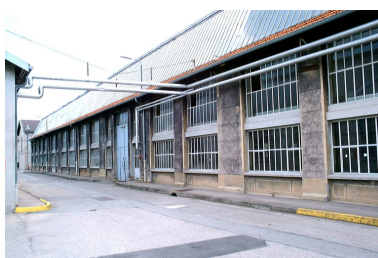
Vue des bâtiments du site de Giat industrie de Saint Etienne Phot. Nadine Halitim-Dubois IVR82_20054202318NUCA
