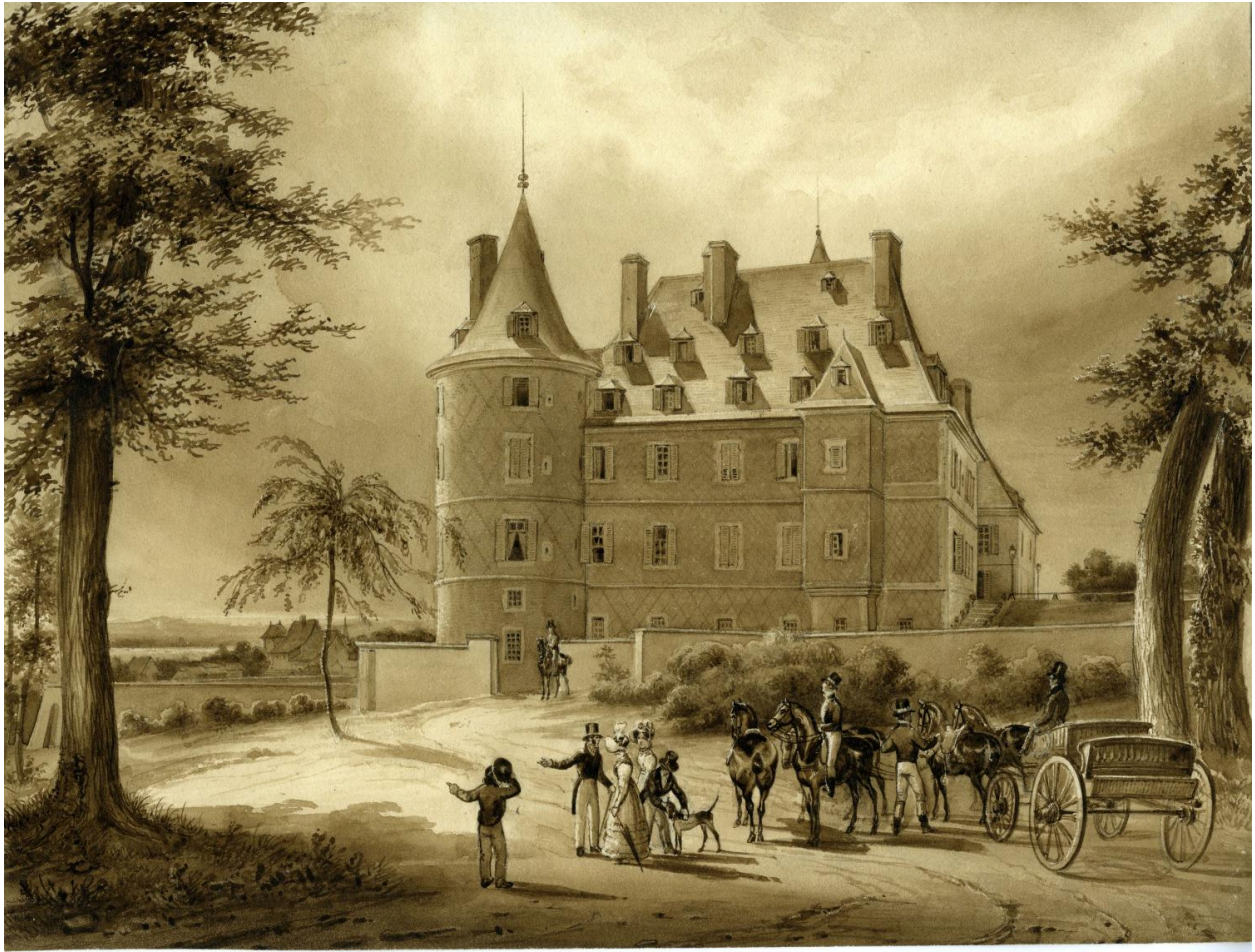
Vue est après travaux
