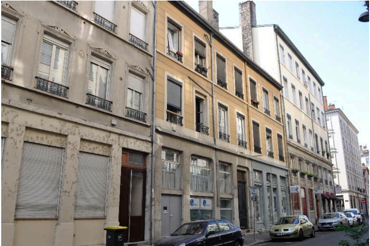
Vue générale de l'élévation sur rue
