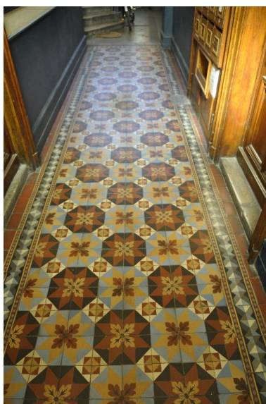
Vue intérieure : le pavement de l'allée Phot. Magali Delavenne IVR82_20156901208NUCA
