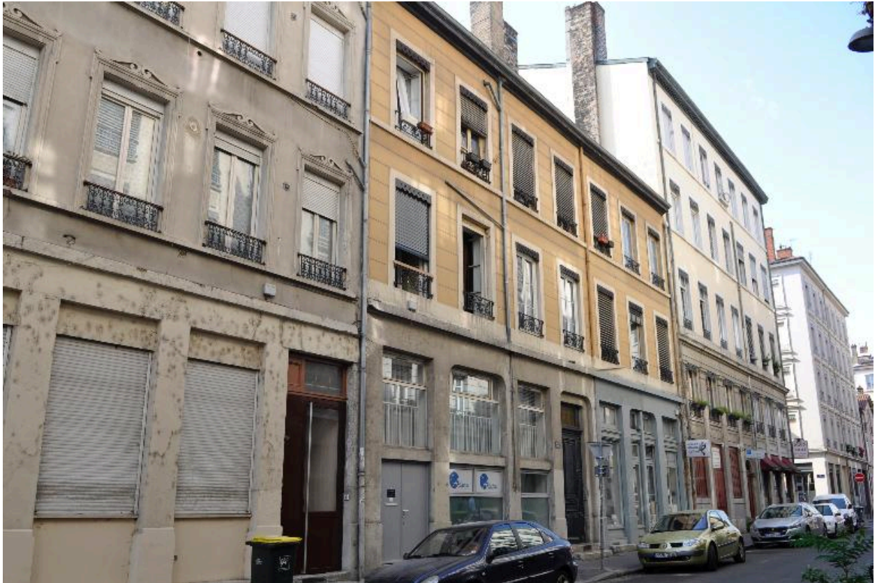
Vue générale de l'élévation sur rue
