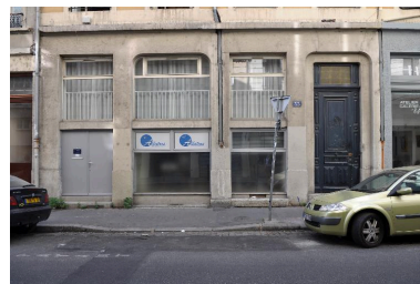
Vue du rez-de-chaussée Phot. Magali Delavenne IVR82_20156901206NUCA
