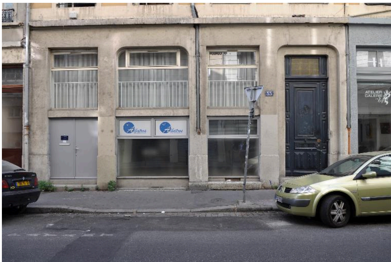
Vue du rez-de-chaussée
