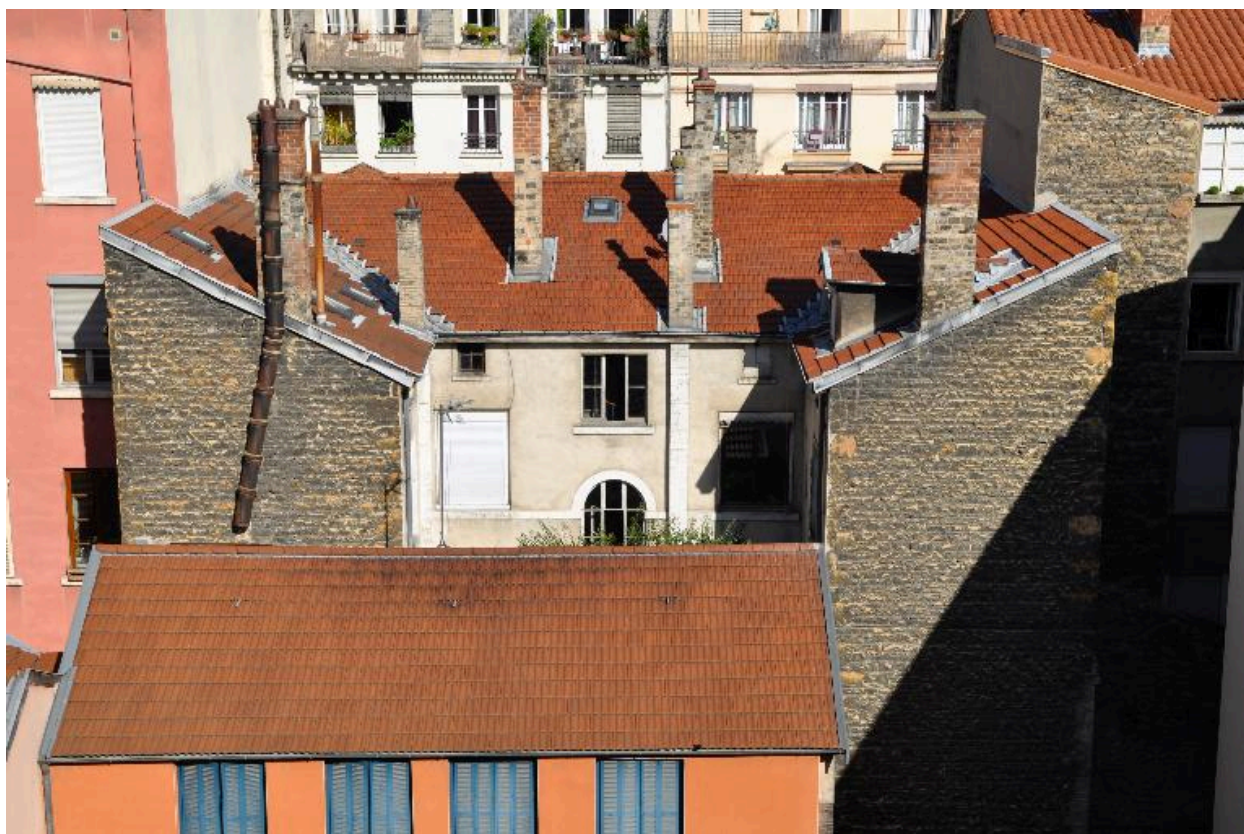
Vue générale de l'élévation postérieure
