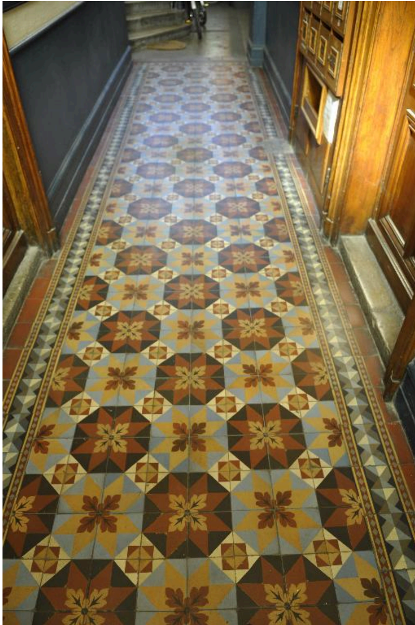
Vue intérieure : le pavement de l'allée
