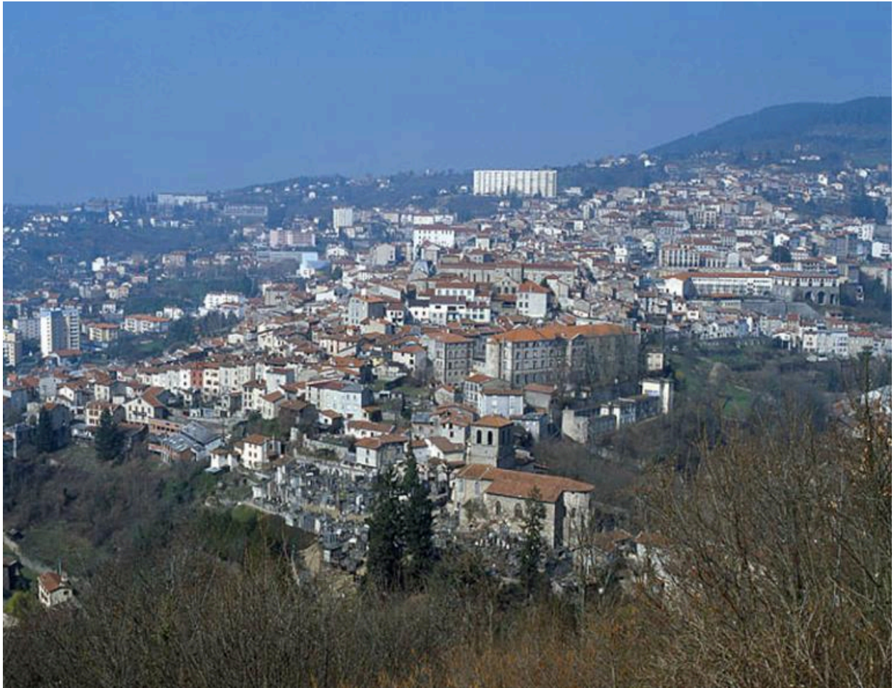
La ville depuis le sud-est, avant démolition de la "barre" de logements des Jaiffours dans les quartiers hauts.
