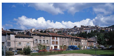
La ville haute depuis le quartier du Mouëtier, dans le bas de la ville. Phot. Jean-Michel Périn IVR83_20086300547XA
