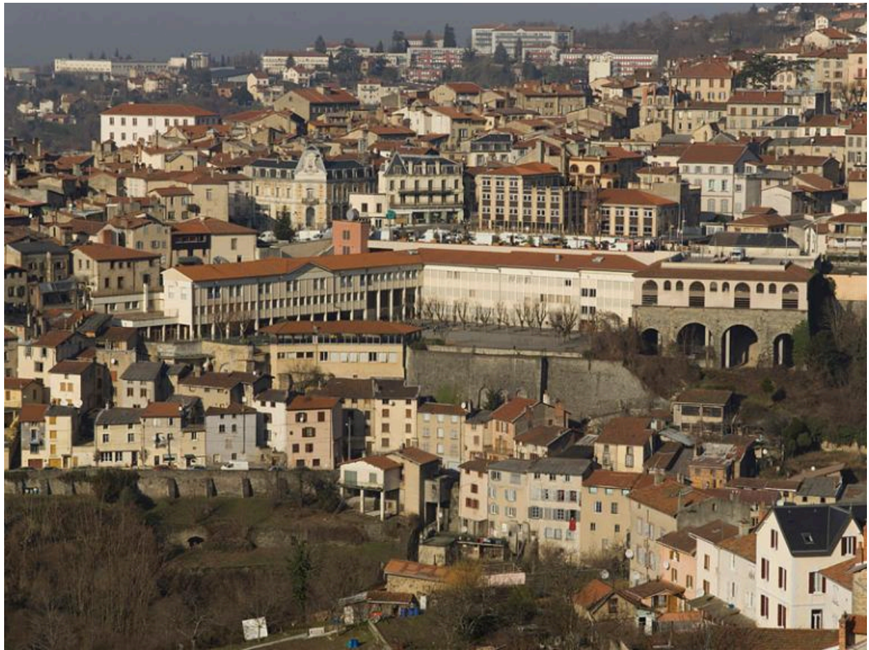
Vue partielle du centre depuis l'est.
