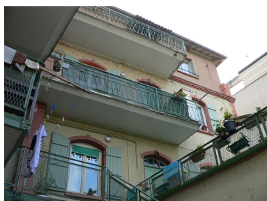
Façade sur cour Phot. Isabelle Dupuis IVR82_20093800575NUCA
