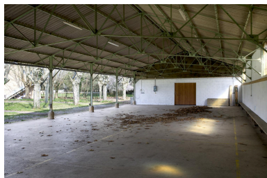
Préau, vue d'ensemble Phot. Franck Trabouillet IVR84_20210100254NUCAQ
