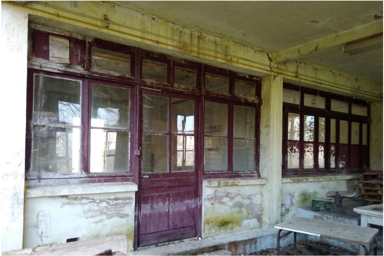
Elévation nord, détail de menuiseries
