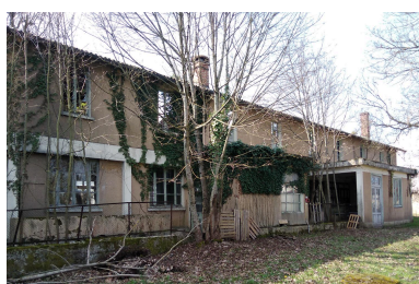
Elévation nord, partie ouest Phot. Magali Delavenne IVR84_20210100441NUCA
