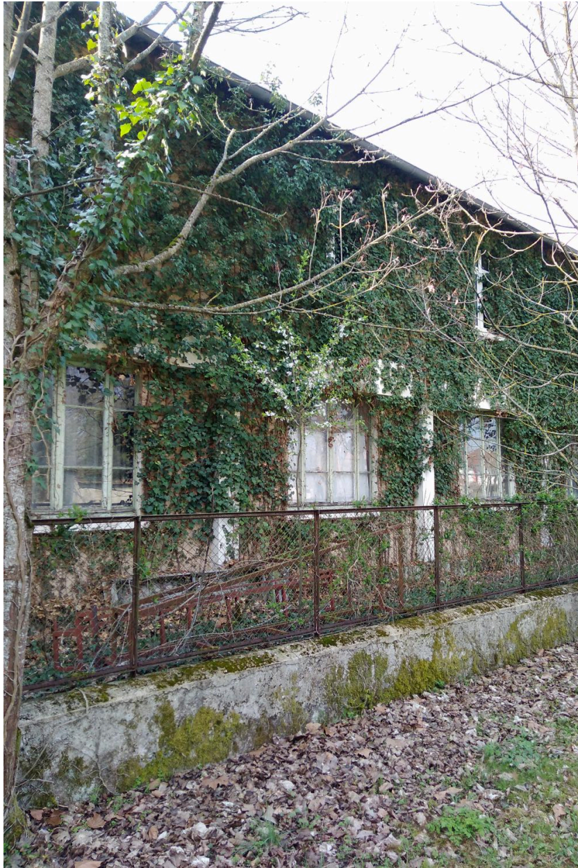
Elévation nord, détail de façade
