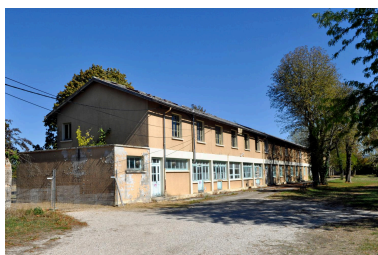
Vue générale depuis le sud-ouest Phot. Magali Delavenne IVR84_20200101046NUCA
