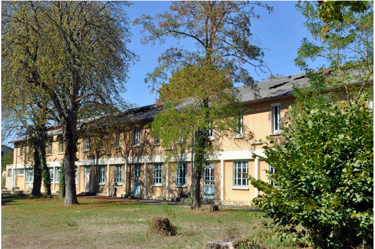
Elévation sud, vue générale
