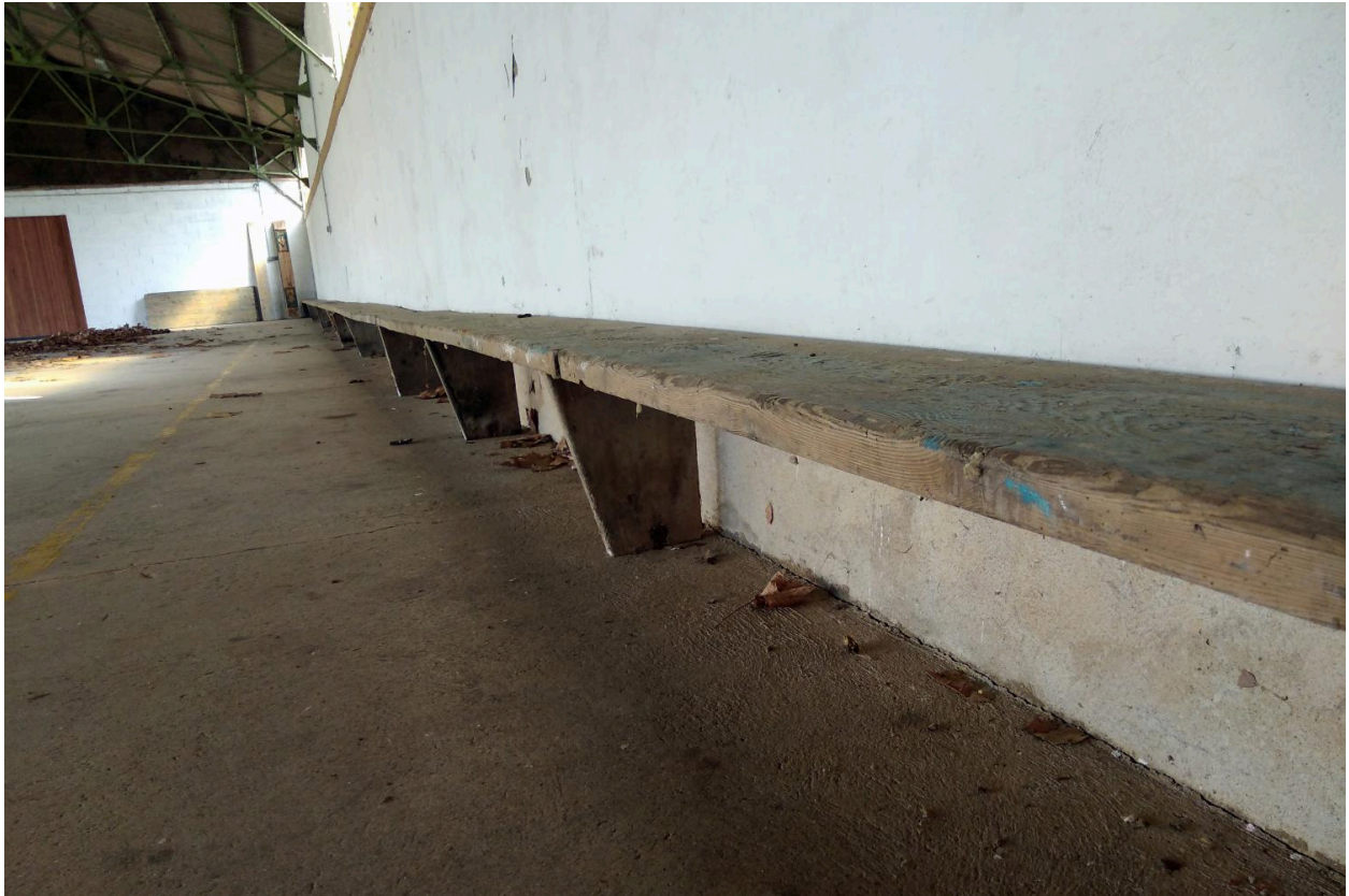
Préau, banc en bois adossé au mur est
