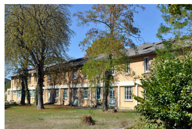
Elévation sud, vue générale Phot. Magali Delavenne IVR84_20200101047NUCA
