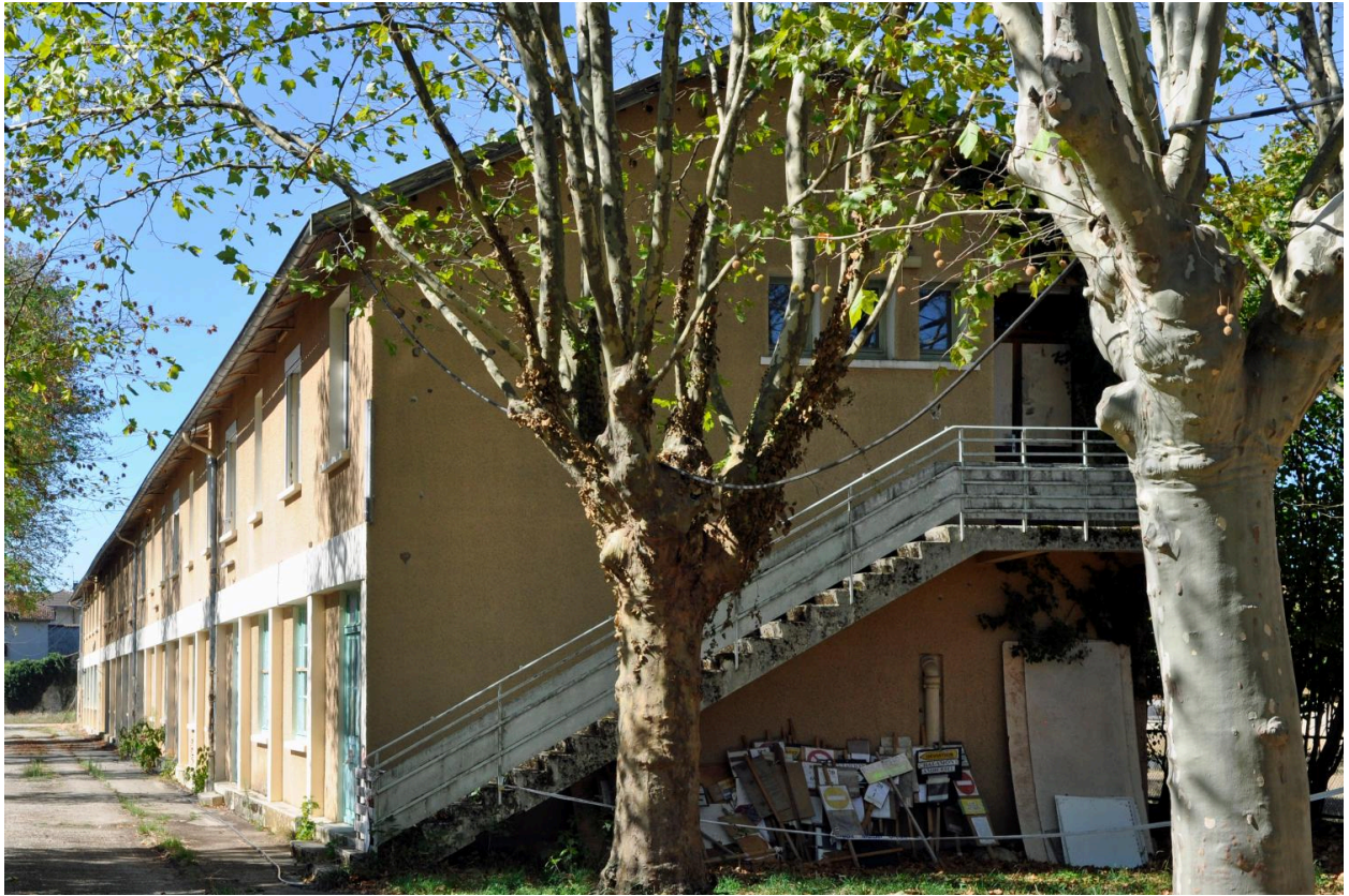
Mur pignon est
