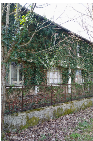
Elévation nord, détail de façade
