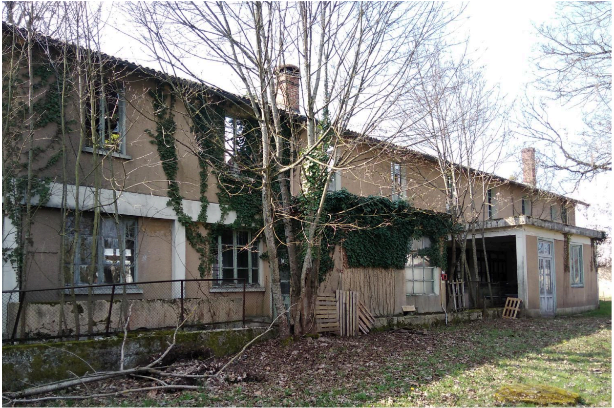
Elévation nord, partie ouest
