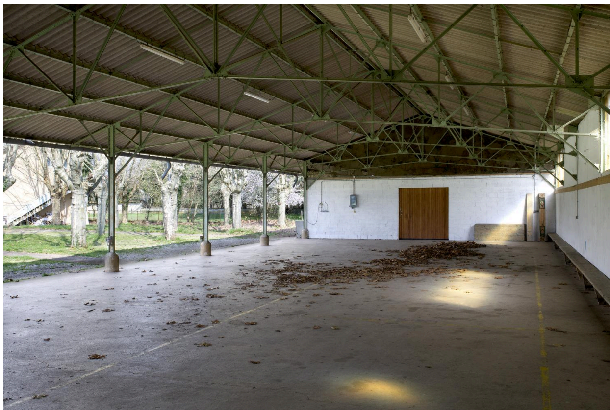
Préau, vue d'ensemble
