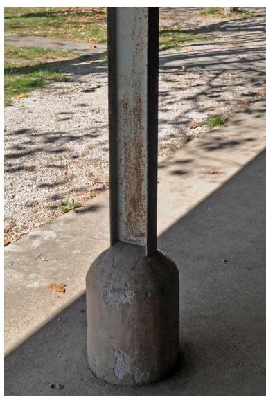
Préau, détail d'un pilier Phot. Magali Delavenne IVR84_20200101035NUCA
