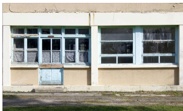
Bâtiment de la colonie, détail de menuiseries Phot. Franck Trabouillet IVR84_20210100261NUCA
