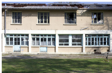
Bâtiment de la colonie, détail de façade Phot. Franck Trabouillet IVR84_20210100260NUCA
