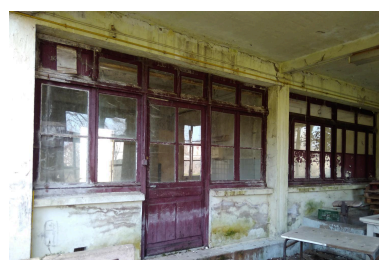
Elévation nord, détail de menuiseries Phot. Magali Delavenne IVR84_20210100442NUCA
