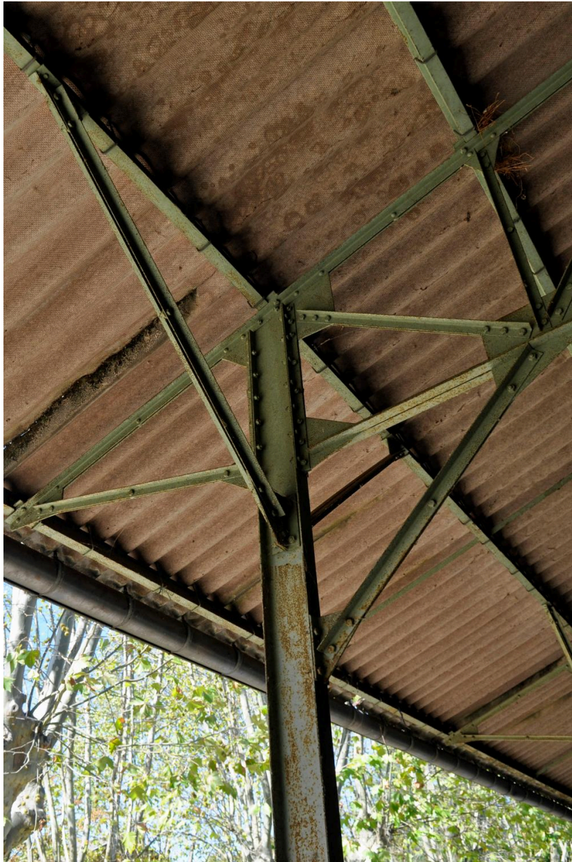
Préau, détail d'assemblage de la charpente métallique
