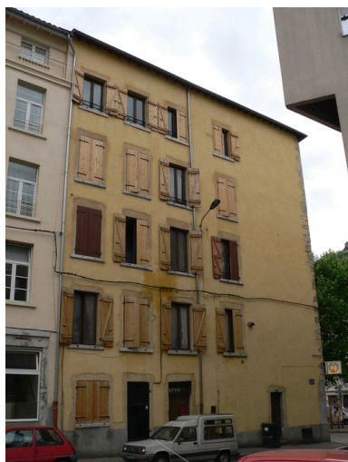
Façade latérale gauche Phot. Isabelle Dupuis IVR82_20093800547NUCA
