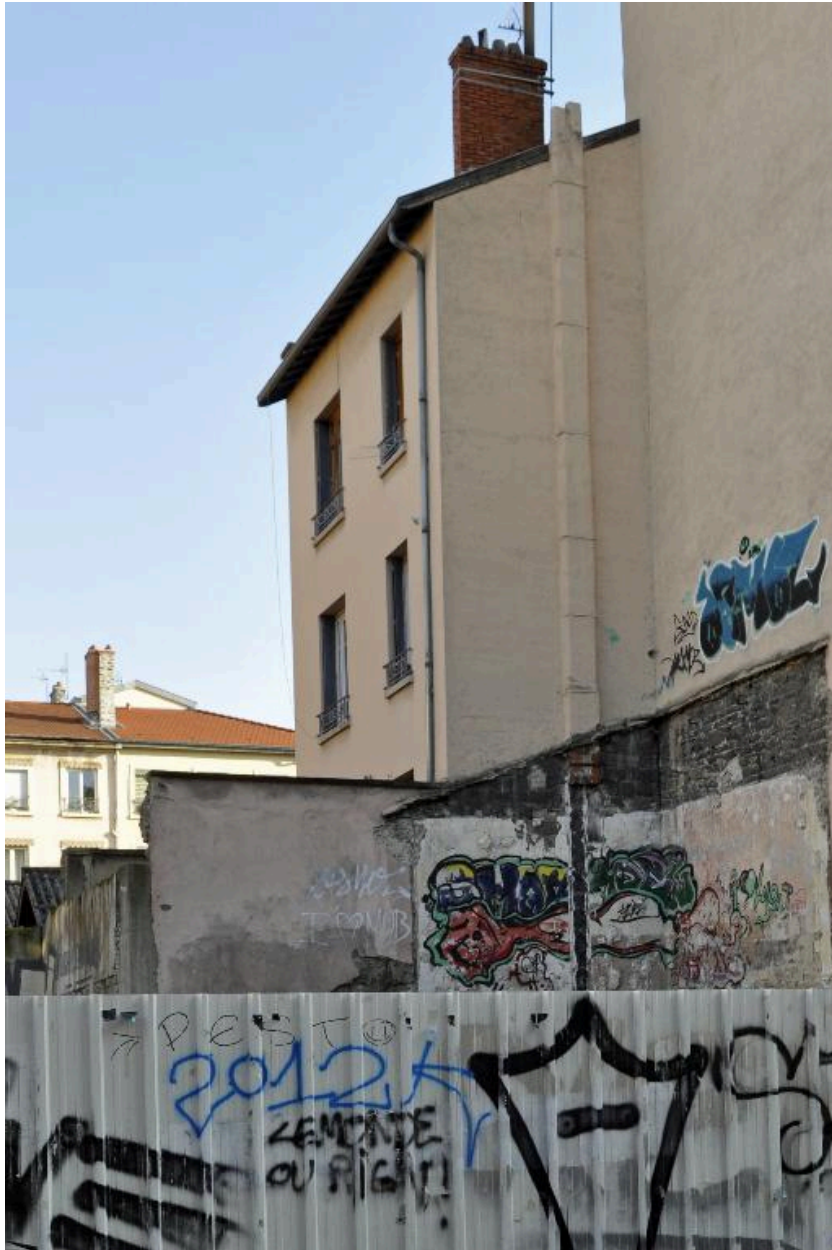
Elévation postérieure, vue partielle
