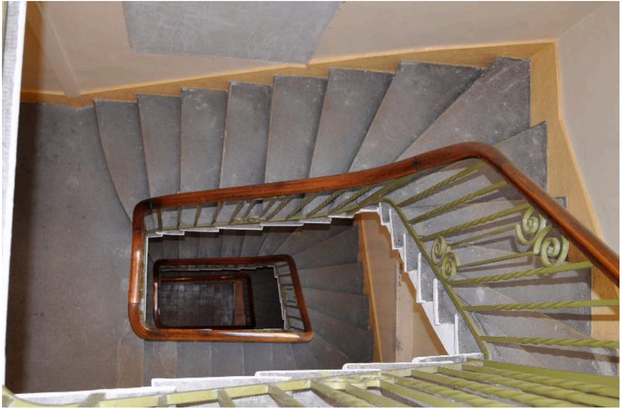
Vue intérieure : la cage d'escalier
