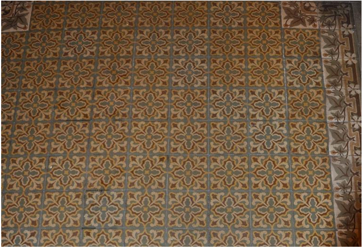
Détail du pavement de l'allée
