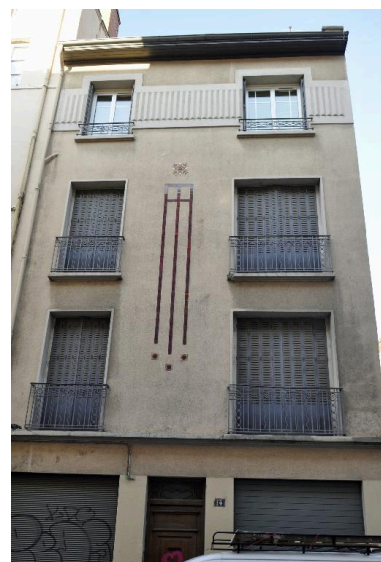
Elévation sur rue Phot. Magali Delavenne IVR84_20166902103NUCA
