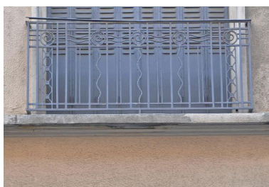
Elévation sur rue, ferronnerie du garde-corps Phot. Magali Delavenne IVR84_20166902105NUCA
