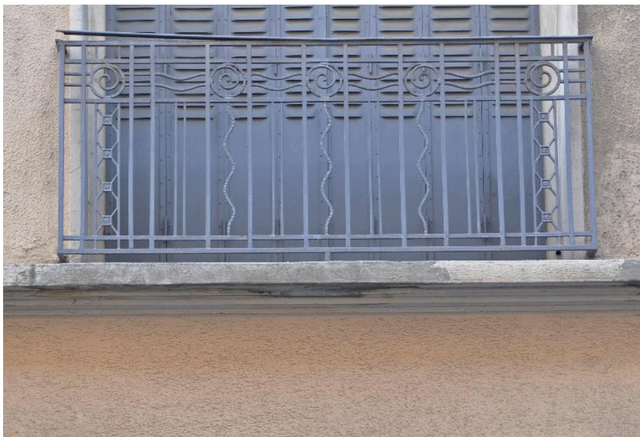
Elévation sur rue, ferronnerie du garde-corps
