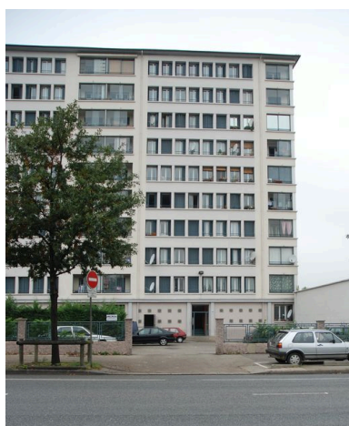
Vue d'une travée Phot. Maryannick Chalabi IVR82_20116901586NUCA
