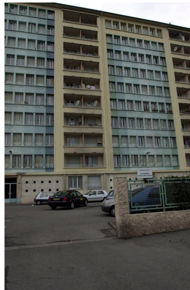
Détail des loggia Phot. Maryannick Chalabi IVR82_20016900089NUCA
