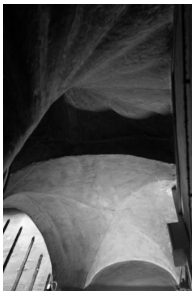
Escalier et voûte d'arêtes d'un palier, détail Phot. Lore Derail IVR82_20036901380NUCA
