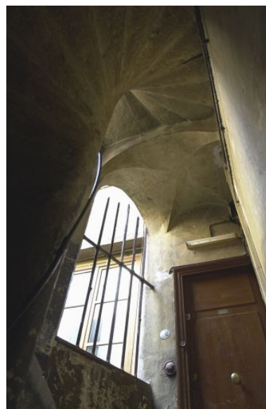
Escalier et voûte d'arêtes d'un palier Phot. Lore Derail IVR82_20036901379NUCA
