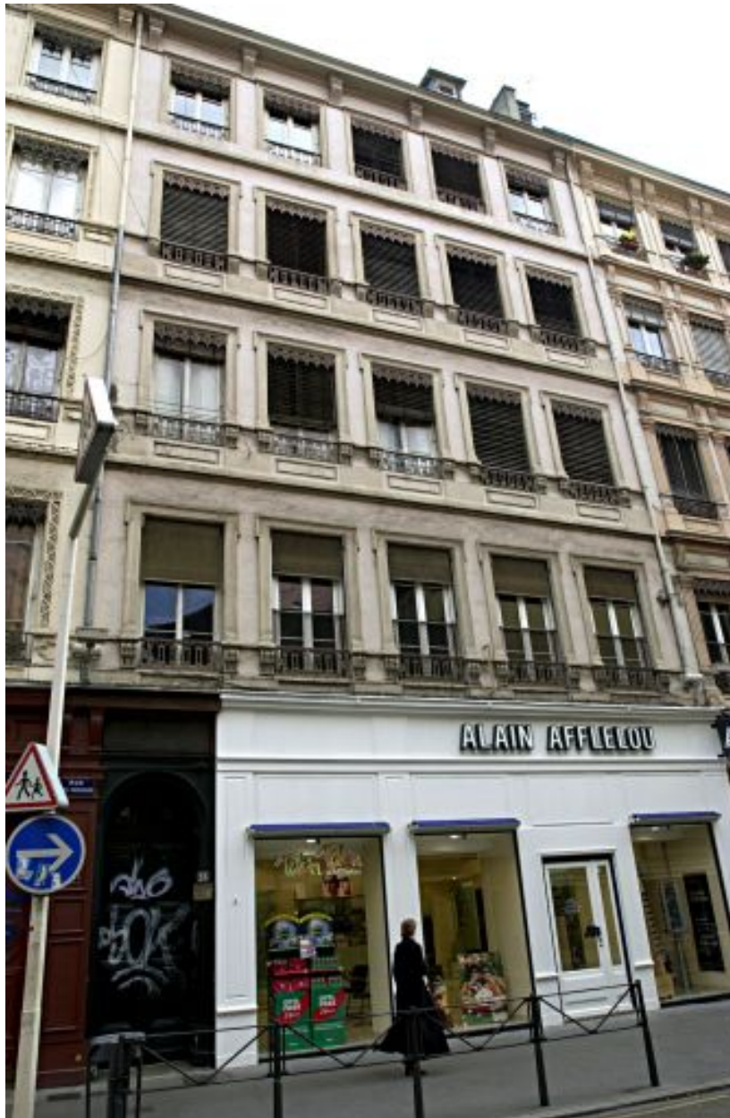
Façade principale, vue générale
