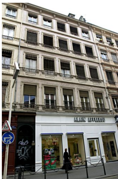
Façade principale, vue générale Phot. Maryannick Chalabi IVR82_20046900155NUCA
