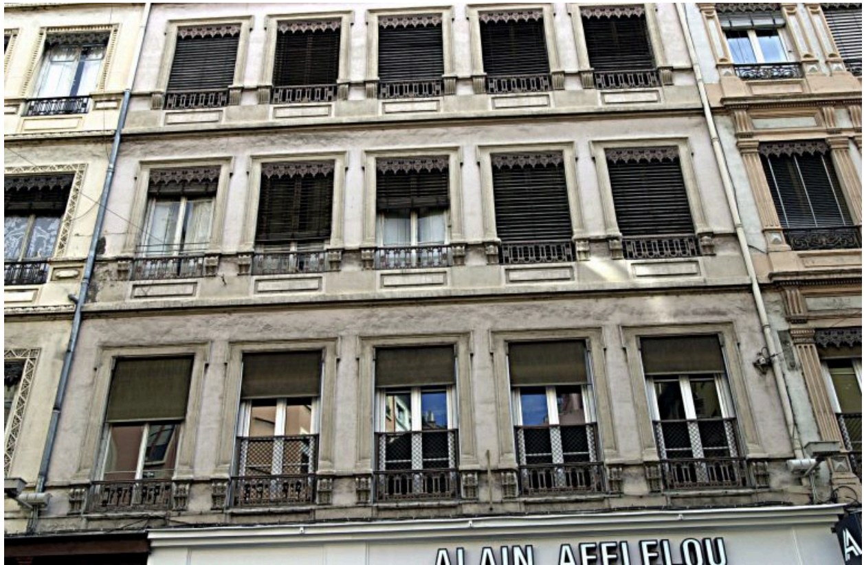
Façade principale, détail de l'élévation
