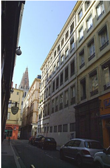
Façade sur la rue Pléney Phot. Bernard Ducouret IVR82_20046900158NUCA
