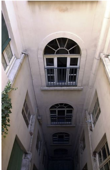
Cour et cage d'escalier Phot. Bernard Ducouret IVR82_20046900159NUCA
