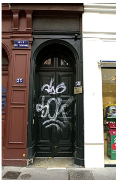
Façade principale, détail de la porte Phot. Maryannick Chalabi IVR82_20046900156NUCA
