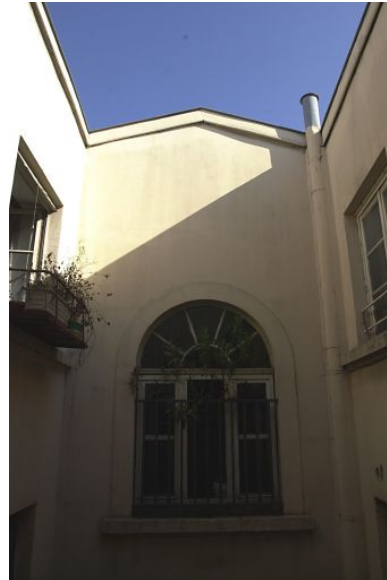
Cour, dernier niveau de l'élévation de la cage d'escalier Phot. Bernard Ducouret IVR82_20046900160NUCA
