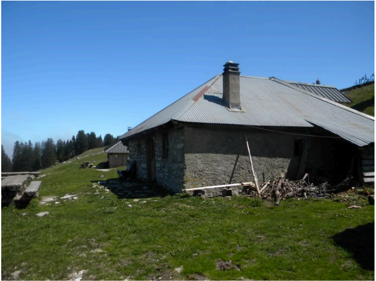
Vue du chalet d'habitation.
