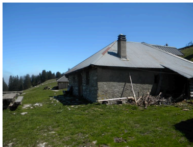
Vue du chalet d'habitation. Phot. Jérôme Daviet IVR82_20107402627NUCA
