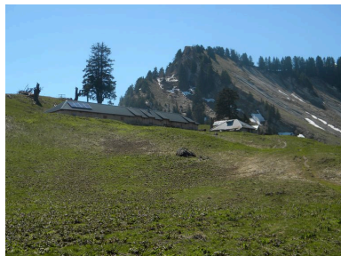
Vue générale des chalets. Phot. Jérôme Daviet IVR82_20107402626NUCA
