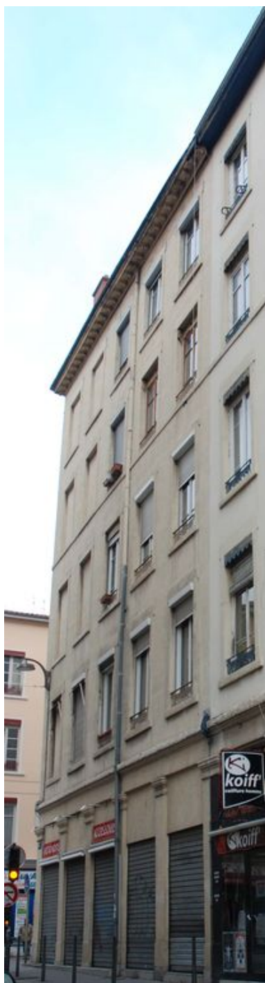
Elévation sur la rue d'Aguesseau Phot. Catherine Guillot IVR82_20136900026NUCA
