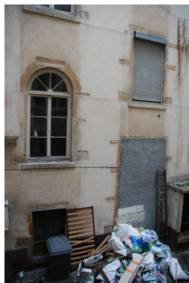
Elévation postérieure : porte murée donnant sur la cour commune Phot. Catherine Guillot IVR82_20136900023NUCA
