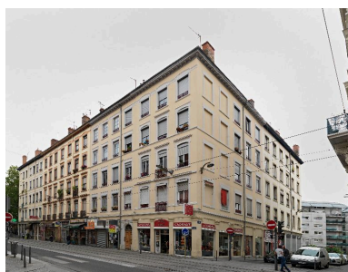
Vue de situation au sein de l'ilot, façades composées en miroir Phot. Eric Dessert IVR84_20166901454NUCA
