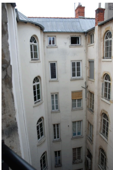
Elévation postérieure, baies cintrées éclairant la cage d'escalier (à droite de l'image) Phot. Catherine Guillot IVR82_20136900036NUCA
