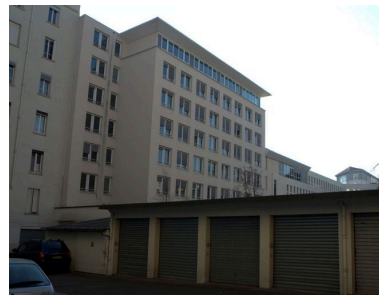
Élévation postérieure, détail de la partie nord Phot. Maryannick Chalabi IVR82_20116904938NUCA
