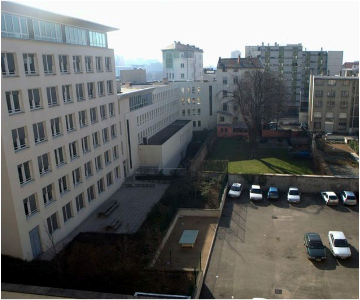
Elévation postérieure, depuis le nord
