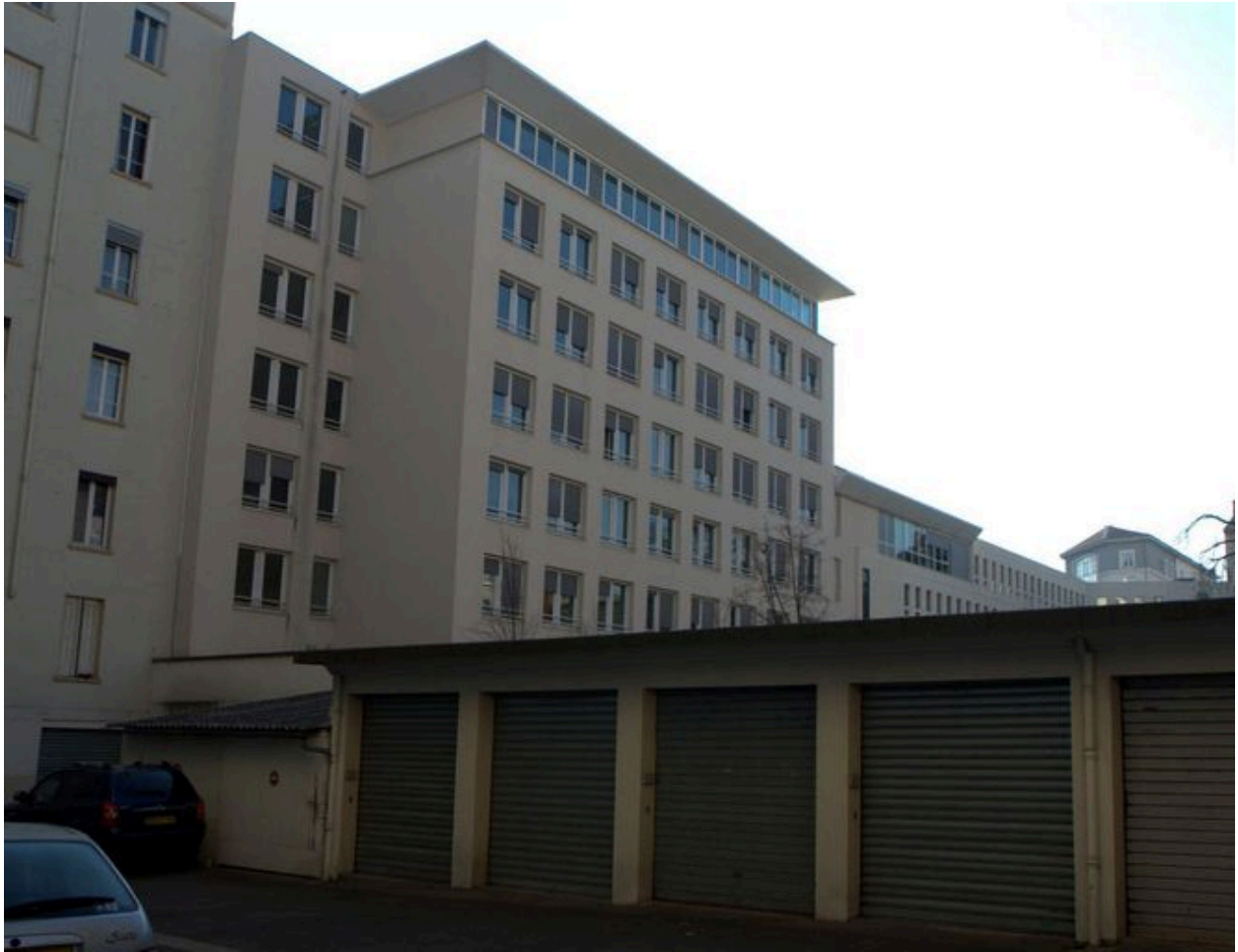
Elévation postérieure, détail de la partie nord
