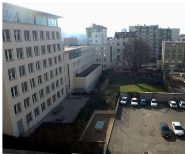
Élévation postérieure, depuis le nord Phot. Maryannick Chalabi IVR82_20116904937NUCA
