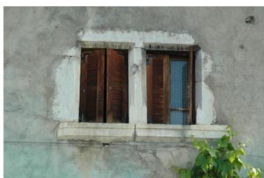
Détail de fenêtre à meneau à encadrement à chanfrein et congés (rez-de-chaussée surélevé, côté sud).
