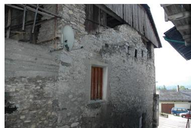
Elévation sur l'impasse des Carrières : rampants de l'ancien pignon, trumeaux maçonnés aux angles supportant la nouvelle charpente.
