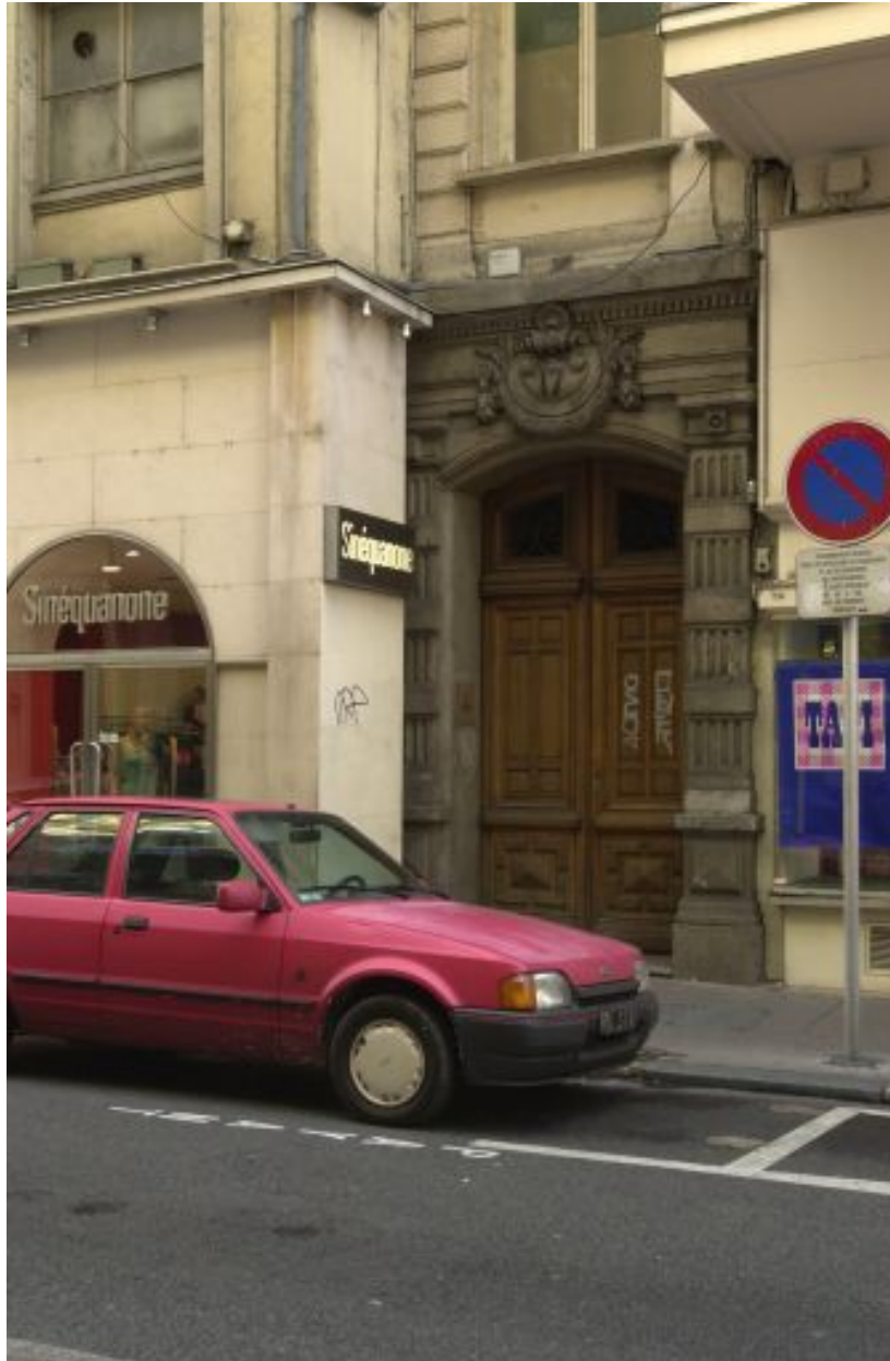
Façade principale rue de Brest, porte
