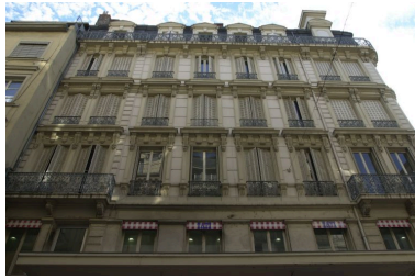
Façade principale rue de Brest, vue par-dessous Phot. Bernard Ducouret IVR82_20046900791NUCA
