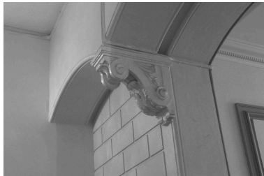
Escalier, entrée du palier du rez-de-chaussée, détail de la console Phot. Bernard Ducouret IVR82_20046900794NUC
