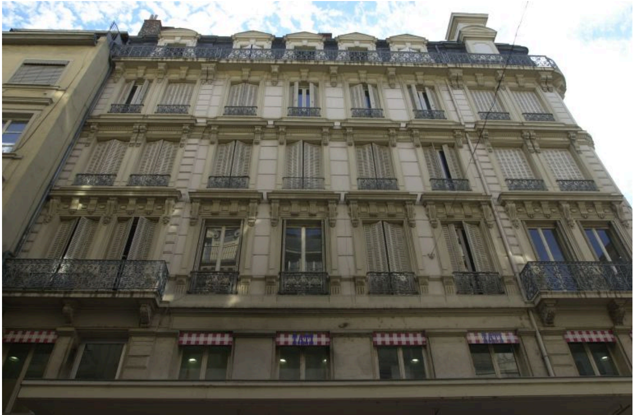
Façade principale rue de Brest, vue par-dessous
