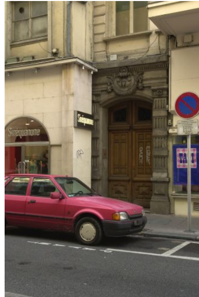
Façade principale rue de Brest, porte Phot. Bernard Ducouret IVR82_20046900792NUCA
