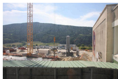
L'oeuvre au moment des travaux de restructuration, v. 2010 : vue d'ensemble Phot. Etudiants de l'Ecole Saint-Luc, Liège IVR84_20223800021NUCA
