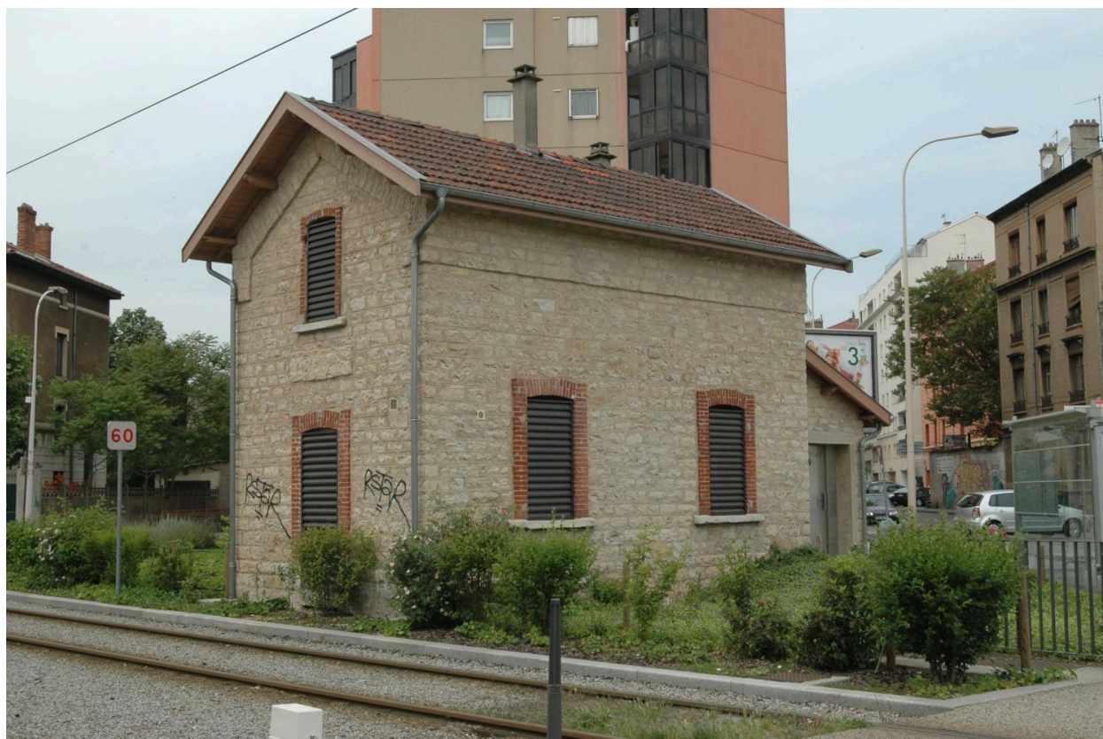
Maisonnette de passage à niveau de l'ancienne gare de l'Est (angle Dauphiné-Lacassagne)
