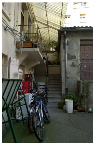
Vue de l'escalier extérieur d'accès à l'étage Phot. Maryannick Chalabi IVR82_20086900686NUCA
