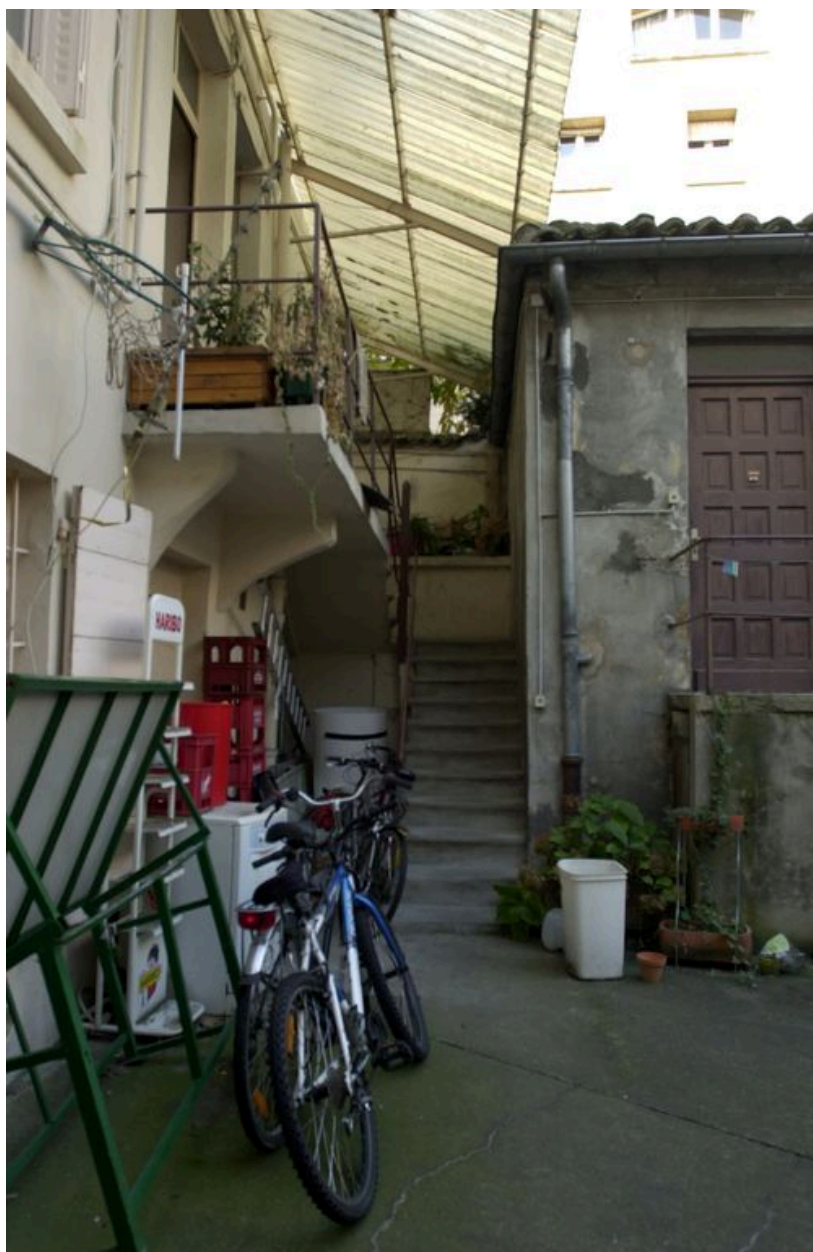
Vue de l'escalier extérieur d'accès à l'étage
