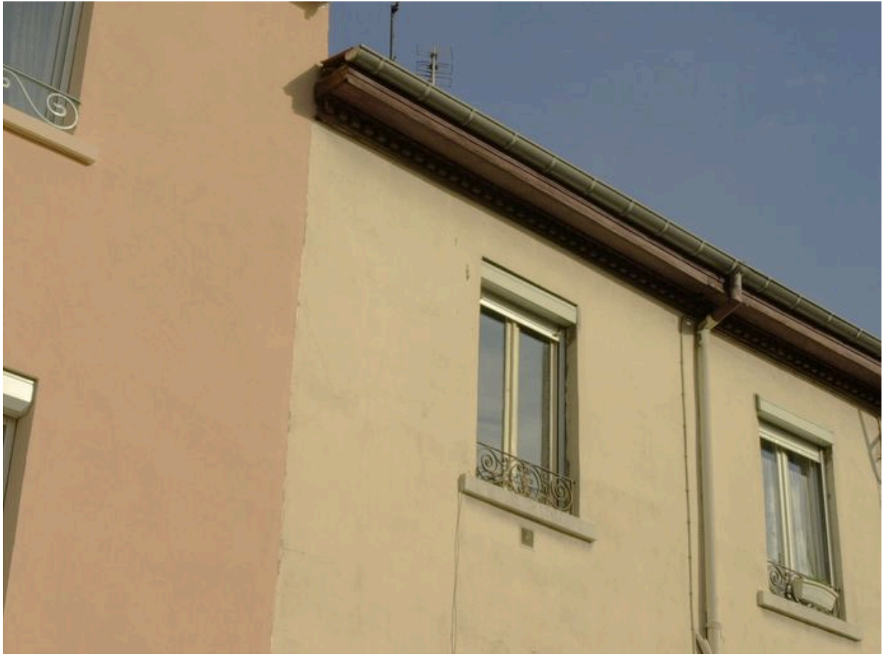
Détail de la corniche en bois sur denticules
