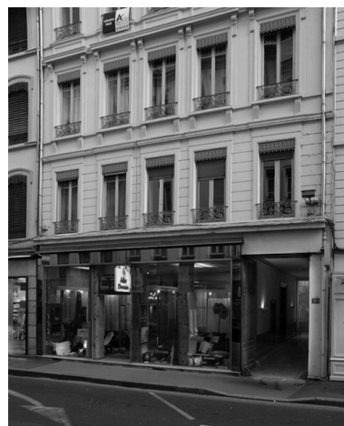
Entrée par l'immeuble du 20 cours Vitton
