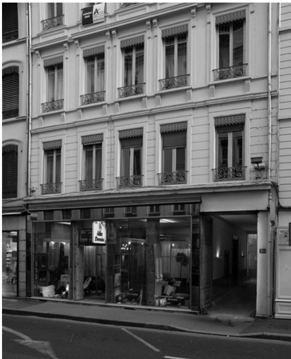
Entrée par l'immeuble du 20 cours Vitton
