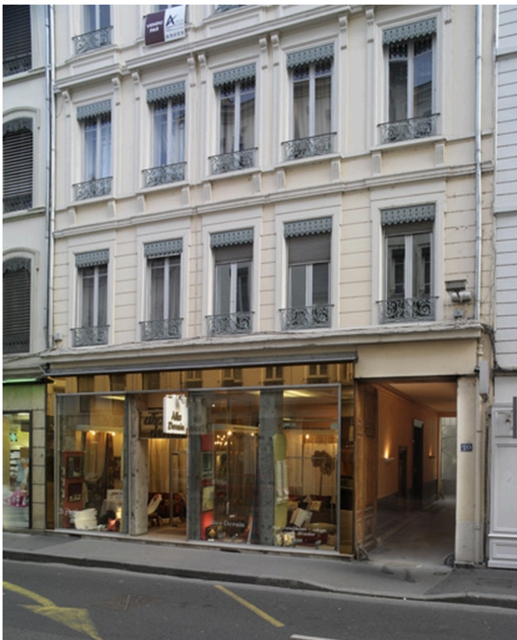
Entrée par l'immeuble du 20 cours Vitton
