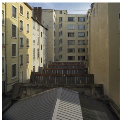
Vue générale zénithale des atelier
