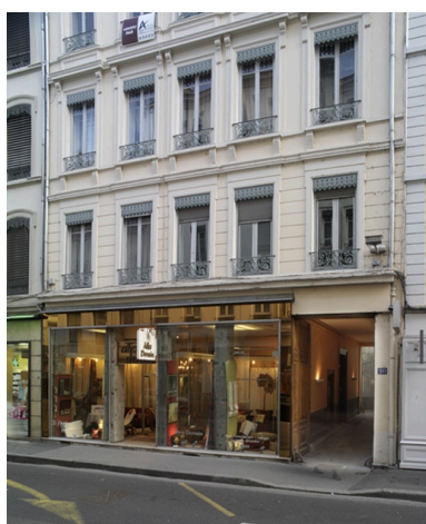
Entrée par l'immeuble du 20 cours Vitton
