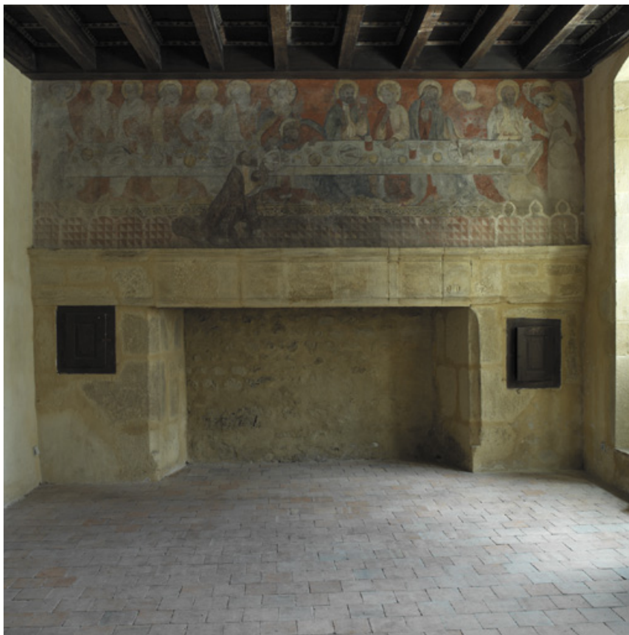
Vue de la cheminée du réfectoire.
