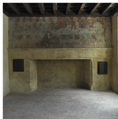
Vue de la cheminée du réfectoire. Phot. Eric Dessert IVR82_20034201667NUCA
