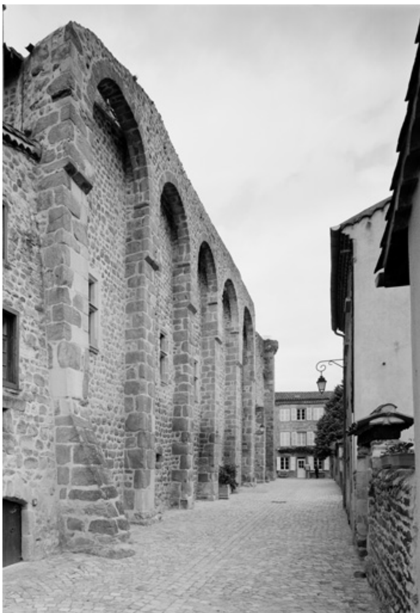
Vue d'ensemble de la façade nord de l'aile nord, depuis le nord-est.
