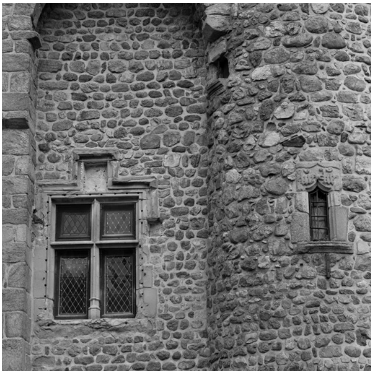
Détail du premier étage de l'aile ouest : fenêtre de la dernière travée (vers le sud), fenêtre de la tour de l'angle sud-ouest des bâtiments conventuels.
