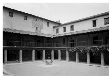
Vue de l'angle nord-ouest du cloître. Phot. Eric Dessert IVR82_20064200014P
