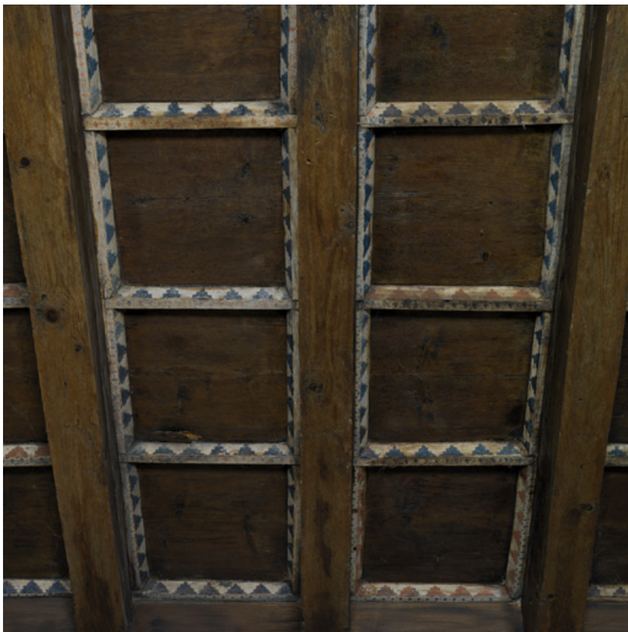
Détail du plafond du réfectoire.
