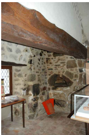
Aile ouest, vue intérieure de la 'cuisine' : cheminée avec four à pain, contre le mur nord. Phot. Caroline Guibaud IVR82_20104200251NUCA
