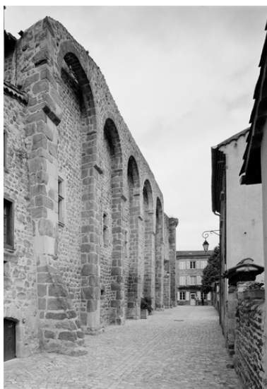
Vue d'ensemble de la façade nord de l'aile nord, depuis le nord-est. Phot. Eric Dessert IVR82_20064200013P
