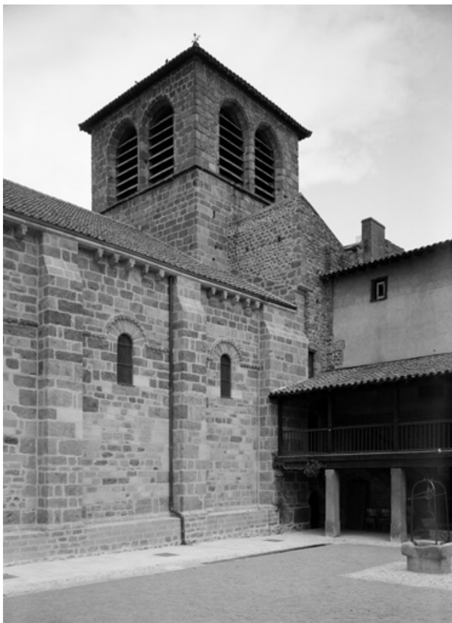
Vue de l'angle sud-ouest du cloître.
