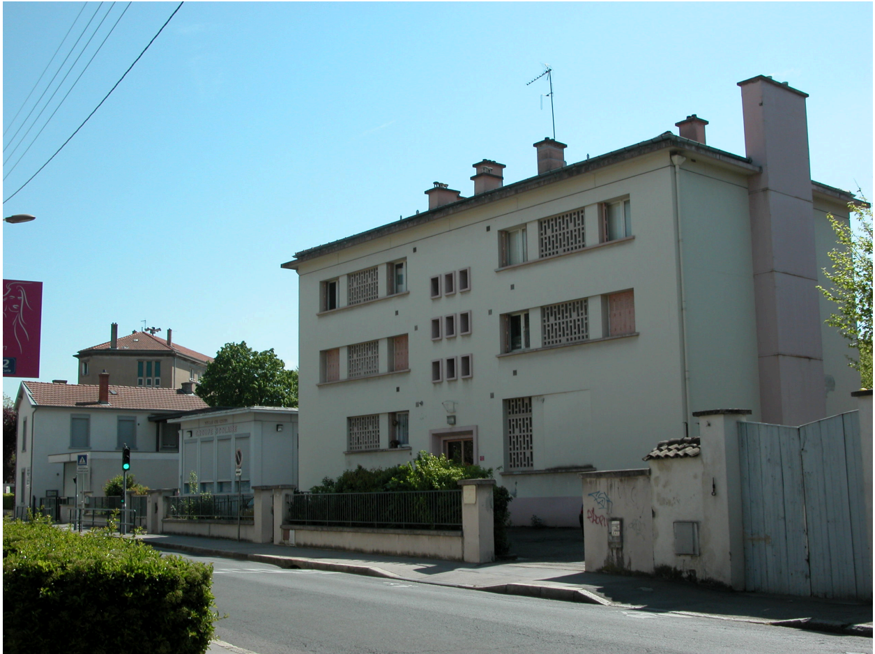
Vue de situation de la façade nord
