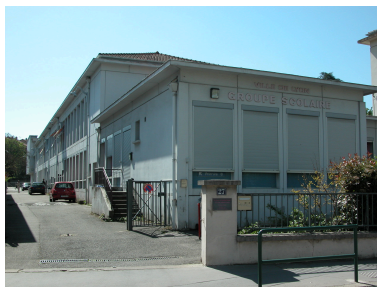
Vue d'ensemble de la façade nord Phot. Magali Delavenne IVR82_20146902581NUCA
