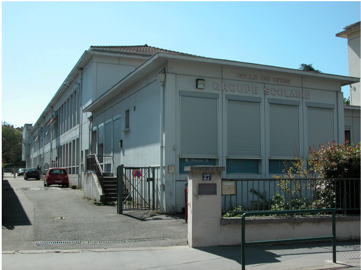
Vue d'ensemble de la façade nord
