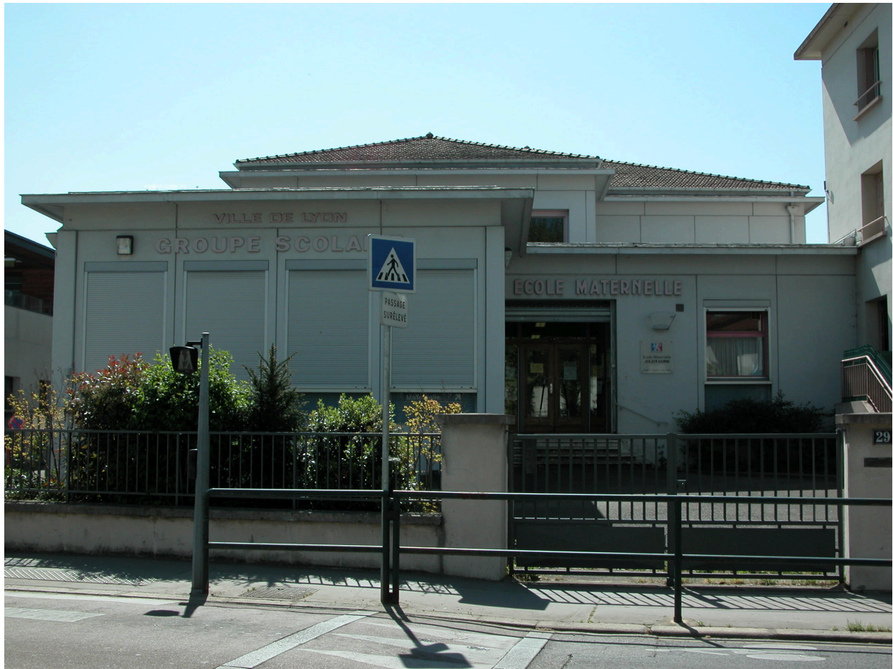
Vue partielle de la façade nord
