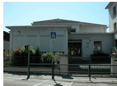
Vue partielle de la façade nord Phot. Magali Delavenne IVR82_20146902583NUCA
