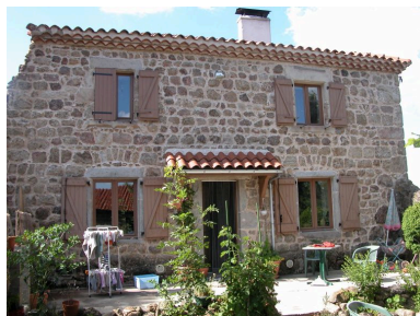
Vue générale Phot. Thierry Monnet IVR82_20124200664NUCA
