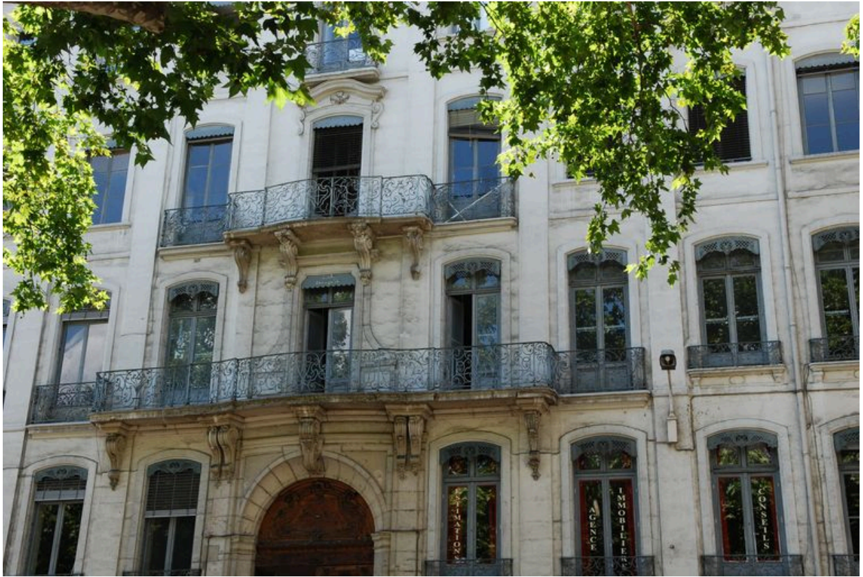
Détail de la façade.
