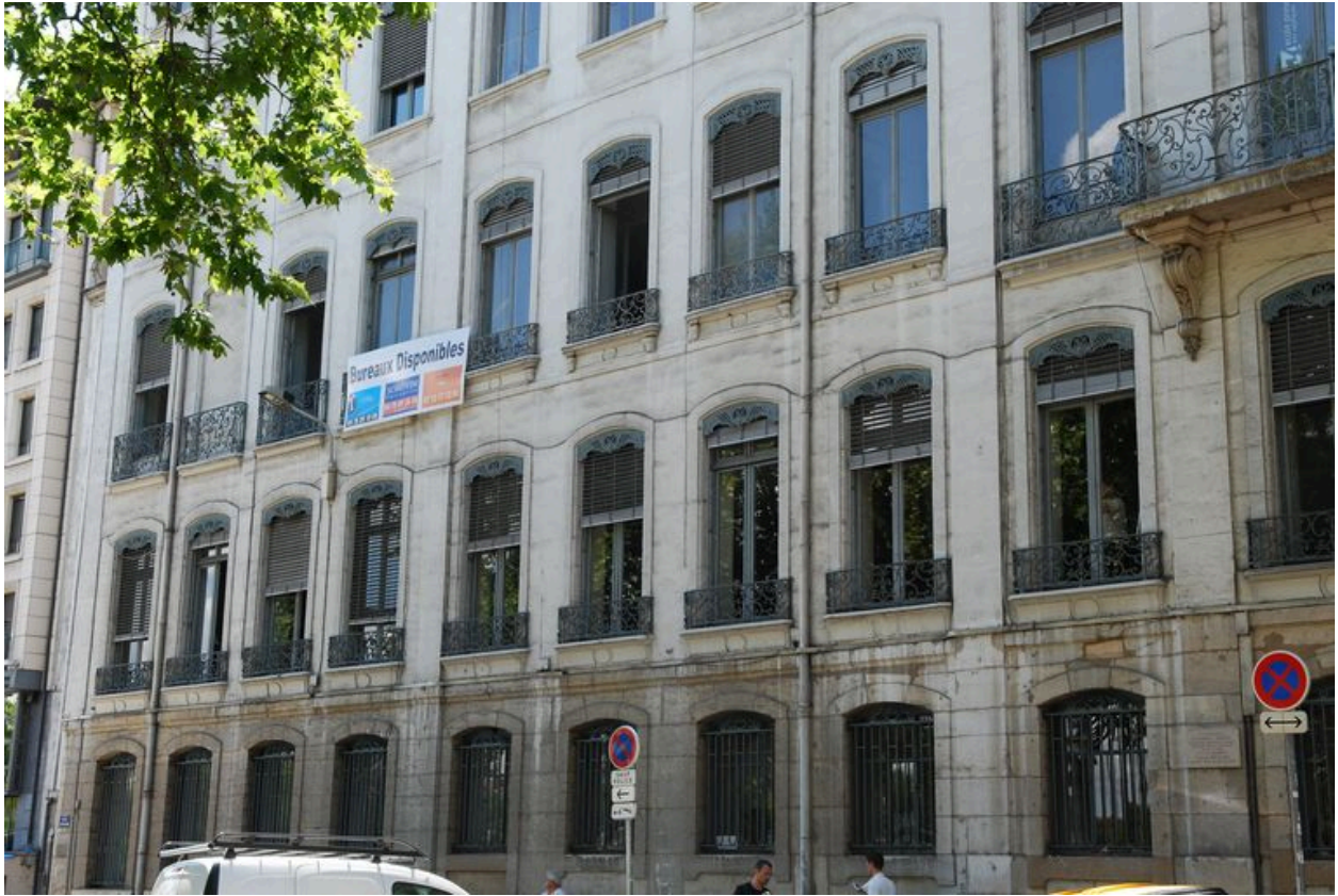
Détail de la façade.
