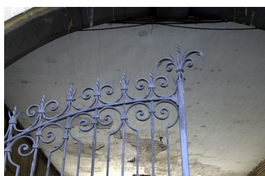
Grille fermant le passage cocher : partie supérieure Phot. Bernard Ducouret IVR82_20036903195NUCA
