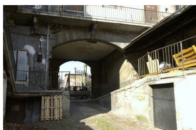
Le passage cocher et la rampe depuis la cour Phot. Bernard Ducouret IVR82_20036903198NUCA
