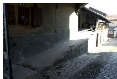
Passage cocher et rampe Phot. Bernard Ducouret IVR82_20036903197NUCA
