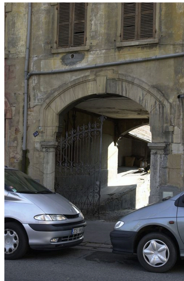
Détail du porche Phot. Bernard Ducouret IVR82_20036903194NUCA
