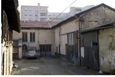
Dépendances situées en fond de cour Phot. Bernard Ducouret IVR82_20036903201NUCA
