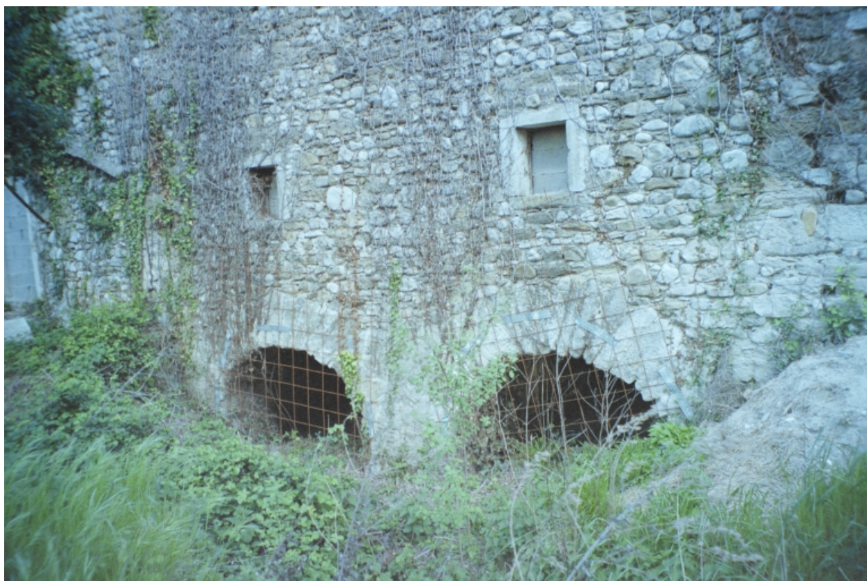
Elévation ouest, détail des arches ménagées sous le moulin, pour le canal d'amenée et de sortie de l'eau.
