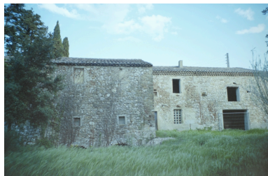
Vue d'ensemble du bâtiment, élévations ouest. Phot. Geneviève Jourdan IVR82_20062600062ZE
