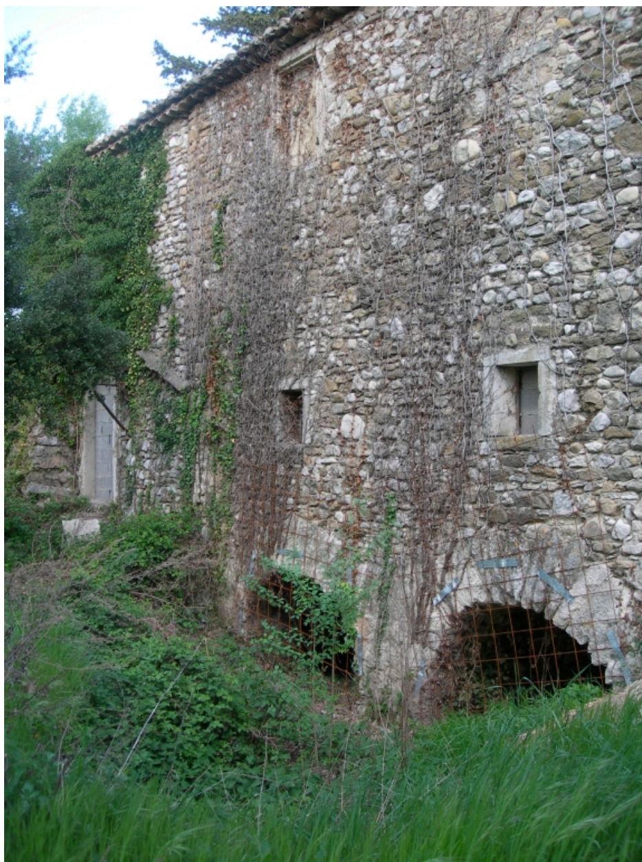
Elévation ouest, vue prise du sud, montrant les arches à la base du moulin.
