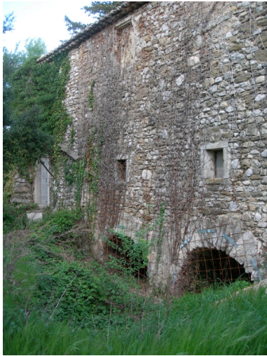
Elévation ouest, vue prise du sud, montrant les arches à la base du moulin. Phot. Annie Tosi-Remy IVR82_20062600067NUCA
