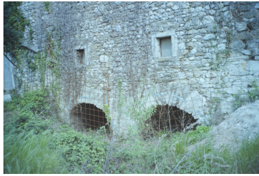
Elévation ouest, détail des arches ménagées sous le moulin, pour le canal d'amenée et de sortie de l'eau. Phot. Geneviève Jourdan IVR82_20062600063ZE
