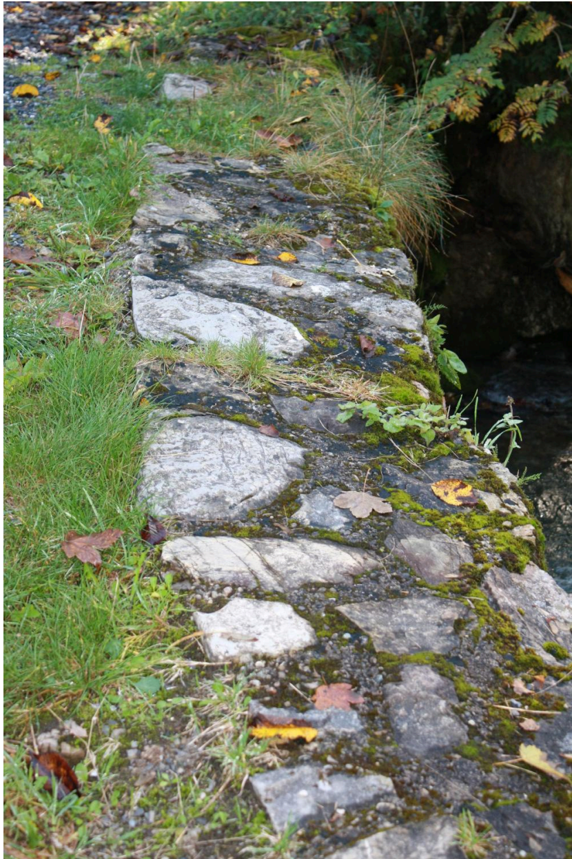
Pont d'Ardent, chaussée et plinthe
