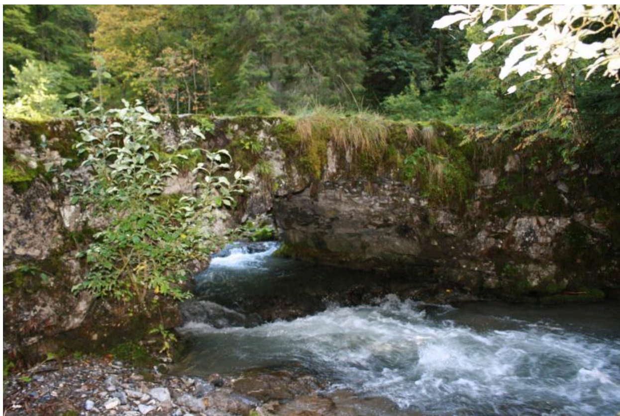
Pont d'Ardent, face aval
