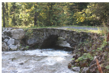
Pont d'Ardent, face amont Phot. Benoît Huraut IVR84_20197401259NUCA
