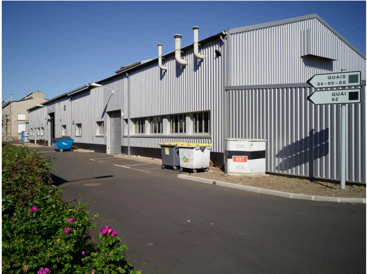
Le bâtiment W5 sur la rue de Jumeaux, depuis l'est.
