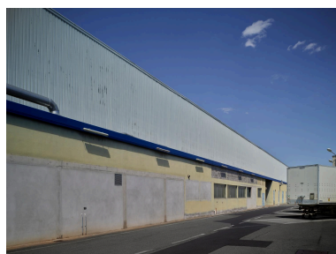
Une partie de l'élévation sud du bâtiment J62, sur le cours de Jussat. Phot. Christian Parisey IVR84_20226301565NUCA
