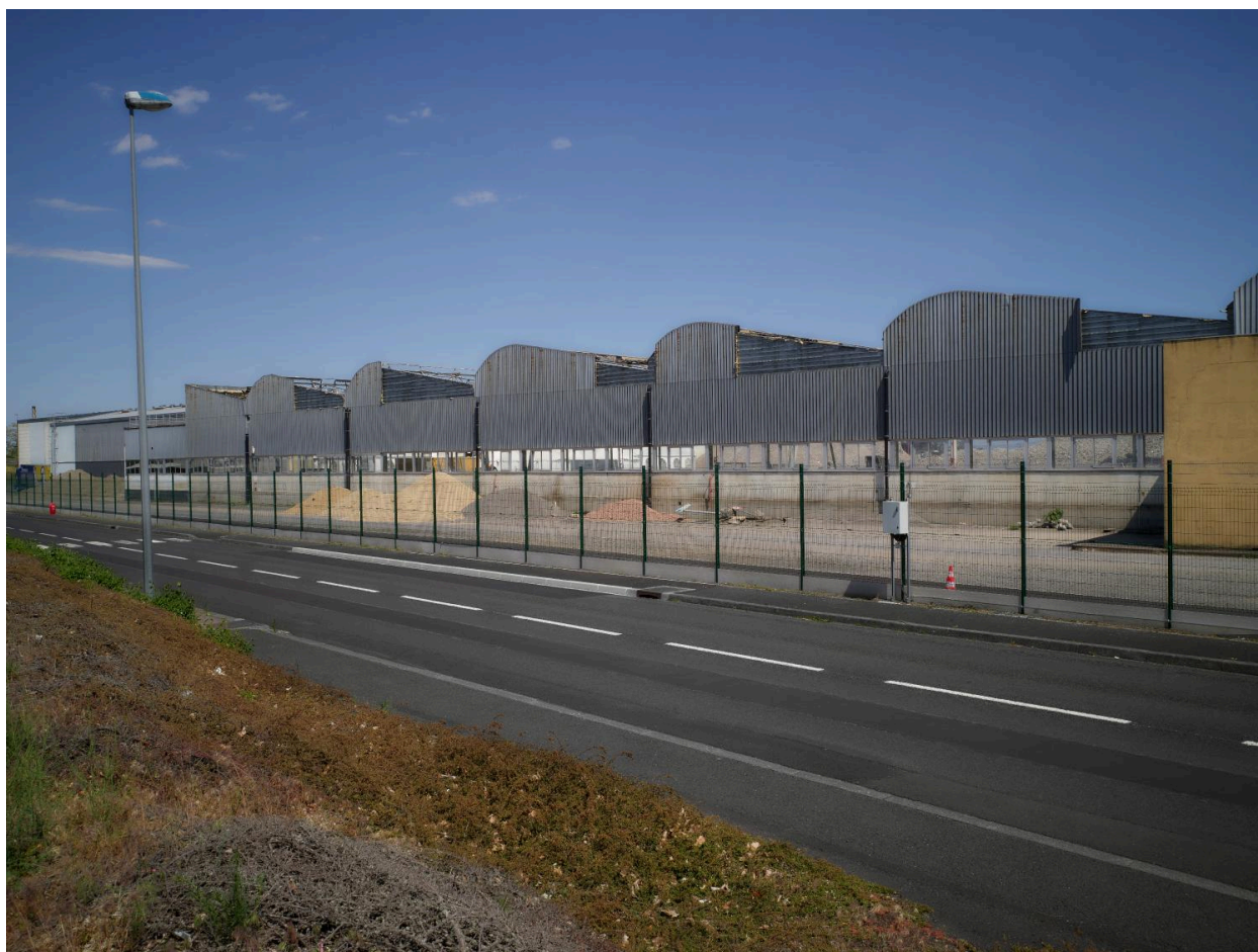
Anciens bâtiments DL1 de l'usine, rue de Randan. Vendus par Michelin en 2021, ils sont en cours de destruction.
