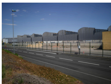
Anciens bâtiments DL1 de l'usine, rue de Randan. Vendus par Michelin en 2021, ils sont en cours de destruction. Phot. Christian Parisey IVR84_20226301567NUCA
