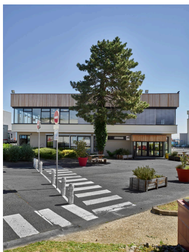
Le restaurant d'entreprise S60, depuis l'ouest. Phot. Christian Parisey IVR84_20226301559NUCA
