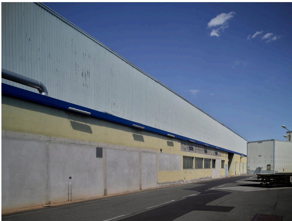
Une partie de l'élévation sud du bâtiment J62, sur le cours de Jussat.
