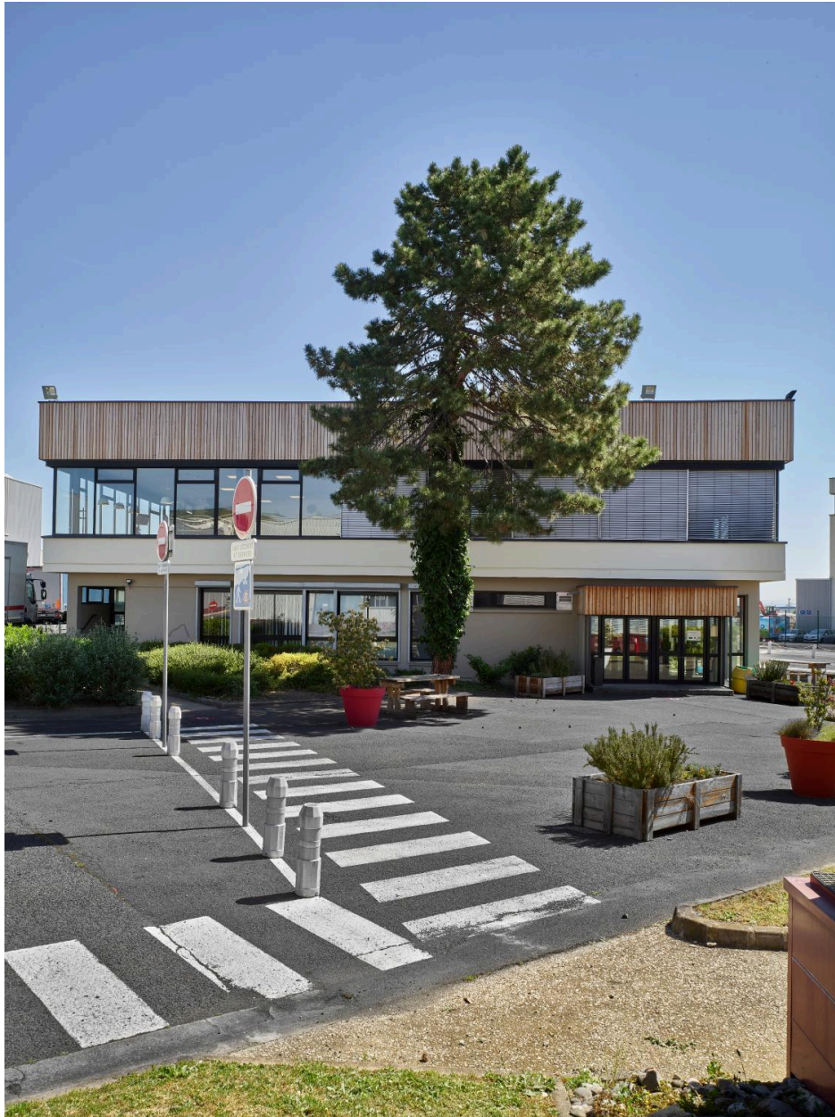
Le restaurant d'entreprise S60, depuis l'ouest.
