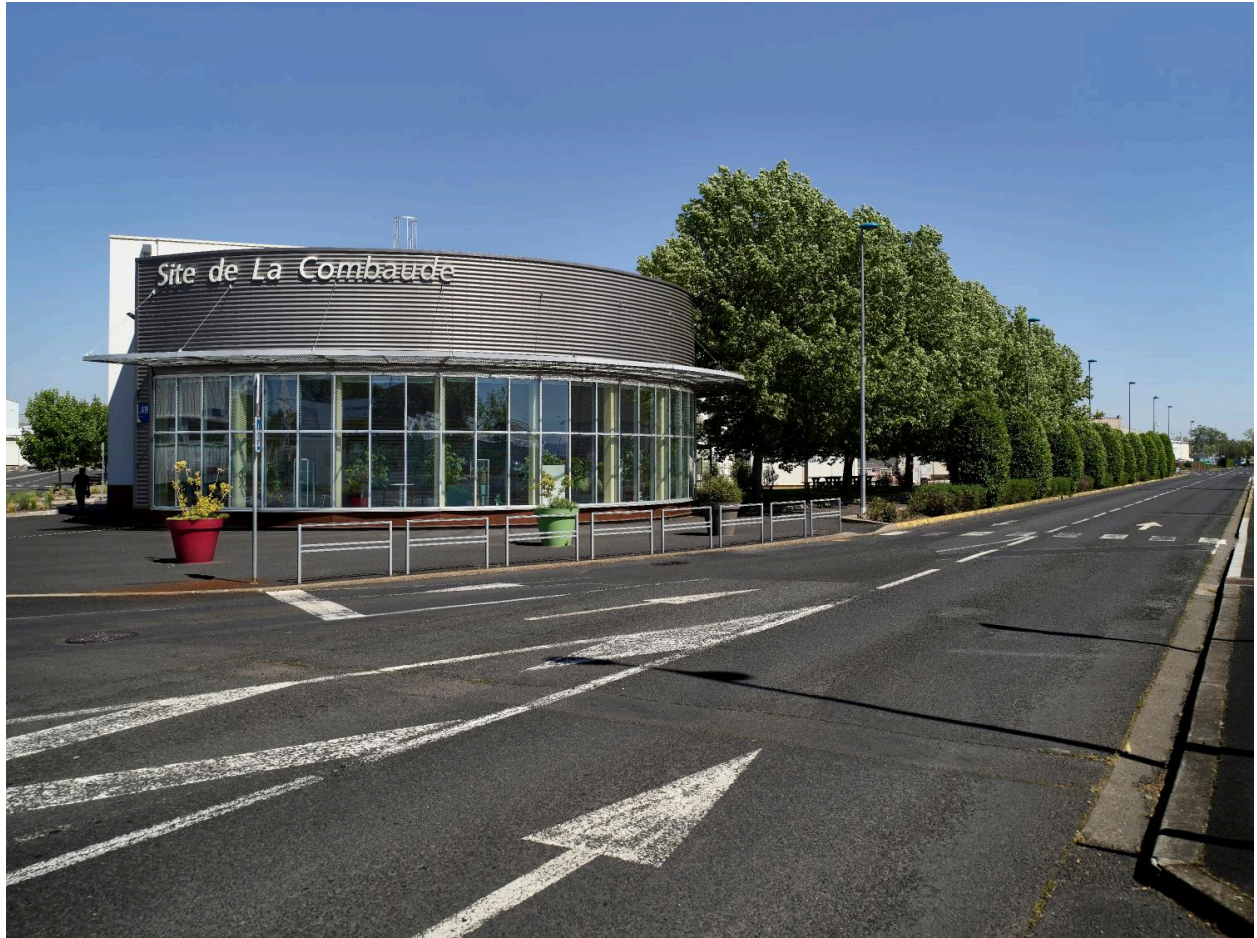
Bâtiment du Forum A19, à l'entrée du site, à l'angle des rues de Gerzat et de Joze.
