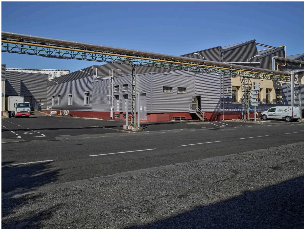
Vue partielle du bâtiment Z24 (partie nord-est) depuis la rue de Joze. Au premier plan, une passerelle technique.
