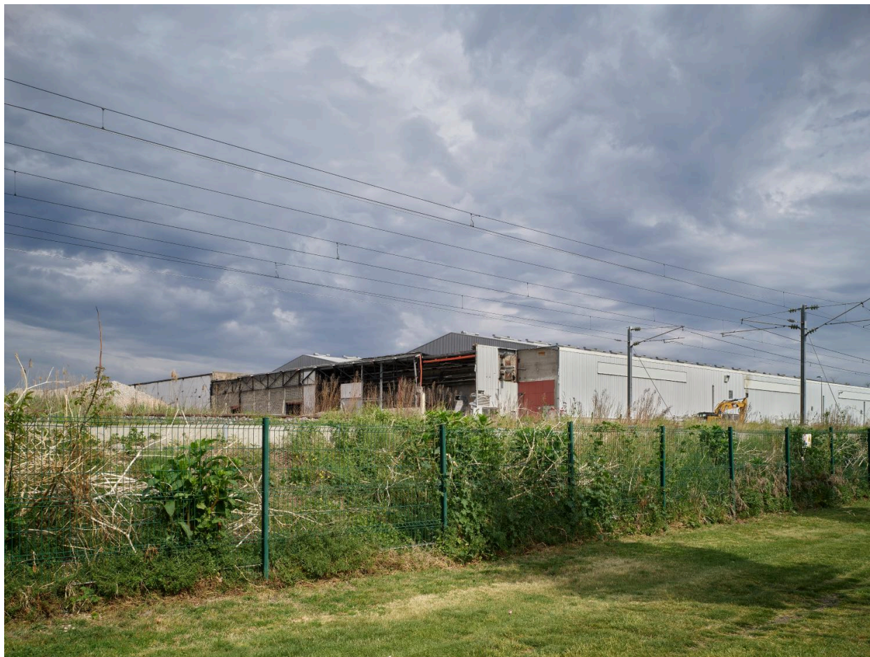
Anciens bâtiments de TV36, depuis le sud-est. Vendus en 2021, ils sont désormais en cours de démolition.
