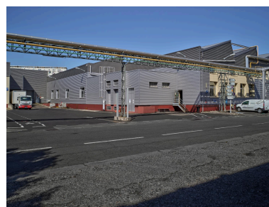
Vue partielle du bâtiment Z24 (partie nord-est) depuis la rue de Joze. Au premier plan, une passerelle technique. Phot. Christian Parisey IVR84_20226301554NUCA
