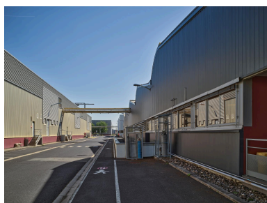
Les bâtiments Z24 et Y6, de part et d'autre de la rue de Job, depuis l'ouest. Phot. Christian Parisey IVR84_20226301551NUCA
