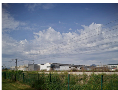
Anciens bâtiments de T53, depuis le nord-est. Vendus en 2021 par Michelin, ils sont désormais en cours de démolition. Phot. Christian Parisey IVR84_20226301568NUCA
