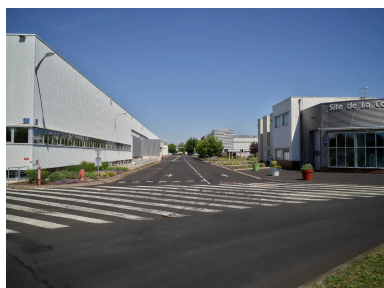
La rue de Joze, axe central du site, en direction du nord. De part et d'autre, les bâtiments Y7 et A19 (Forum). Phot. Christian Parisey IVR84_20226301563NUCA
