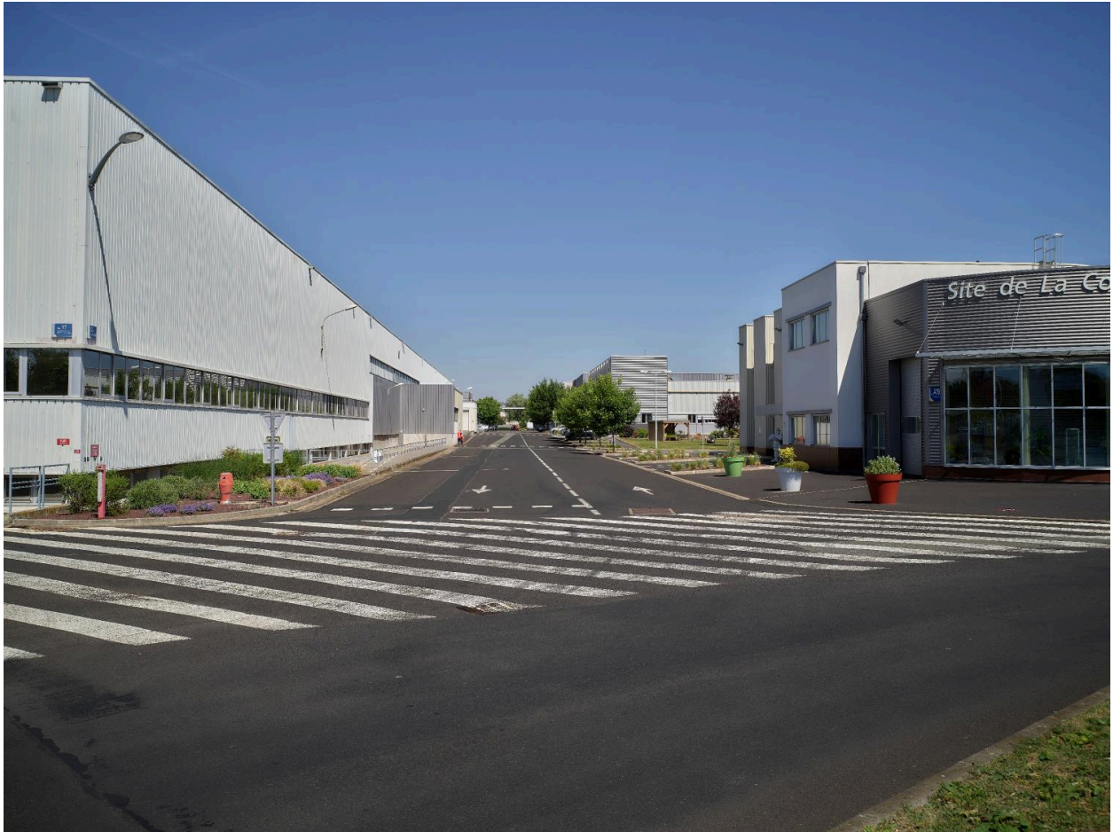
La rue de Joze, axe central du site, en direction du nord. De part et d'autre, les bâtiments Y7 et A19 (Forum).
