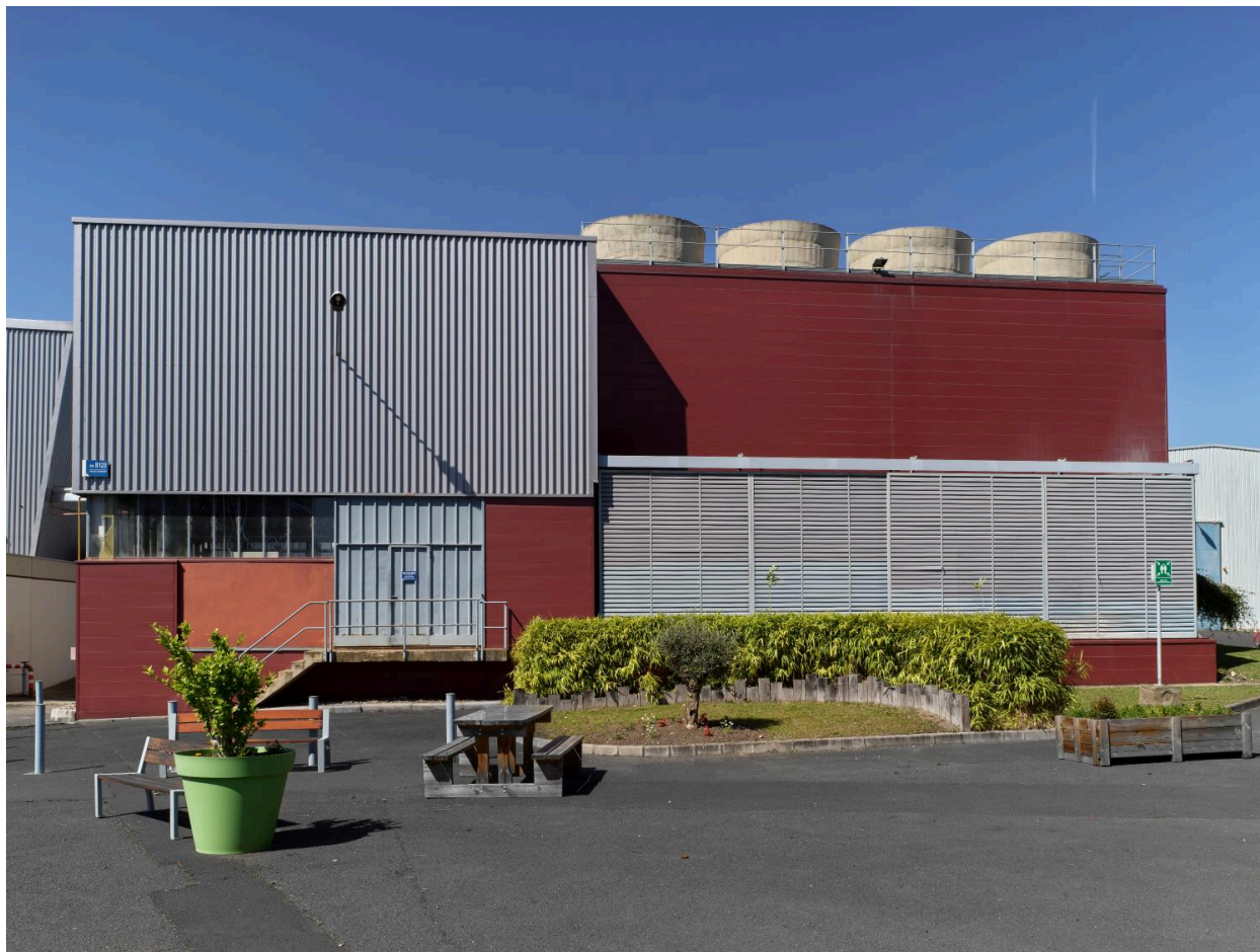
Le bâtiment B123 et ses tours réfrigérantes.
