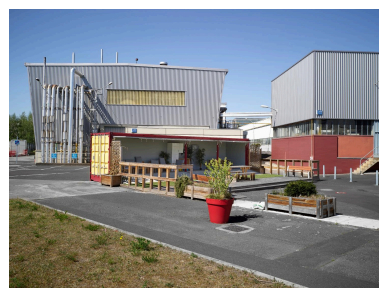
La chaufferie B112, côté est. Phot. Christian Parisey IVR84_20226301558NUCA
