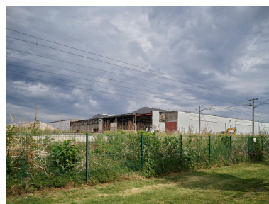
Anciens bâtiments de TV36, depuis le sud-est. Vendus en 2021, ils sont désormais en cours de démolition. Phot. Christian Parisey IVR84_20226301569NUCA
