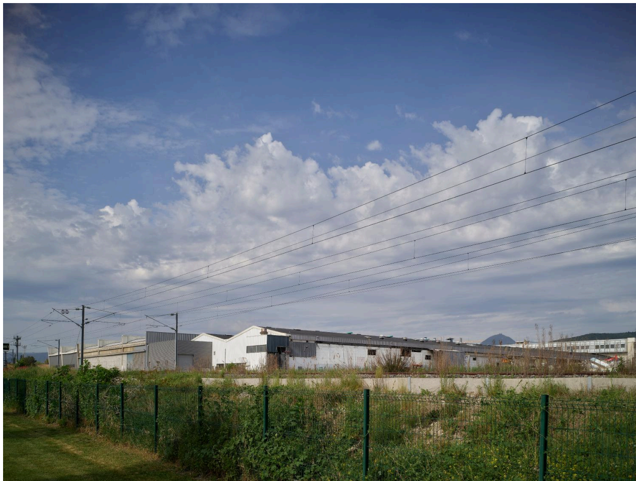
Anciens bâtiments de T53, depuis le nord-est. Vendus en 2021 par Michelin, ils sont désormais en cours de démolition.
