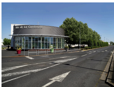
Bâtiment du Forum A19, à l'entrée du site, à l'angle des rues de Gerzat et de Joze. Phot. Christian Parisey IVR84_20226301562NUCA
