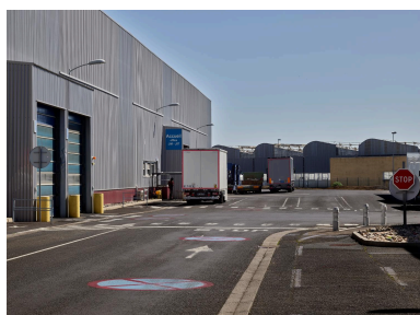
Extrémité du bâtiment J57, depuis le sud-ouest. À l'arrière-plan, une partie de l'ancien bâtiment D2, aujourd'hui vendu. Phot. Christian Parisey IVR84_20226301556NUCA
