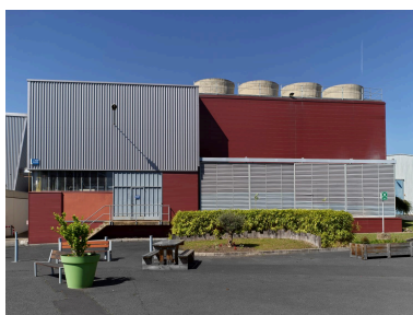
Le bâtiment B123 et ses tours réfrigérantes. Phot. Christian Parisey IVR84_20226301557NUCA
