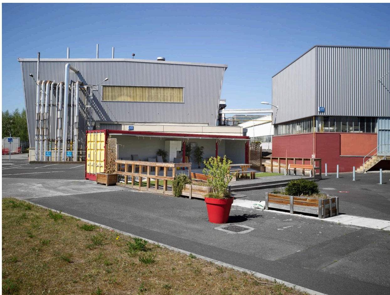
La chaufferie B112, côté est.
