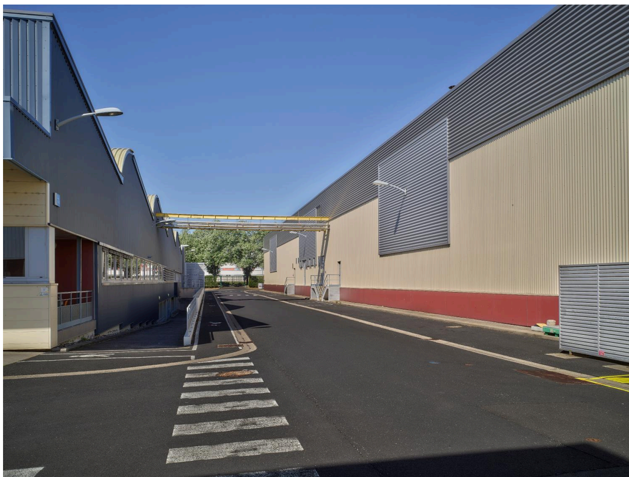
Les bâtiments Y6 et Z24, de part et d'autre de la rue de Job, depuis l'est.
