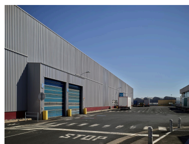
Le bâtiment J57, sur la rue de Jassy, depuis le sud-ouest. Phot. Christian Parisey IVR84_20226301555NUCA
