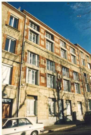
Façade principale Phot. Cendrine Sanquer IVR82_19974201861ZE
