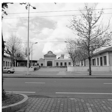
Vue d'ensemble nord Phot. Martial Couderette IVR82_20016900562X
