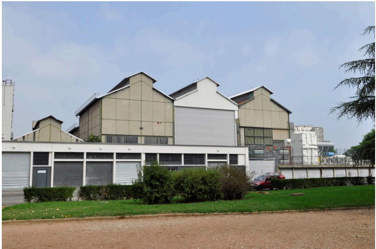
Vue sud du site
