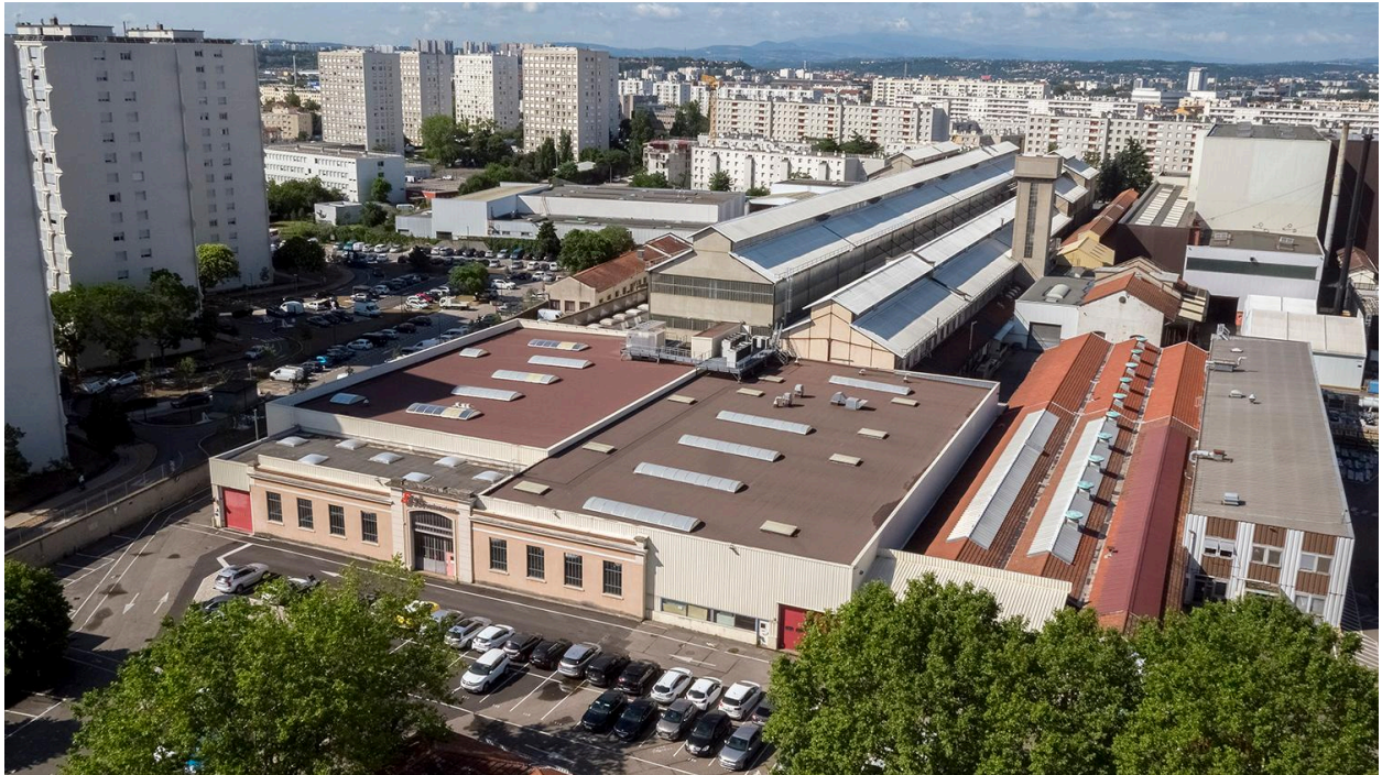
Vue d'ensemble est du site (drone)
