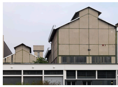
Détail ossature métallique Phot. Eric Dessert IVR82_20096905640NUCA
