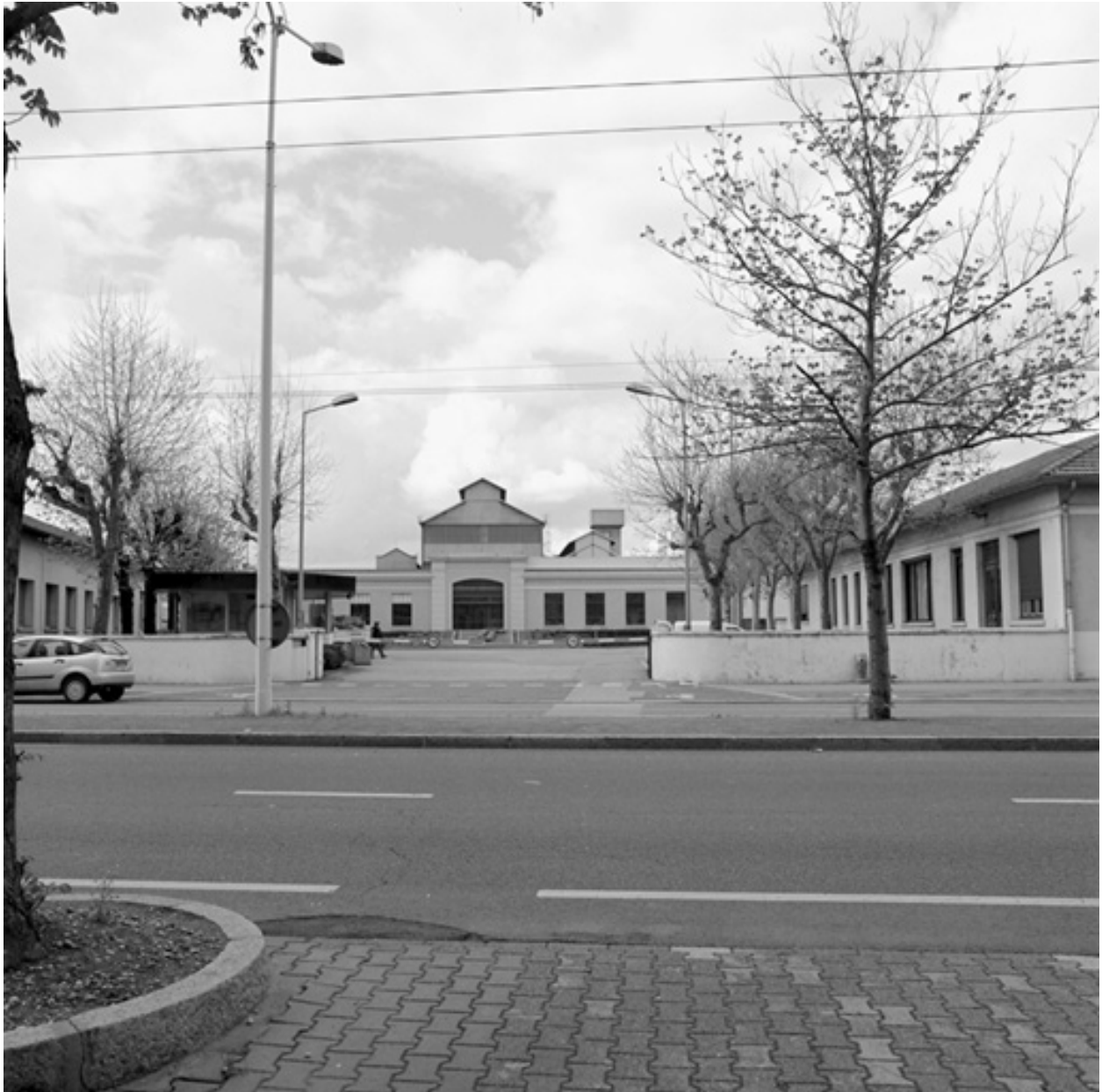
Vue d'ensemble nord
