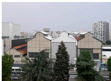
Vue sud-ouest du site : grandes halles Phot. Eric Dessert IVR82_20096905643NUCA
