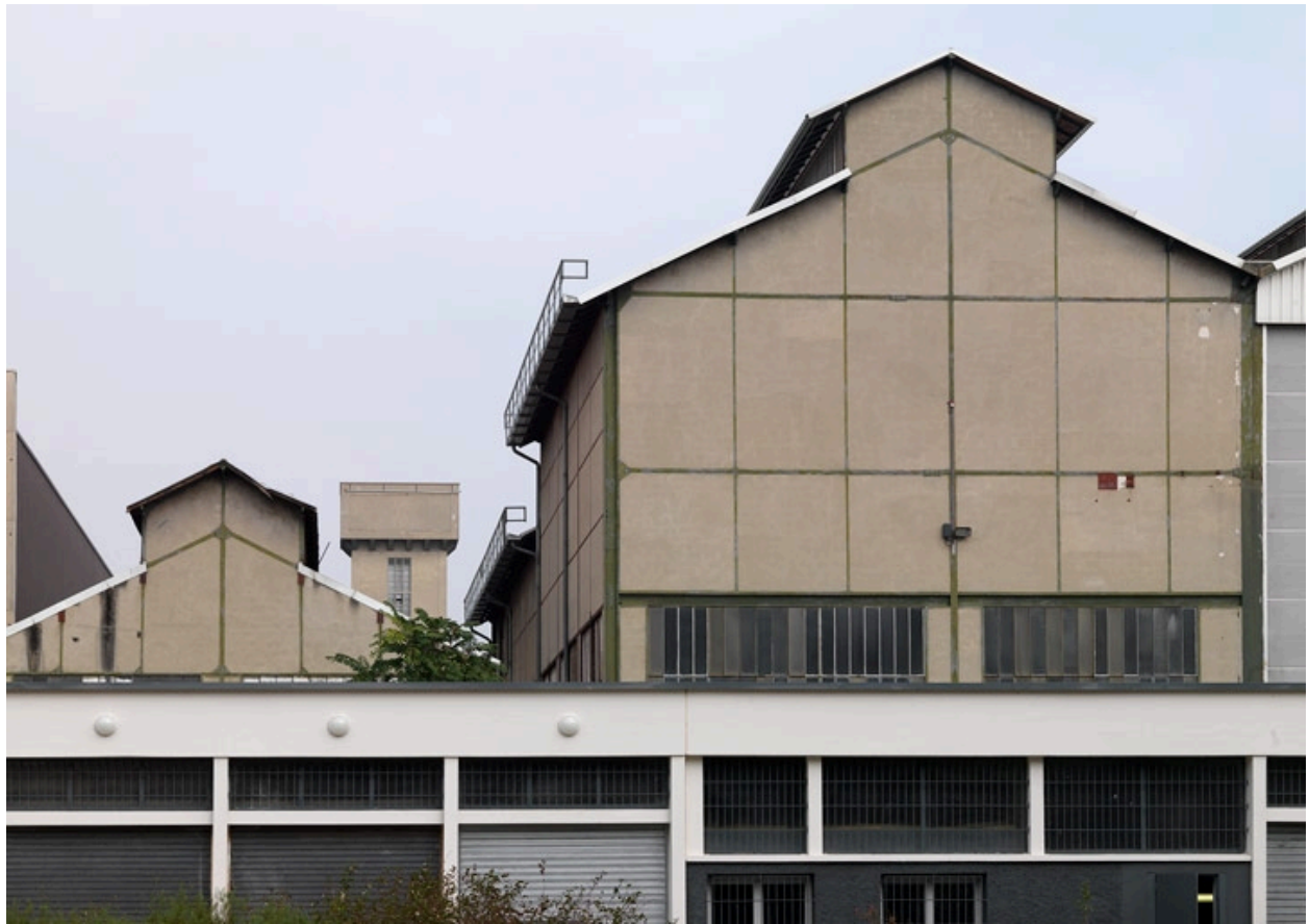
Détail ossature métallique
