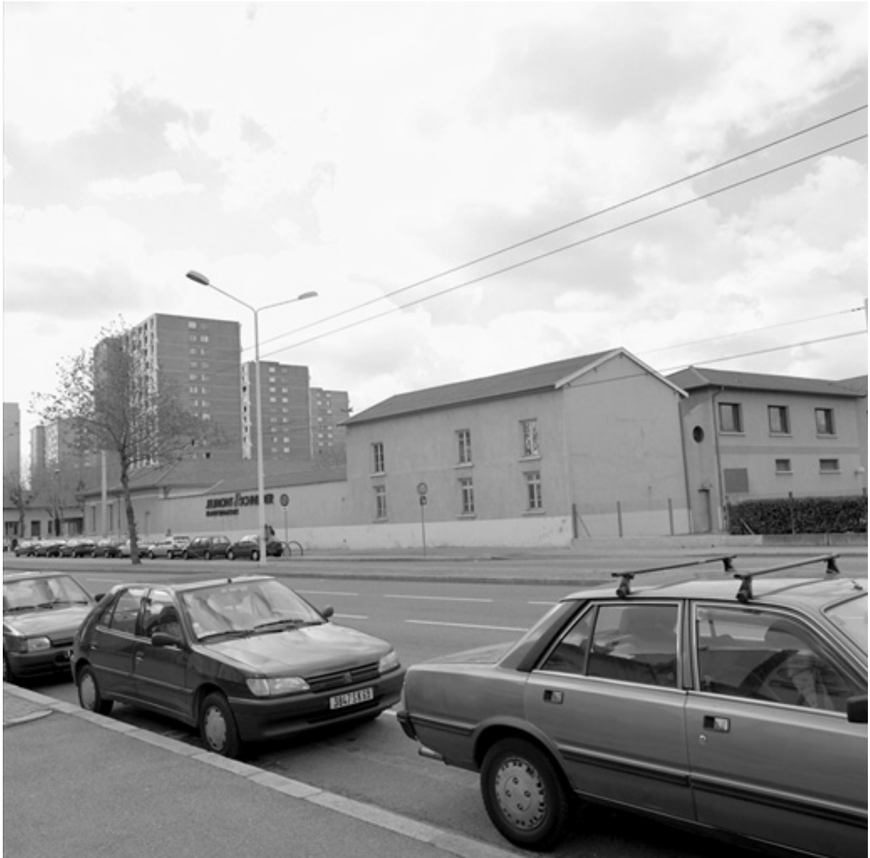
Vue d'ensemble ouest
