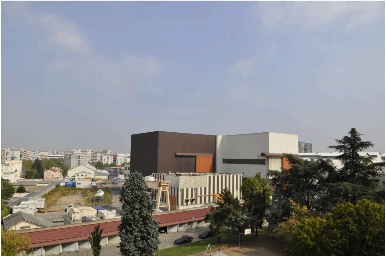
Vue des structures en bardage au nord
