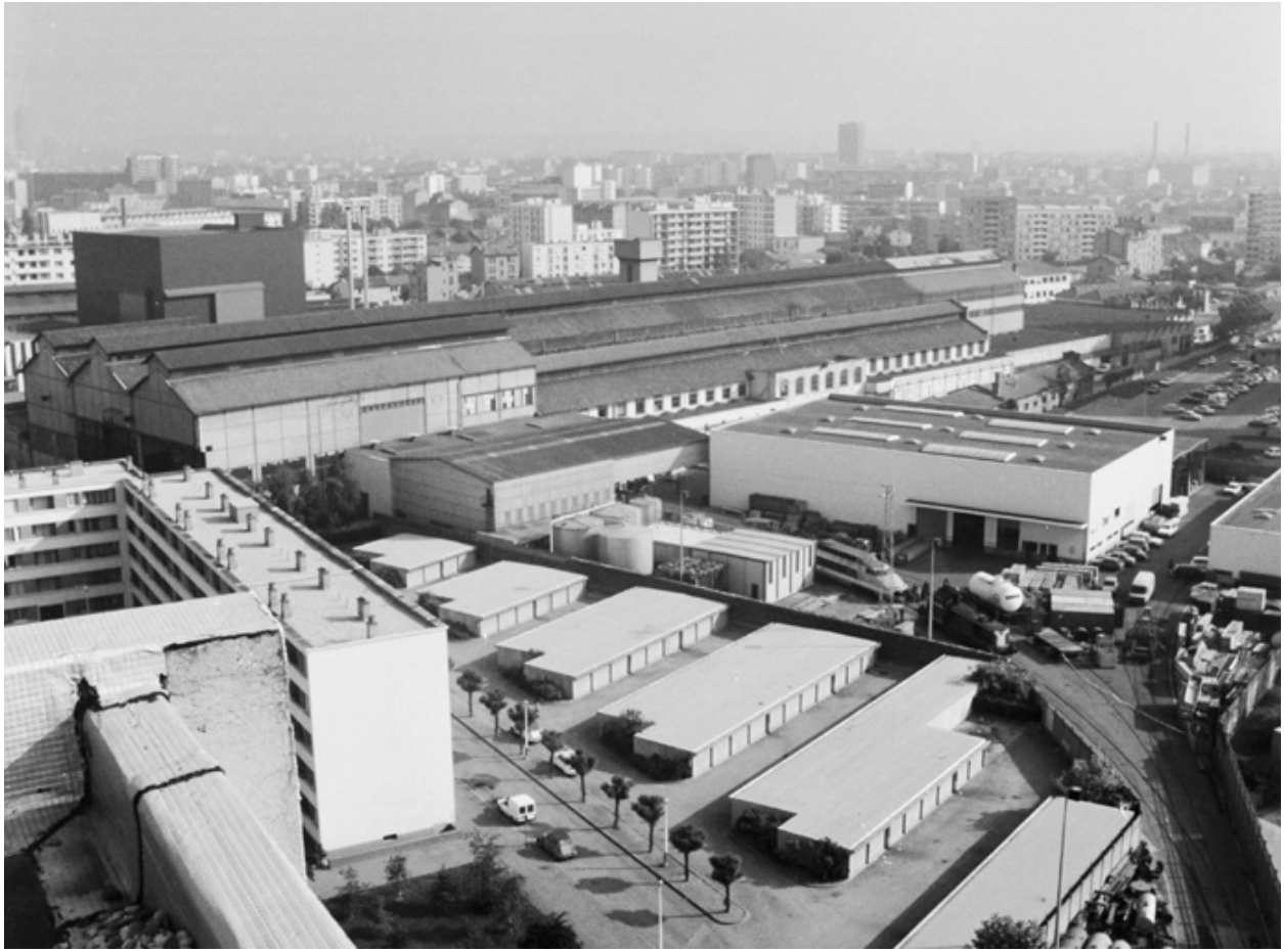
Vue sud, sortie SNCF
