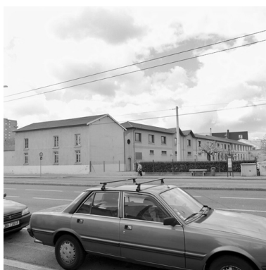
Vue nord-est Phot. Martial Couderette IVR82_20016900563X
