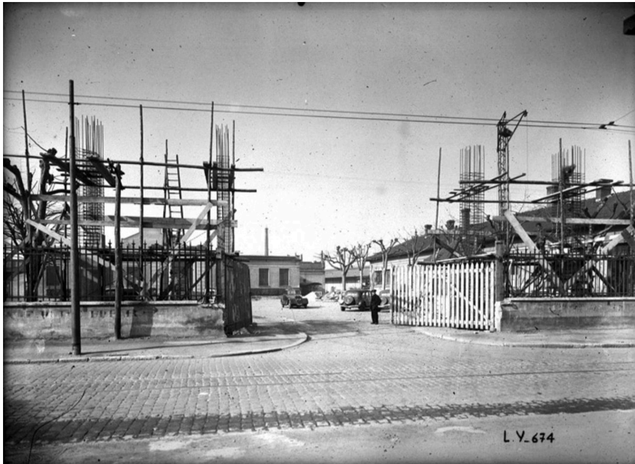
Vidéralp 1932, entrée en construction. Collection Sylvestre BM Lyon. 10392
