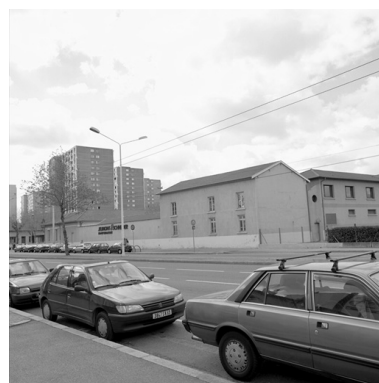
Vue d'ensemble ouest Phot. Martial Couderette IVR82_20016900564X
