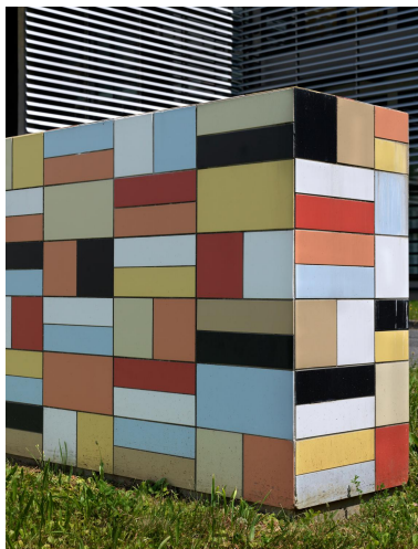
Élément 6, détail. Phot. Thierry Leroy IVR84_20207300854NUCA
