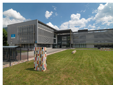
Éléments 2, 1, 5 et revêtement de sol. Phot. Thierry Leroy IVR84_20207300849NUCAQ
