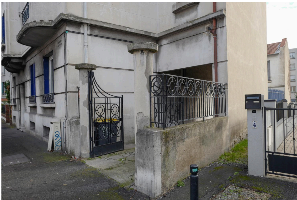
Portail d'entrée du passage desservant l'arrière cour
