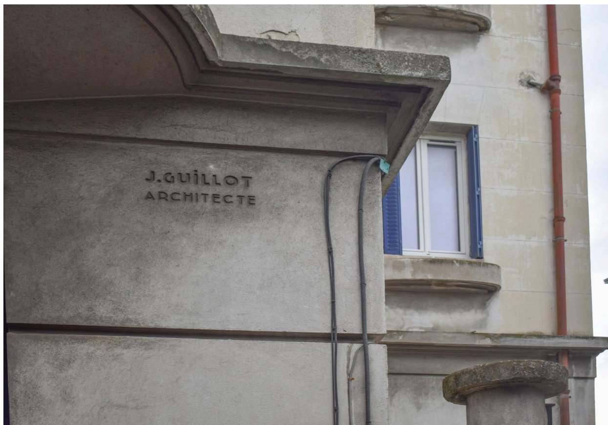
Signature Jean Guillot, angle rez-de-chaussée
