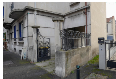
Portail d'entrée du passage desservant l'arrière cour Phot. François-Nicolas L'Hardy IVR84_20256300205NUCA
