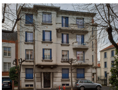
Façade sur le boulevard Jean-Jaurès Phot. Christian Parisey IVR84_20256300400NUCA
