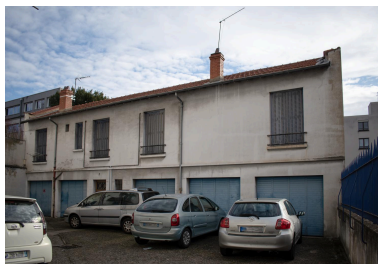
Maison en fond de cour, garages en rez-de-chaussée Phot. Félicie Fougère IVR84_20256300256NUCA
