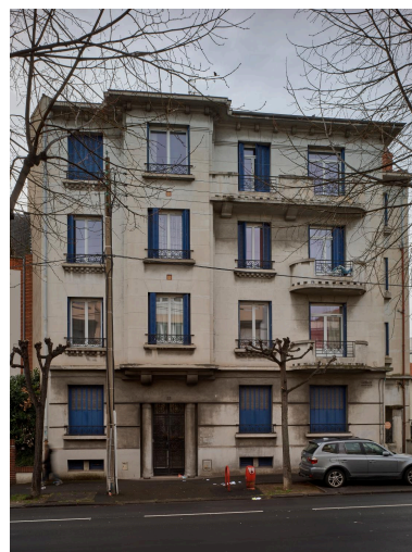
Façade sur le boulevard Jean-Jaurès Phot. Christian Parisey IVR84_20256300401NUCA
