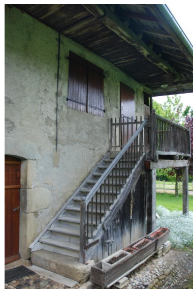
Détail de la partie habitation : escalier extérieur, calade. Phot. Thierry Monnet IVR84_20207400411NUCA
