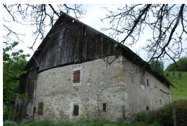
Vue de trois-quarts arrière depuis le nord-est. Phot. Thierry Monnet IVR84_20207400414NUCA
