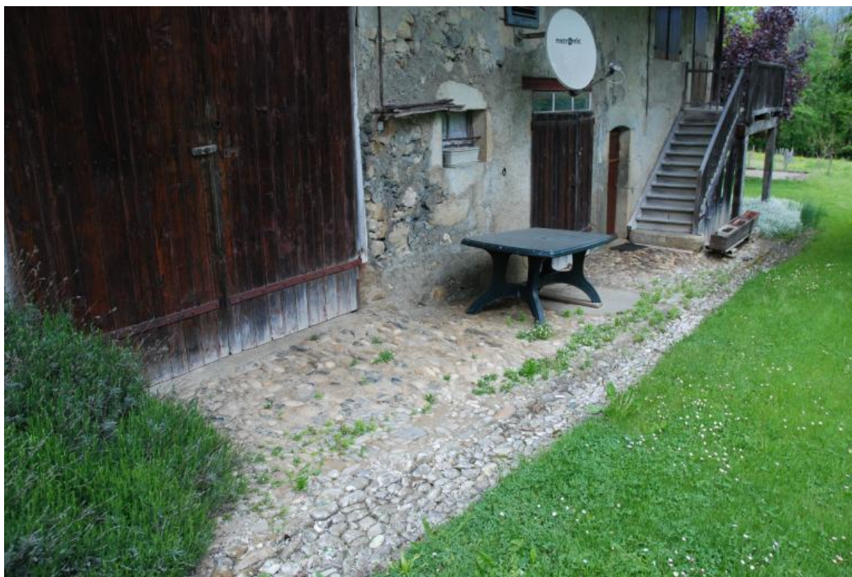
Façade principale : escalier extérieur, calade.
