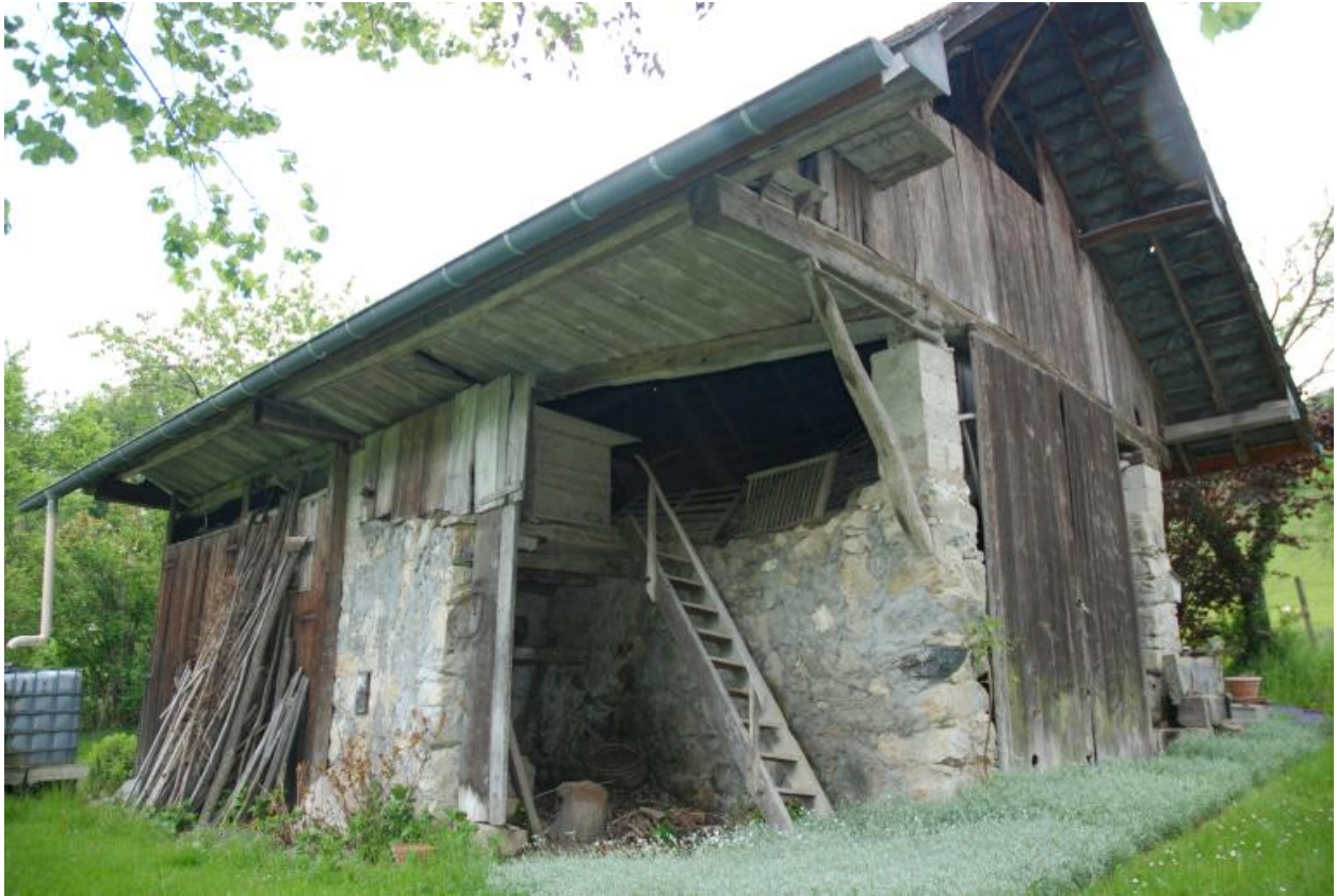
Vue du four à pain.
