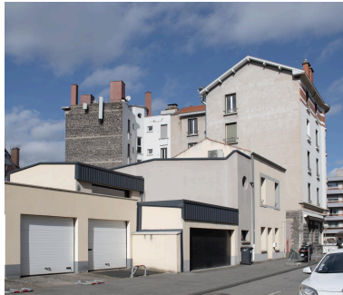
Élévations postérieures depuis la rue Gourgouillon Phot. Félicie Fougère IVR84_20256302353NUCA
