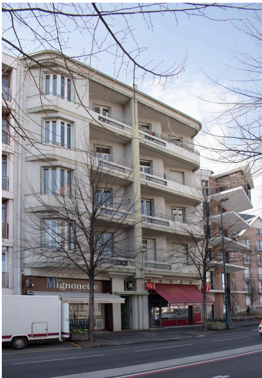
Façade du n°4 sur le boulevard Aristide-Briand (édifice de comparaison)
