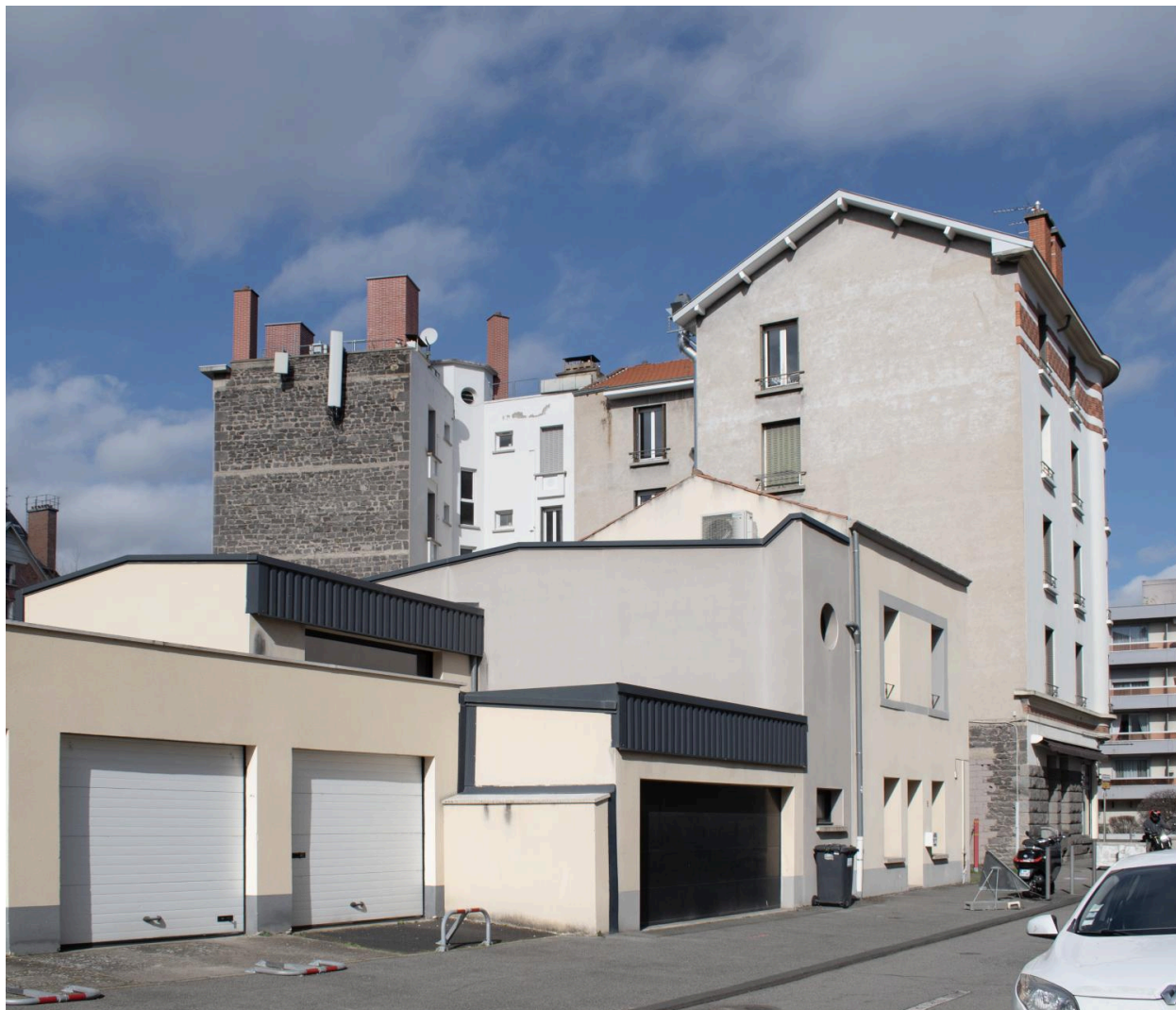
Élévations postérieures depuis la rue Gourgouillon
