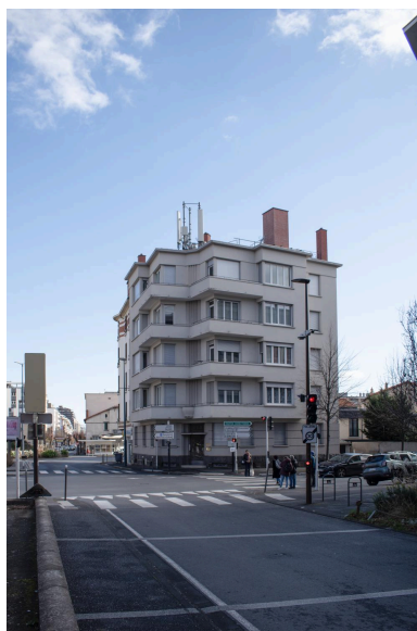
Elévation sur le boulevard Aristide-Briand Phot. Félicie Fougère IVR84_20256300780NUCA
