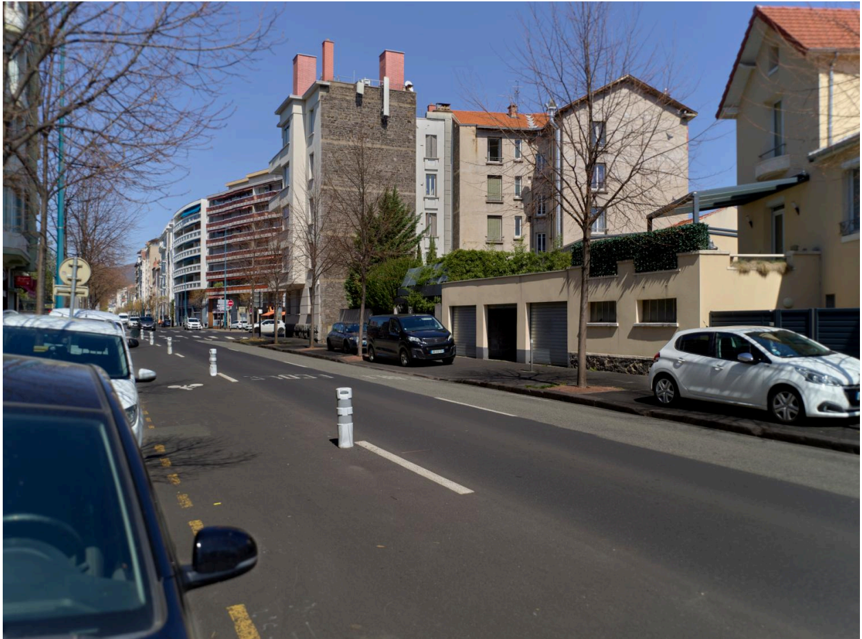
Rupture d'échelle et élévation aveugle
