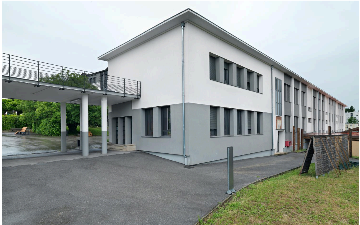
Tajana : bas-relief n°2 dans son environnement, au-dessus de la porte d'entrée du bâtiment
