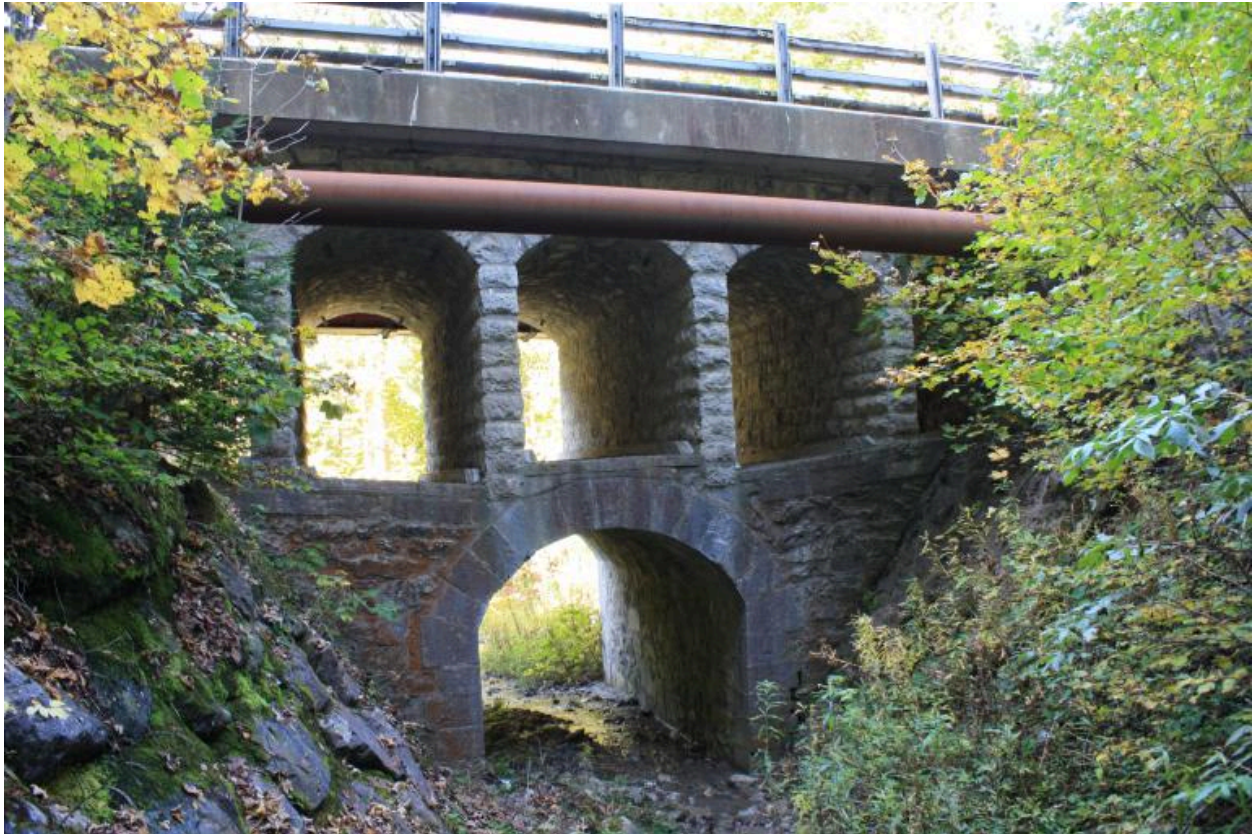
Pont des Ancarnes, face amont
