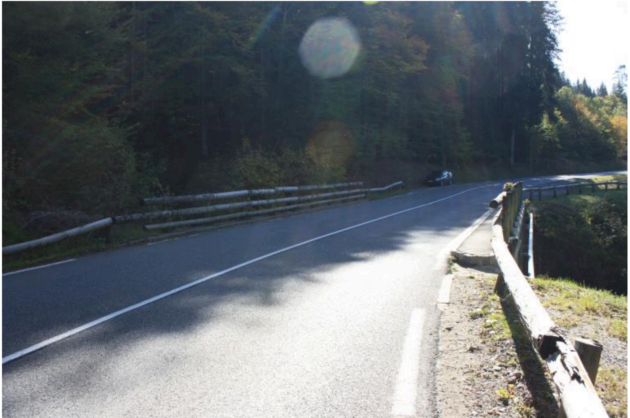
Pont des Ancarnes, chaussée et gardes-corps
