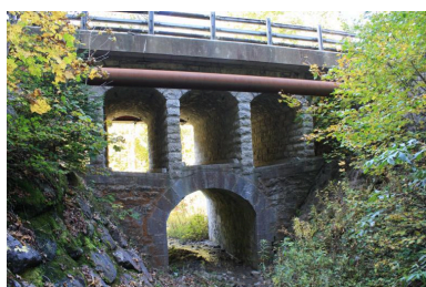
Pont des Ancarnes, face amont Phot. Benoît Huraut IVR84_20207401062NUCA
