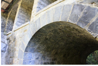
Pont des Ancarnes, détails bandeau et intrados Phot. Benoît Huraut IVR84_20207401065NUCA
