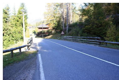
Pont des Ancarnes, contexte Phot. Benoît Huraut IVR84_20207401061NUCA
