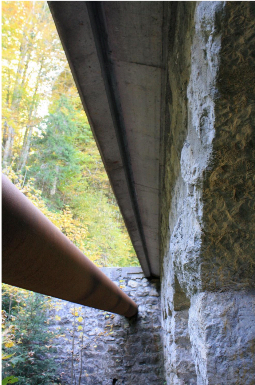
Pont des Ancarnes, détail encorbellement
