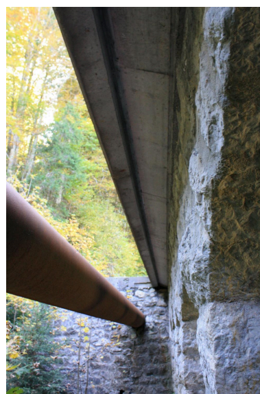
Pont des Ancarnes, détail encorbellement Phot. Benoît Huraut IVR84_20207401064NUCA
