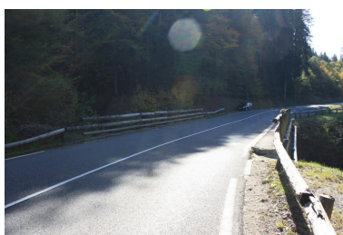
Pont des Ancarnes, chaussée et garde-corps Phot. Benoît Huraut IVR84_20207401063NUCA
