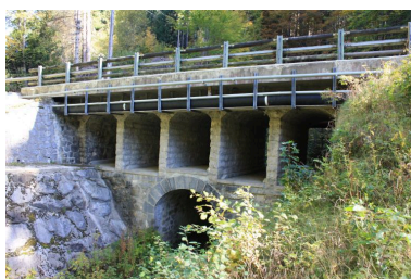
Pont des Ancarnes, face aval IVR84_20197401269NUCA
