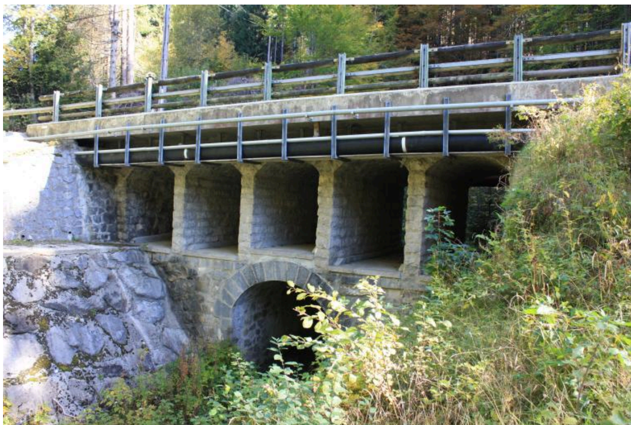
Pont des Arcanes, face aval
