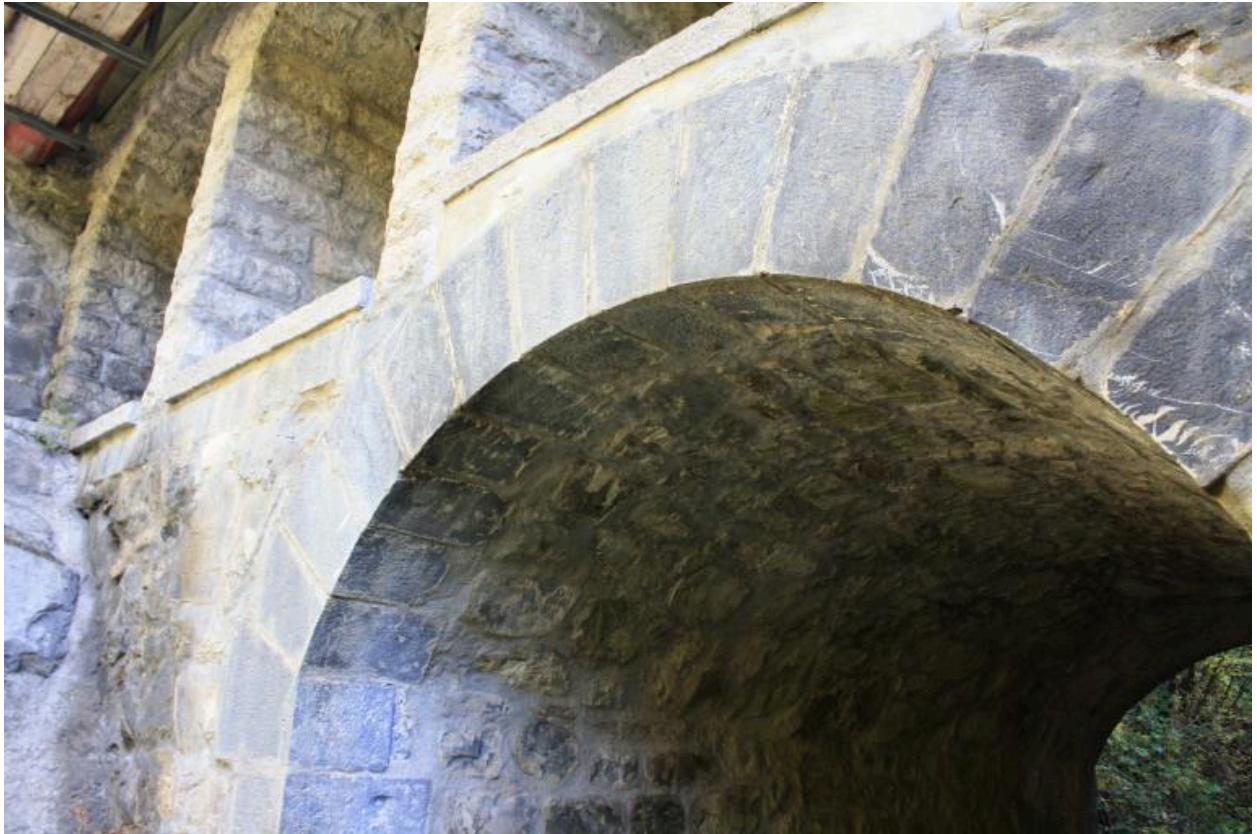
Pont des Ancarnes, détails bandeau et intrados
