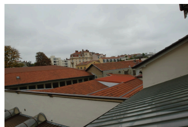
Détail toiture Phot. Nadine Halitim-Dubois IVR82_20096901603NUCA
