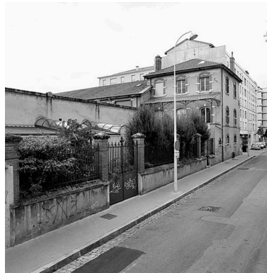
Vue d'ensemble sud est Phot. Didier Gourbin IVR82_20046902726X
