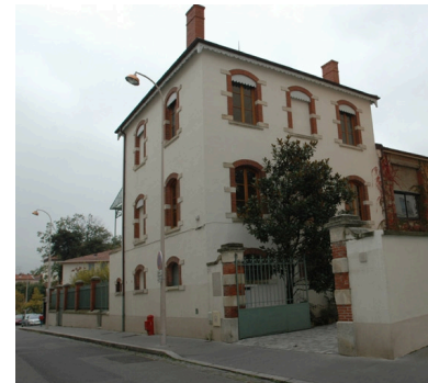
Vue ouest Phot. Nadine Halitim-Dubois IVR82_20096901593NUCA
