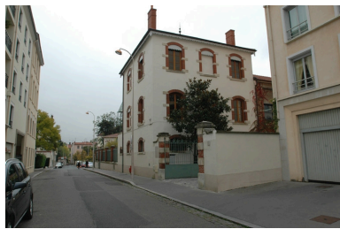
Vue ouest Phot. Nadine Halitim-Dubois IVR82_20096901594NUCA
