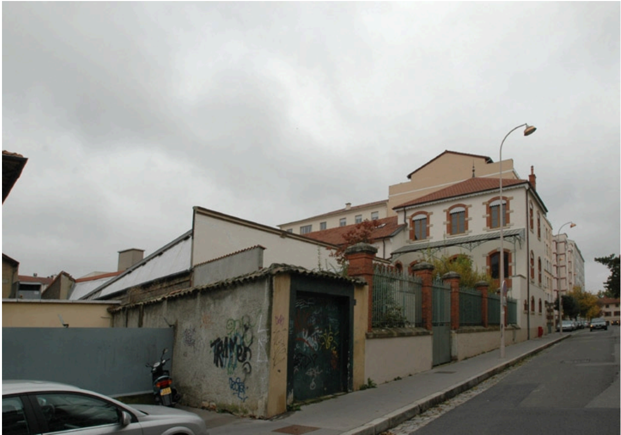
Vue d'ensemble est
