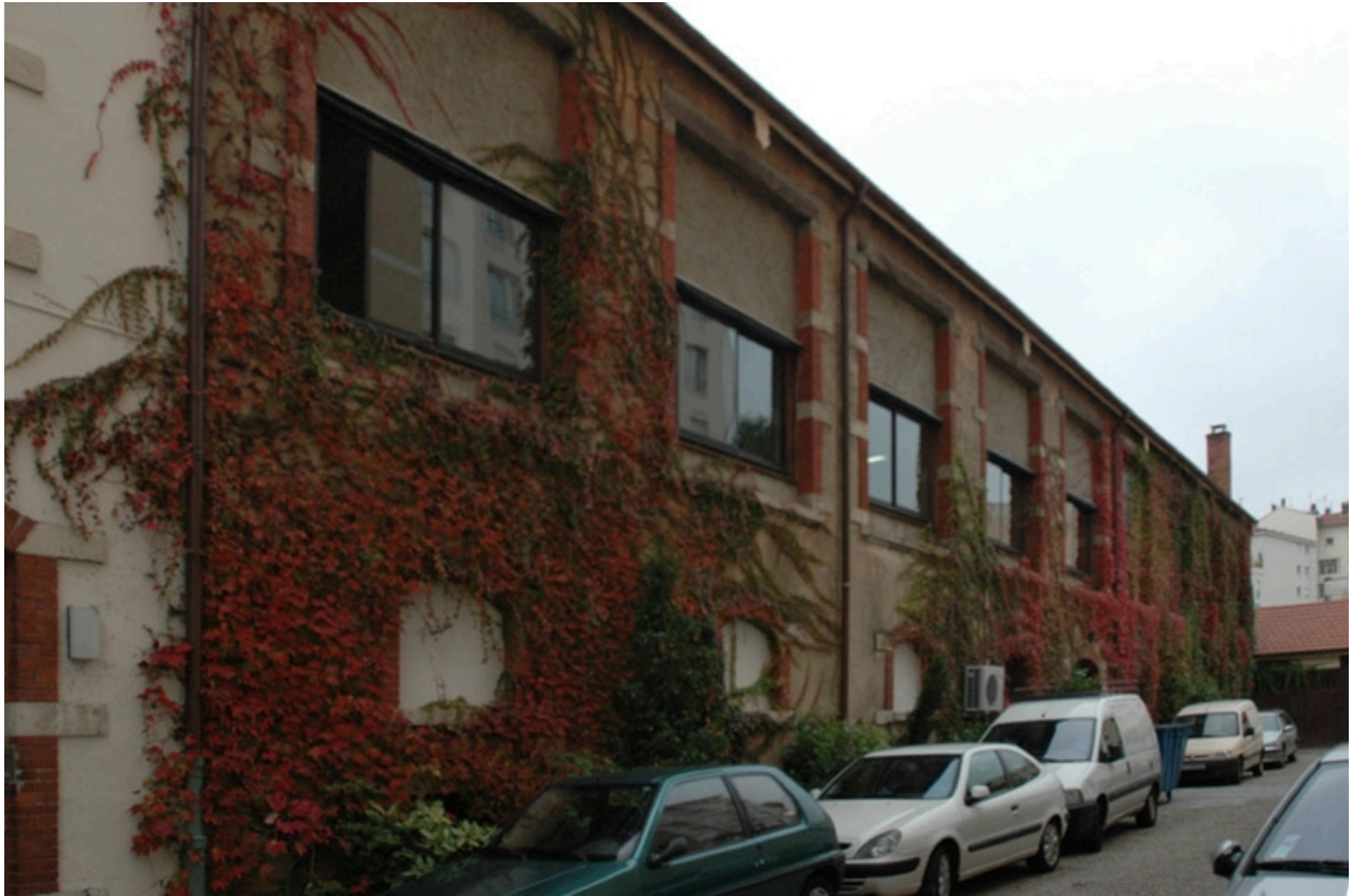
Bâtiment principal, vue nord
