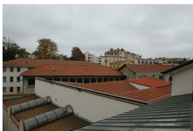
Vue des ateliers nord (extension de 1920) Phot. Nadine Halitim-Dubois IVR82_20096901601NUCA
