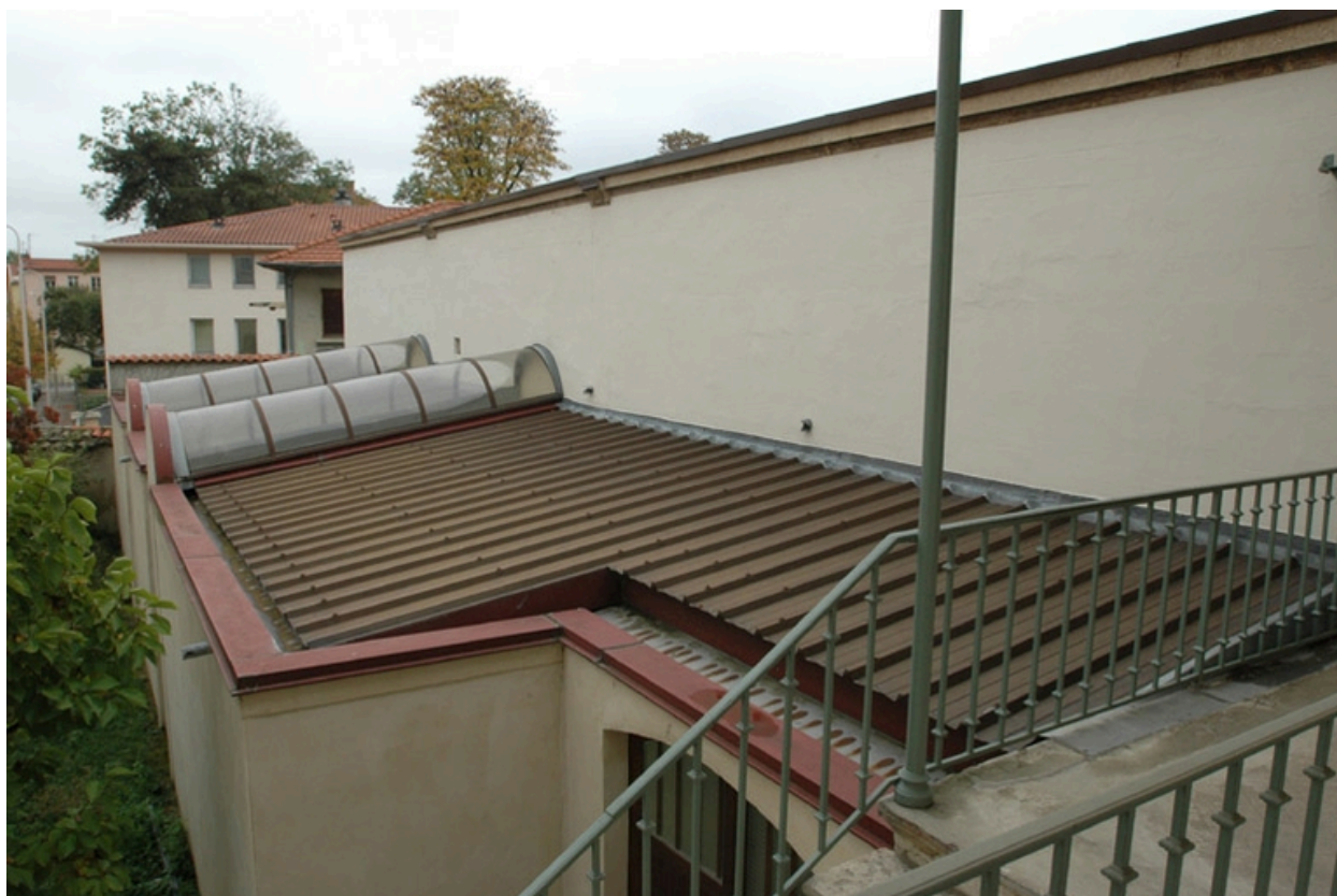
Extension nord détail lanterneau
