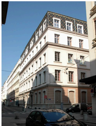
Vue générale Phot. Catherine Guégan IVR82_20086901488NUCA
