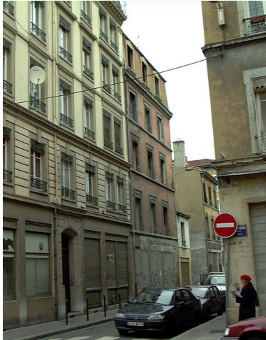
Vue générale depuis la rue Verlet-Hanus Phot. Véronique Belle IVR82_20006900506NUCA
