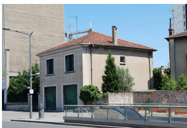
Elévations ouest et sud Phot. Véronique Belle IVR82_20096903475NUCA
